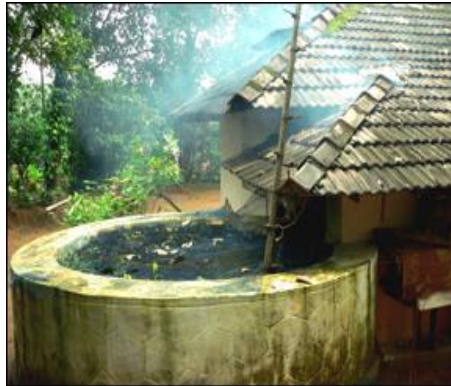
Figura 1. 14 Captación de agua pluvial India
