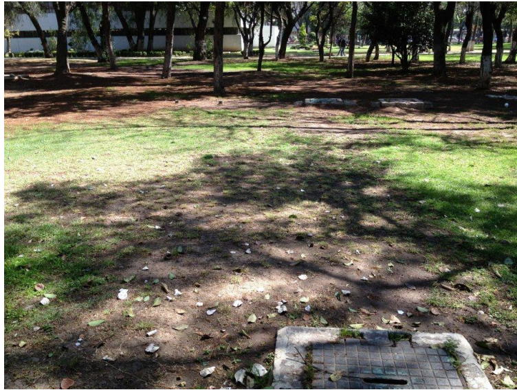
Figura 2. 21 Cisterna de almacenamiento
