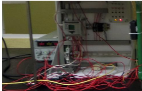
Figura 5. 5 Conexiones al PLC
