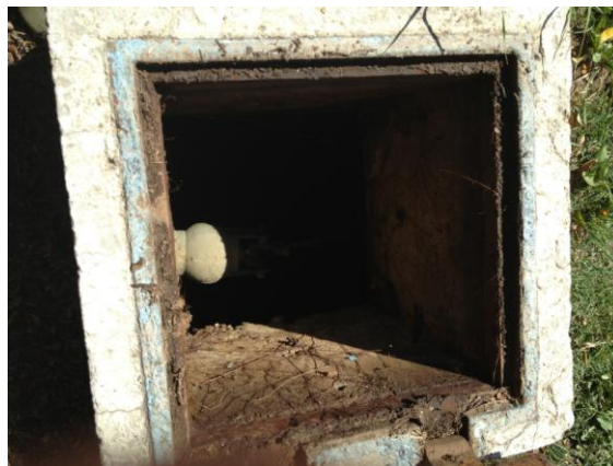
Figura 2. 20 Cisterna de laboratorios pesados
