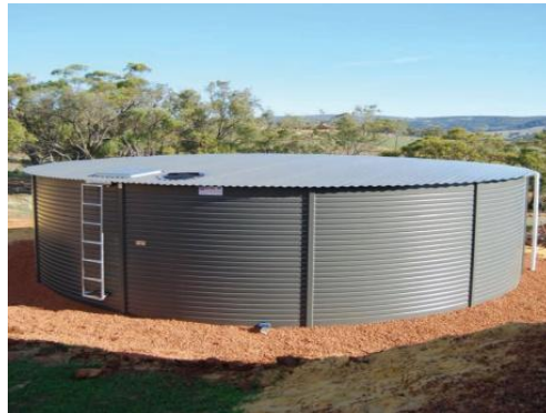
Figura 1. 17 Captación de agua pluvial Australia
