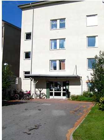
Figura 1. 10 Ringdansen, Norrköping , Suiza
