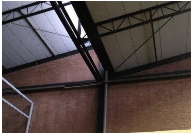
Figura 2. 19 Cales y tuberías del edificio
