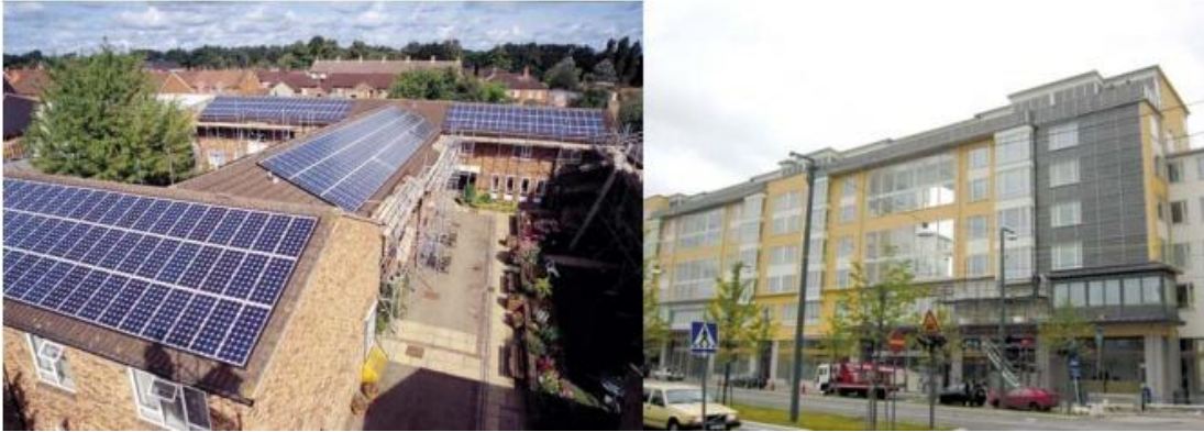
Fig. 3.12 FV en un tejado inclinado y en fachada
