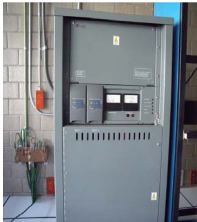
Figura 3.2 Fuente de alimentación del RDA
