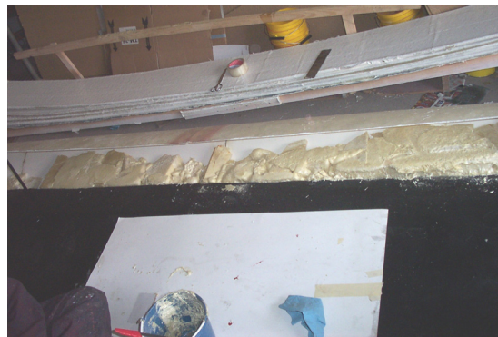
Imagen 7.21. Aplicación de espuma de poliuretano.
