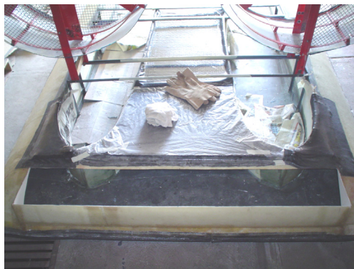
Imagen 7.40. Colocación de paredes verticales en la descarga de la tobera trasera.
