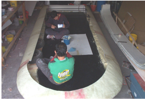
Imagen 7.20. Aplicación de espuma de poliuretano.
