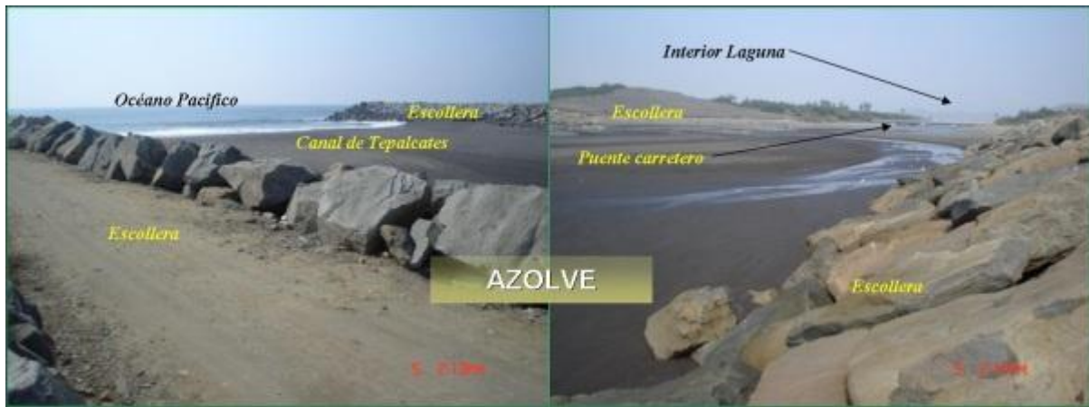
Figura 2.6 condiciones de azolvamiento en el Canal Tepalcates, 2005.
