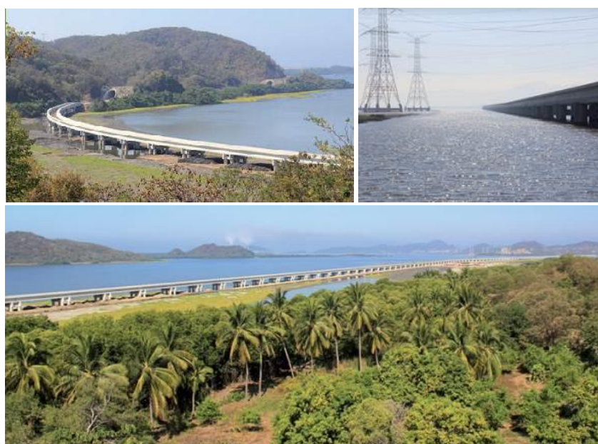
Figura 5.18 Desvío ferroviario sobre la margen norte del V-II en el SLC (González Gottdiener, 2013).
