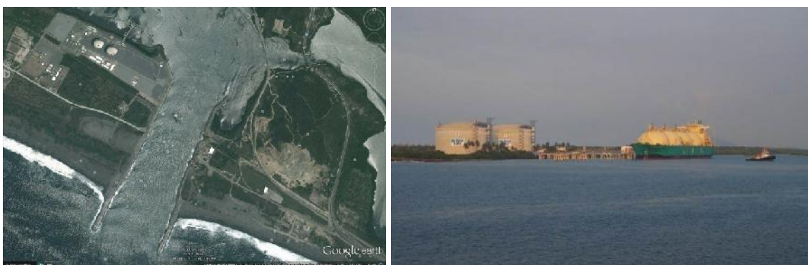
Figura 5.17 Terminal de gas licuado en V-II del SLC (Google, 2013, foto propia).
