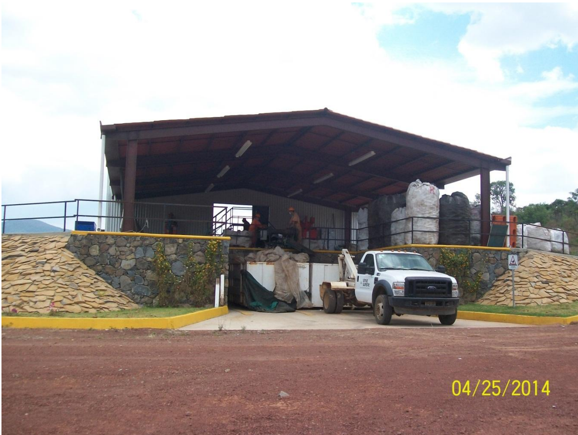
Imagen 1. Planta de separación de residuos sólidos de Civar sureste
