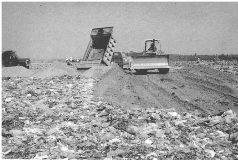
Operación en Bordo Poniente —Recubrimiento de la Basura con Tierra—
