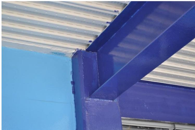
Fotografía 4.2 Conexión de la superestructura de las columnas de concreto y muros por cortante
