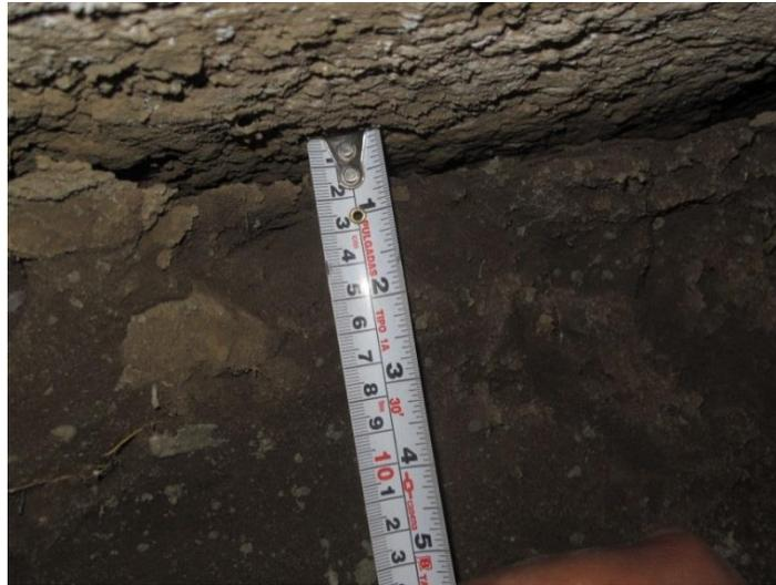
Fotografía 4.18 Se muestran 1.5 cm levantados por los gatos hidráulicos.
