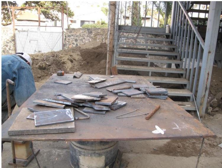
Fotografía 4.22 Placas de acero estructural para el calzado de los soportes.
