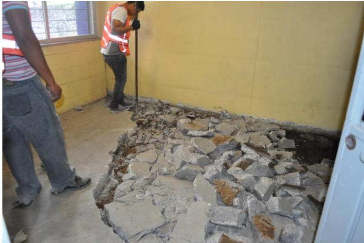
Fotografía 4.3 Demolición de pisos de concreto, en diferentes espesores por el hundimiento diferencial.
