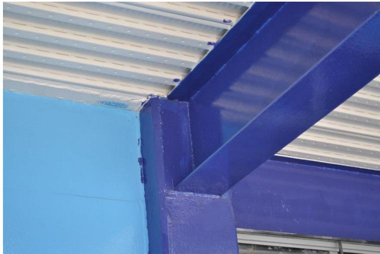
Fotografía 1.6 Unión de las traves metálicas con las columnas de concreto
