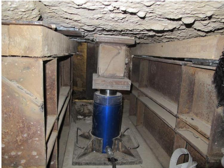
Fotografía 4.16 EJE 2-B para iniciar los trabajos de recuperación con un gato de simple acción.
