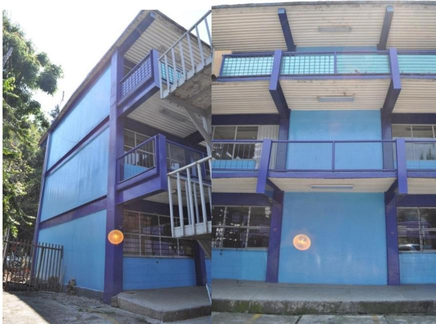
Fotografía 1.7 Muros y columnas de concreto, ambos elementos estructurales que fueron construidos para rigidizar la estructura.
