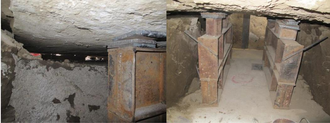
Fotografía 4.27 Se muestra como se despegó la cimentación del suelo y las placas de acero que soportan la estructura.
