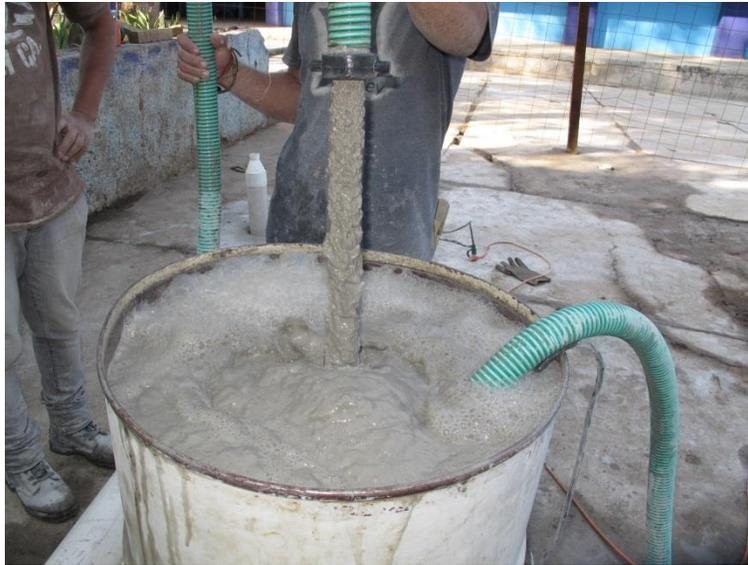
Fotografía 4.7 Elaboración de la mezcla para estabilizar al suelo de sustentación.
