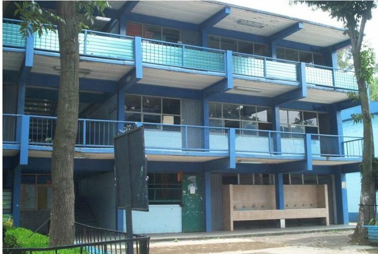
Fotografía 1.5 Fachada del edificio 2, donde se puede observar el tipo de diseño estructural, es decir, los marcos estructurales de acero y las losas a base de losacero de 0.10 metros de espesor.
