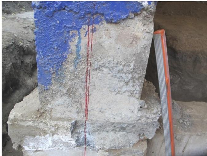
Fotografía 4.24 Se muestran la diferencia de niveles de la cimentación con respecto a las columnas de concreto.
