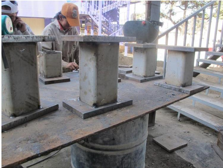
Fotografía 4.21 Fabricación de tacones de diferentes tamaños para las alturas necesarias.
