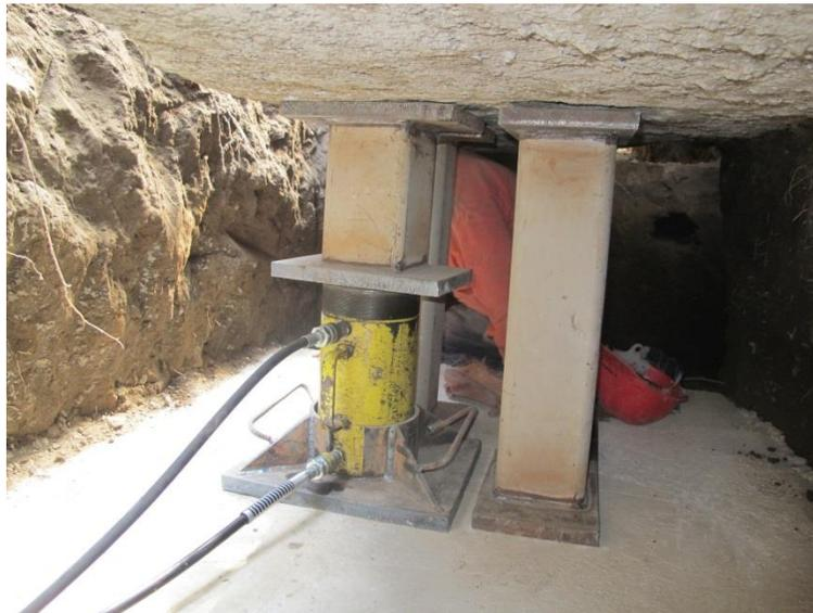
Fotografía 4.15 EJE 2-A para iniciar los trabajos de recuperación con un gato de doble acción.
