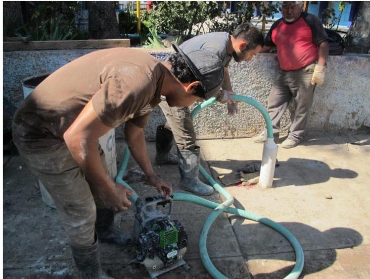
Fotografía 4.8 Proceso de inyección de la mezcla para estabilizar el suelo de sustentación.
