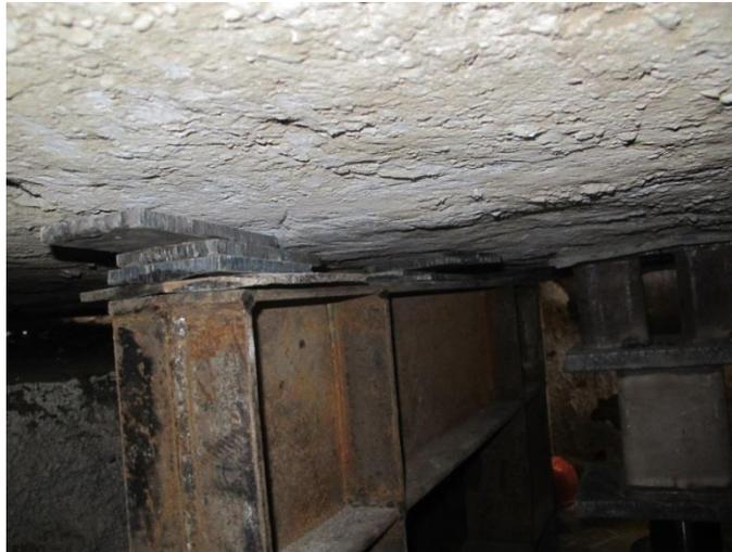
Fotografía 4.23 Placas utilizadas para calzar los soportes de acero.
