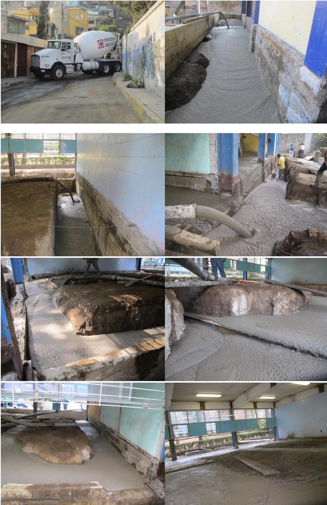
Fotografía 4.33 Proceso de colado con relleno fluido  $f'c=14 \text{ Kg/cm}^2$ , para estabilizar la estructura.
