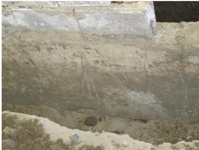
Fotografía 4.26 Se muestran las fisuras generadas por los esfuerzos de los gatos, en la cimentación en los sentidos longitudinales y transversales.
