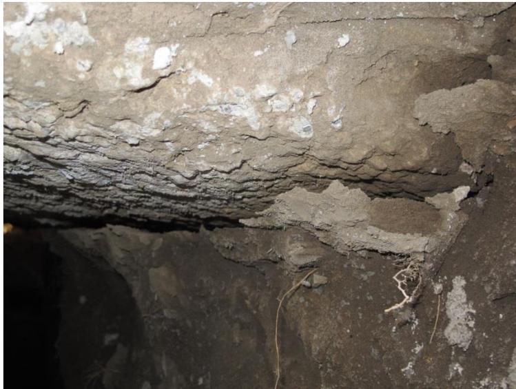
Fotografía 4.17 Se empieza a mostrar la separación entre la estructura y el suelo de sustentación.
