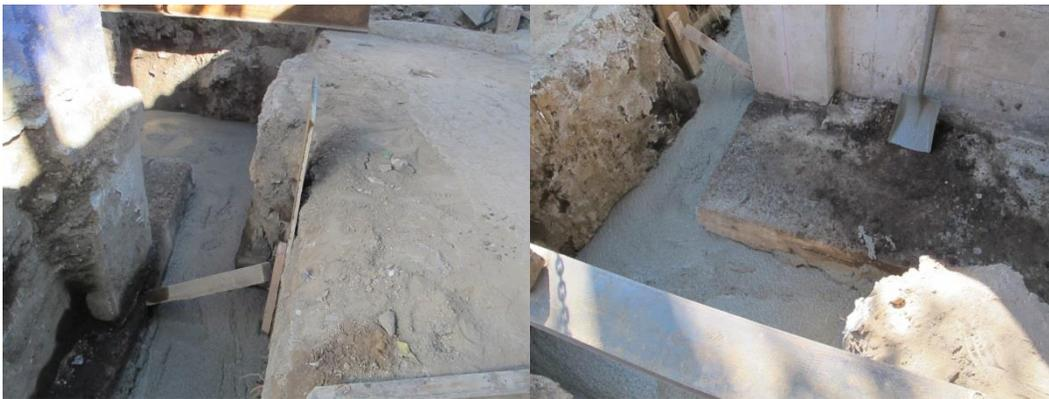
Fotografía 4.31 Termino de la estabilización hasta nivel de plantilla de la
