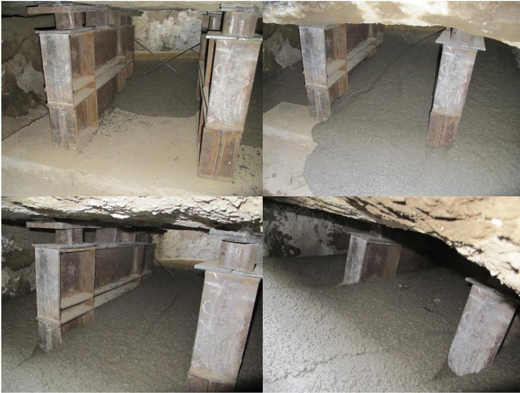
Fotografía 4.30 Proceso de estabilización de la cimentación con relleno fluido
