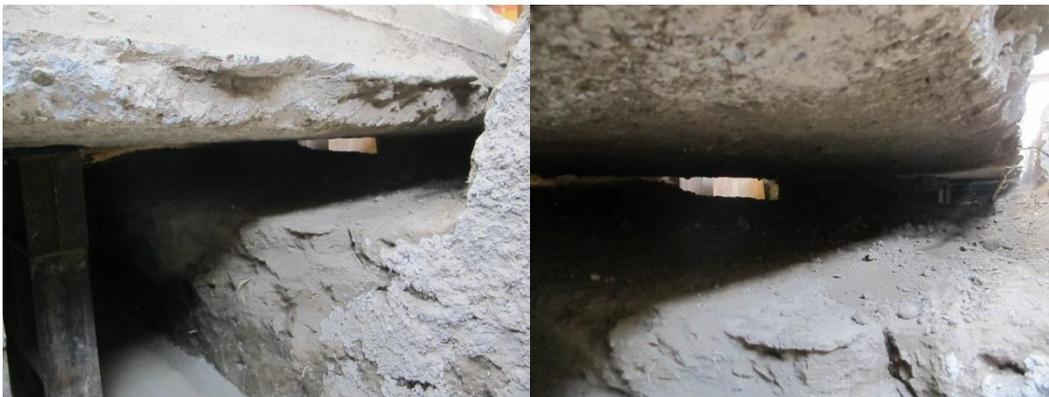
Fotografía 4.29 Se muestra la separación de la cimentación con el suelo, el cual será rellenado con relleno fluido  $f'c=14 \text{ kg/cm}^2$ , con un tiempo de fraguado de 24 horas.
