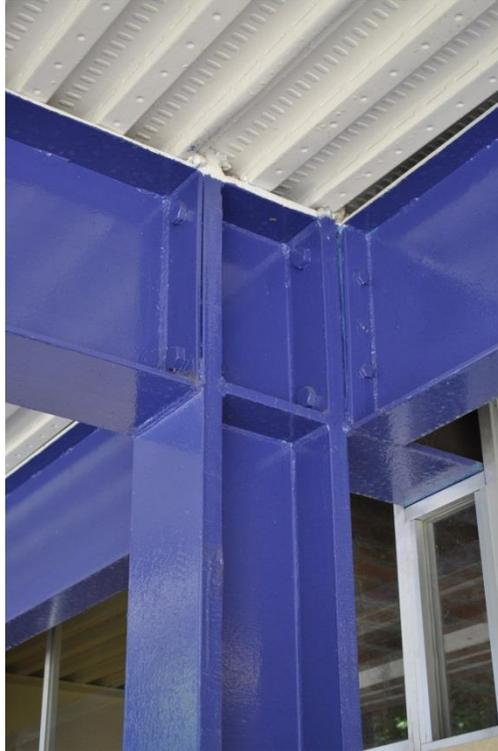
Fotografía 1.4 Unión entre las columnas y las traves, notándose que estas uniones fueron tanto con tornillos y soldadura.
