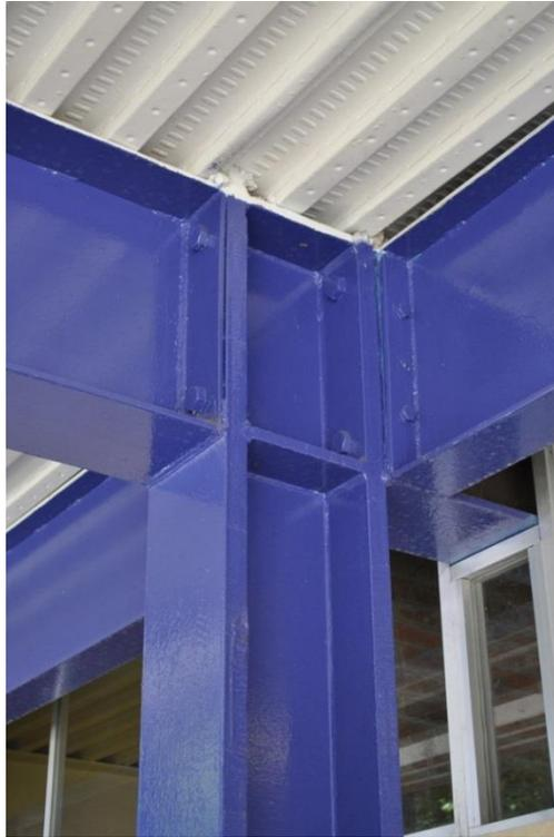
Fotografía 4.1 conexión de la superestructura atornillada y soldada.
