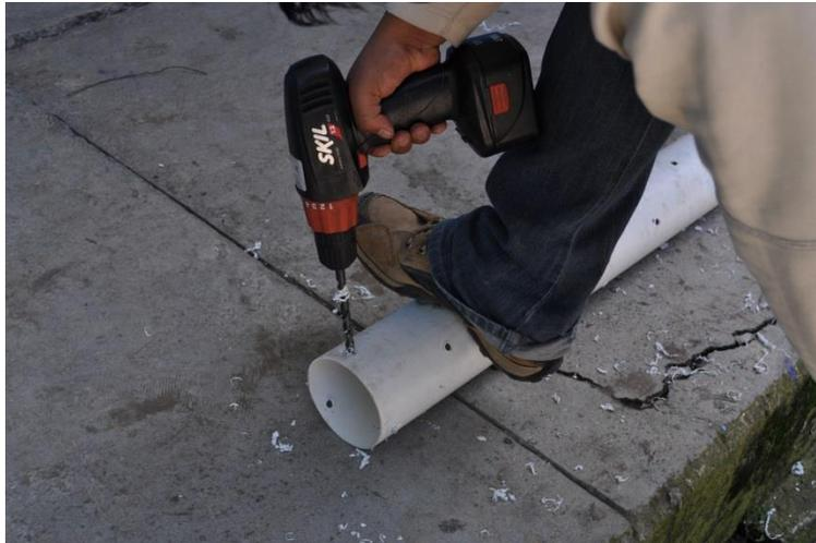
Fotografía 4.5 Preparación de los tubos de PVC para ademe
