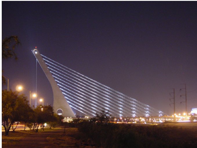
Puente "La Unidad", Monterrey Nuevo León
