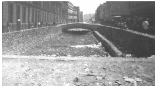
Restitución de los muros y del puente, sobre los muros coloniales excavados por Elsa Hernández Pons en Corregidora
