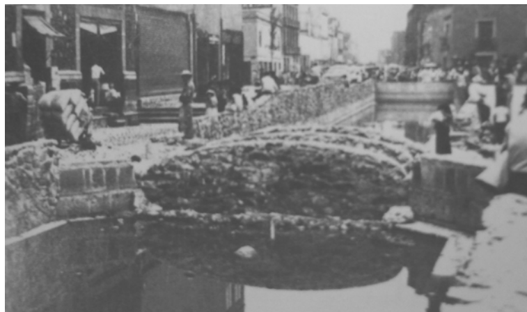
En 1981, frente a la Casa del Diezmo y sobre el desplante original de los muros coloniales, el INAH realizó una "recreación" de uno de los puentes de la acequia.
