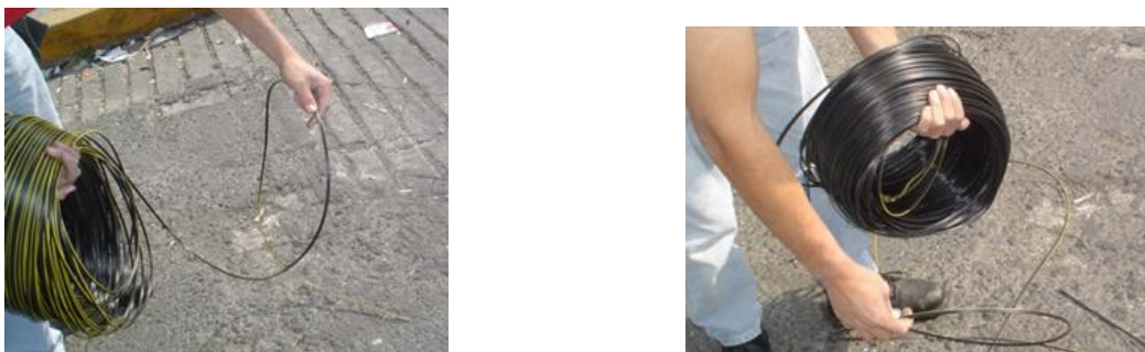
Fig. 45 Procedimiento como desenredar el cable.
