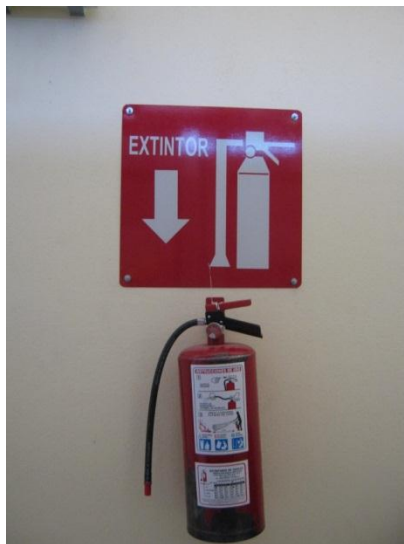
FIGURA 4.7 Extintor portátil.
