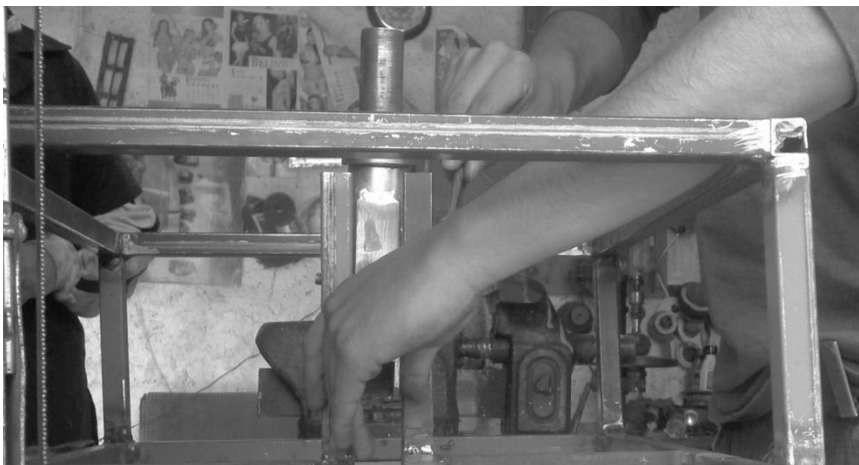
FIGURA 3.30.- INSTALACIÓN DEL SOPORTE DE ALUMINIO.
