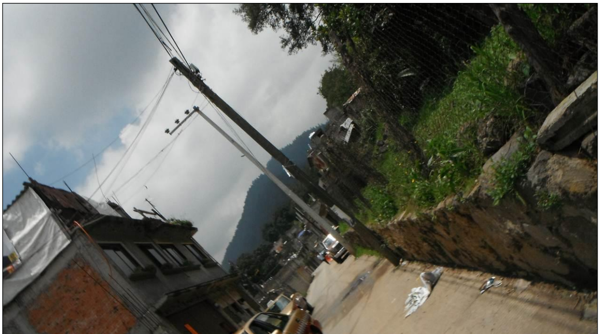
Figura 4.5 Calle cerro del Agua, pavimento de concreto hidráulico, estas calles son nuevas por lo que en los planos no aparece la tubería que conforma su red de agua potable.
