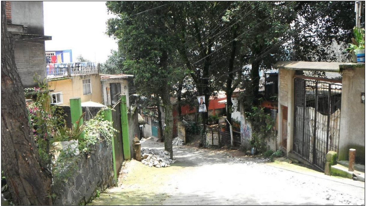
Figura 4.6 Calle Magueyes casi esquina con calle Cerro del Agua.
