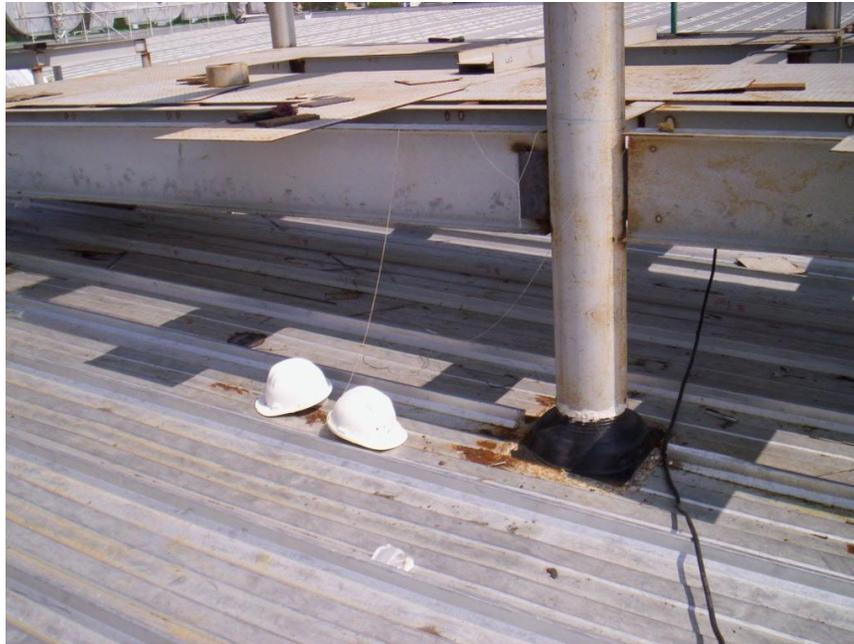
Fotografía No. 16 Soportes para equipos de aire acondicionado instalados sobre cubierta.
