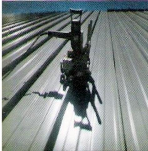
Fotografía No. 14 Máquina engargoladota de lámina KR-18 trabajando sobre cubierta
