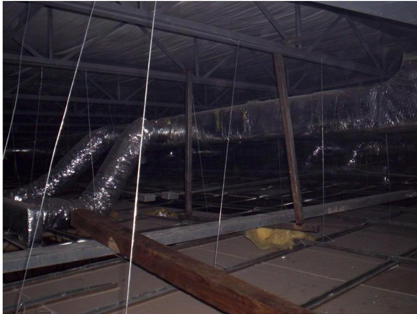
Fotografía No. 15 Ductería oculta entre la cubierta y el plafón falso
