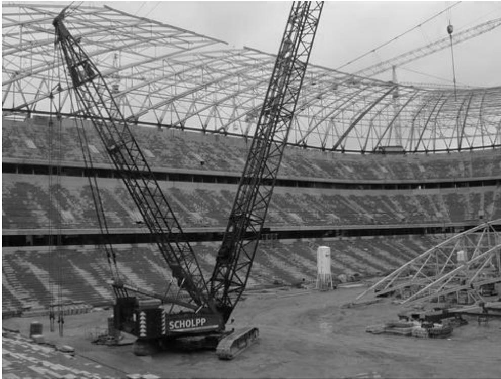
Fotografía No. 1 Montaje de armadura para techumbre del estadio Allianz Arena de Munich, Alemania.
