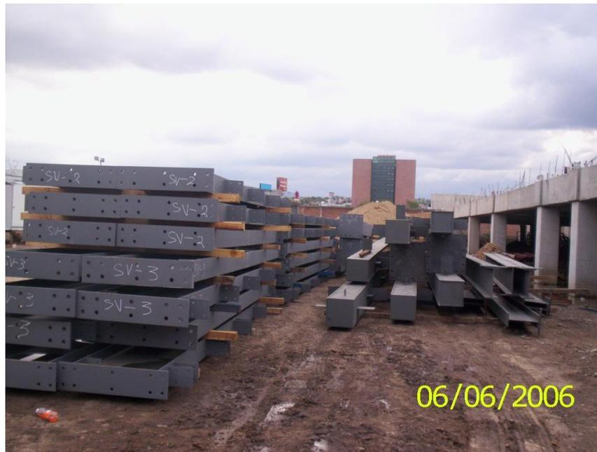
Fotografía No. 9 Marcas de montaje en estructura metálica.
