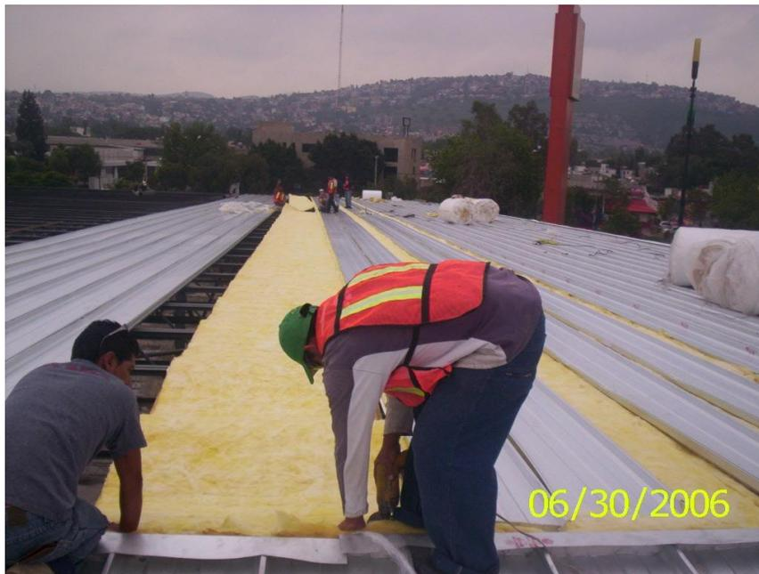
Fotografía No. 13 Instalación de aislamiento termoacústico en cubierta
