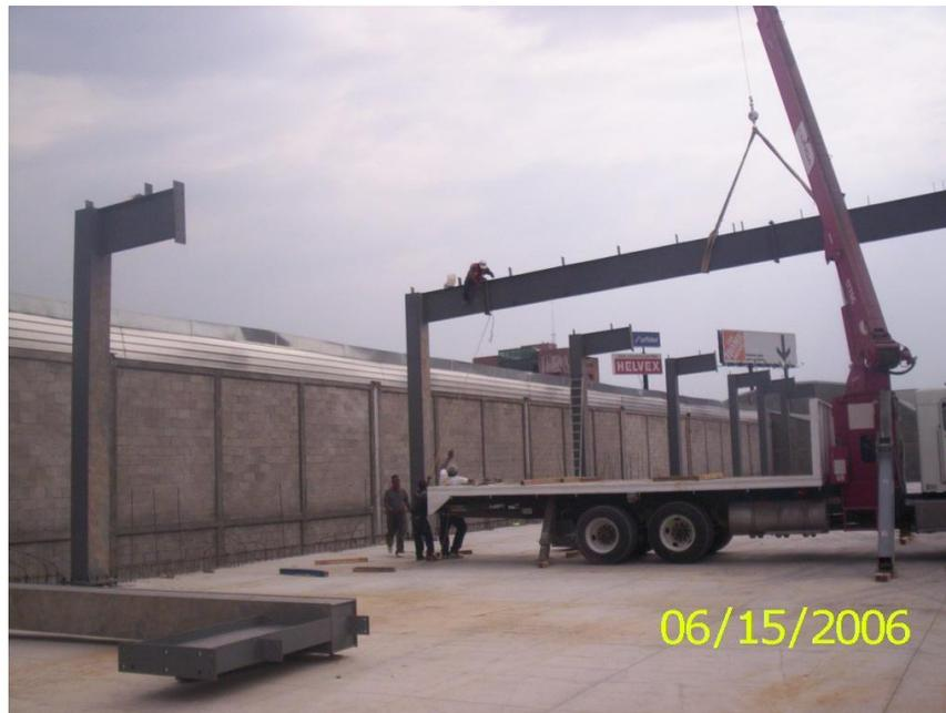
Fotografía No. 11 Avance de montaje de vigas unidas previamente mediante tornillos
