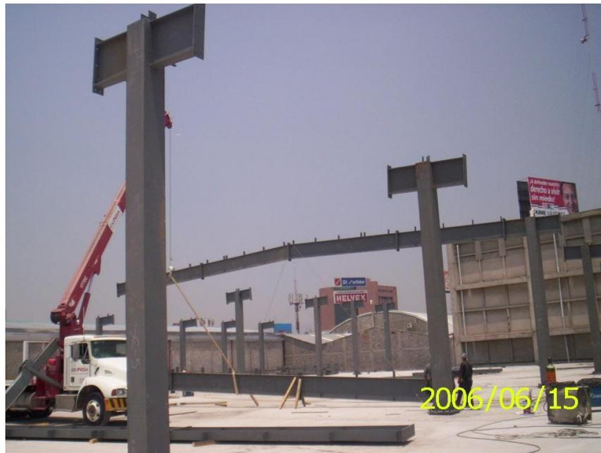
Fotografía No. 10 El Montaje inicia con las columnas fijándolas en su placa base
