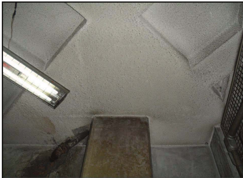
FOTOGRAFIA No. 04: Acercamiento al capitel típico que se encuentra en la periferia de las columnas del edificio.
