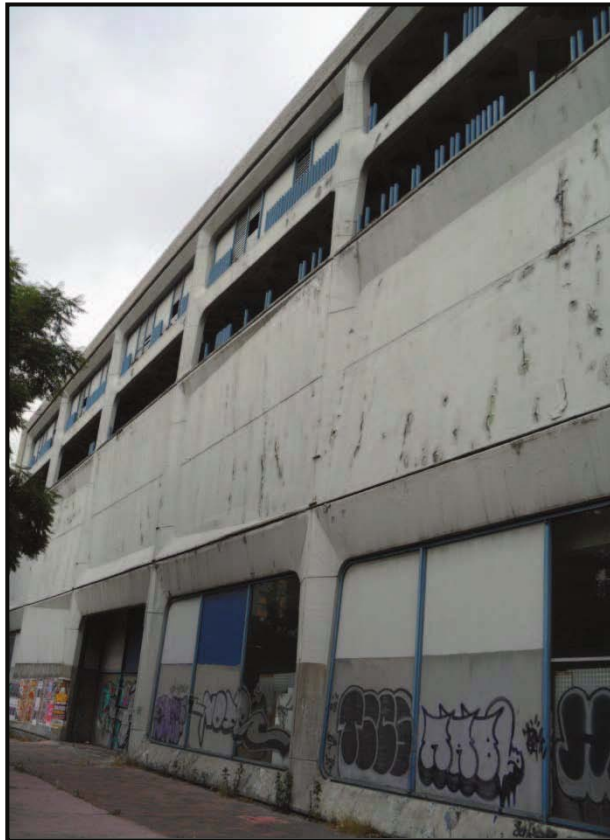
FOTOGRAFIA No. 14: El aspecto de la fachada principal hacia la Av. Ricardo Flores Magón del edificio por rescatar
