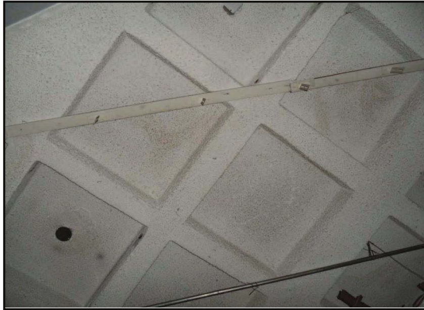
FOTOGRAFIA No. 03: Detalle del tipo de losa con nervaduras integradas, formadas por casetones recuperables de distintos anchos.
