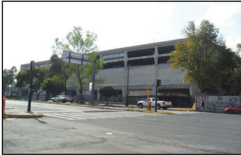
FOTOGRAFIA No. 01: Fachada principal del edificio por rescatar ubicado en la esquina de la Av. Ricardo Flores Magón y la calle de Lerdo.
