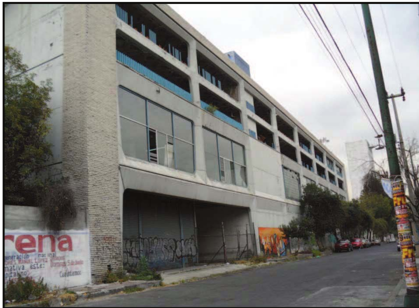
FOTOGRAFIA No. 10: Aspecto de la fachada posterior de la edificación por rescatar se puede ver lo que fuera su andén de carga. Reglamento de Construcciones del D F
