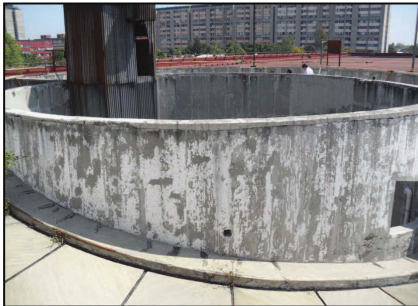
FOTOGRAFIA No. 06: El acceso vehicular a las áreas de estacionamiento de los niveles superiores es a través de rampas "en caracol", con un núcleo circular de concreto al centro.
