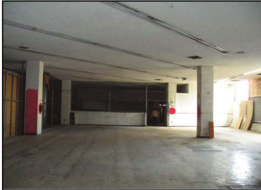
FOTOGRAFIA No. 05: Aspecto de la planta baja en donde se encontraba el piso de ventas de la tienda de autoservicio, se pueden ver los claros que se tenía entre columnas.
