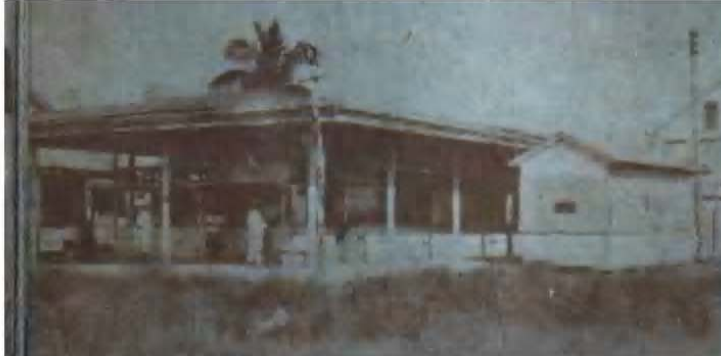
Imagen 5. Así se apreciaban las instalaciones del Mercado Leona Vicario
