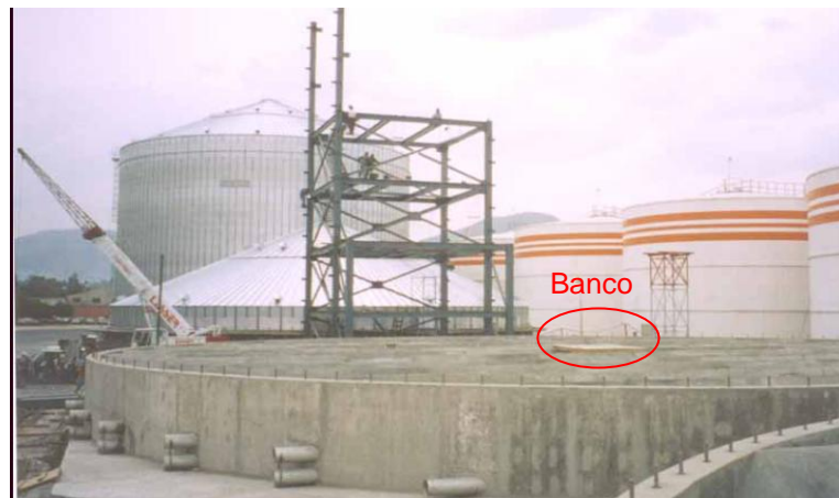
Fig. 44 Banco para alineación de Anclas en Muros Circulares
