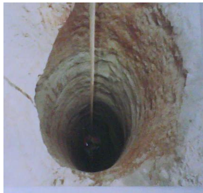
Fig. 4 Perforación para pila de cimentación. Hazama Querétaro
