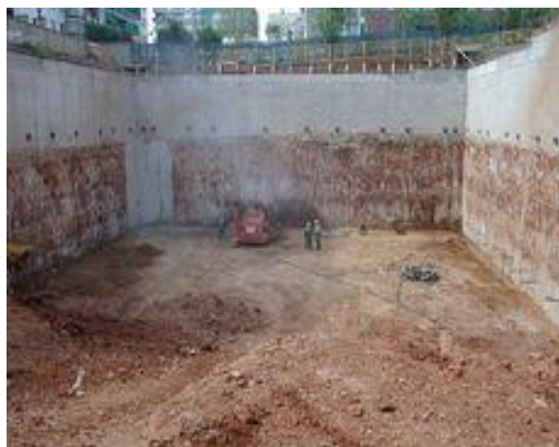
Fig. 2 Muros Pantalla. Google.
