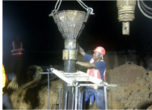
Fig. 55 Colado con Sistema Tremie. Remie consultores.
