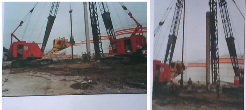
Fig. 33 Hincado de pilotes para los Silos de Semilla.
