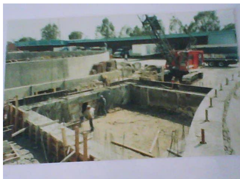
Fig. 57 Muros Milán para cuarto de máquinas de los silos de semilla.
