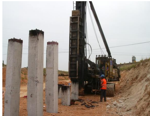
Fig. 9 Hincado de Pilotes. Google.
