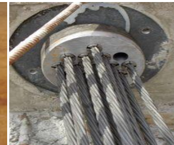
Pieza Integrada ara el Postensado
