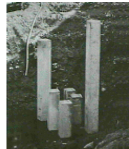
Fig. 7 Lanzado e Hincado de Pilote. Google.
