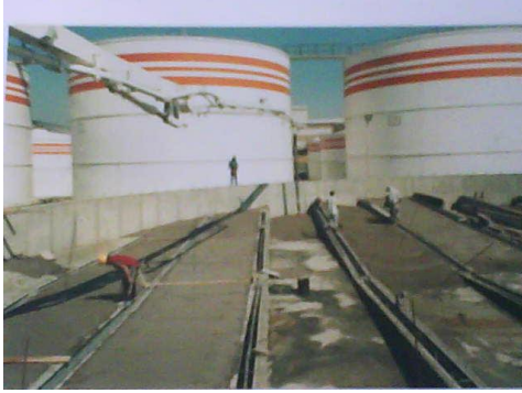
Fig. 45 Relleno fluido en Pendientes de Apoyo, con revenimiento de 15 a 18 cm.
