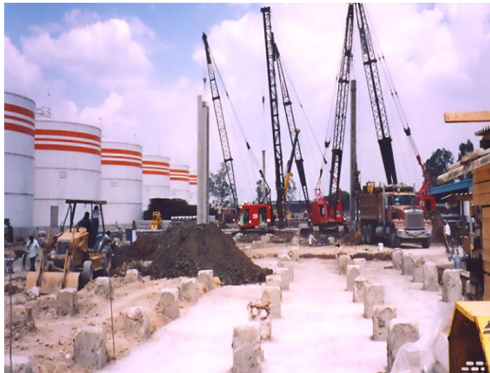
Fig. 12 Pilotes hincados para la cimentación de silos de semilla. (pilotes flotantes).
