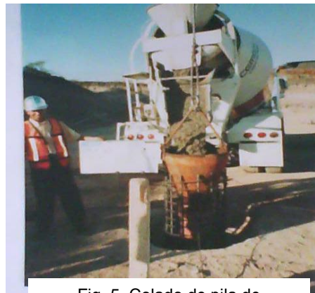
Fig. 5 Colado de pila de cimentación. Hazama Querétaro
