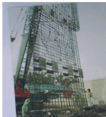
Fig. 51 Armado de Muro Milán para casa de máquina
