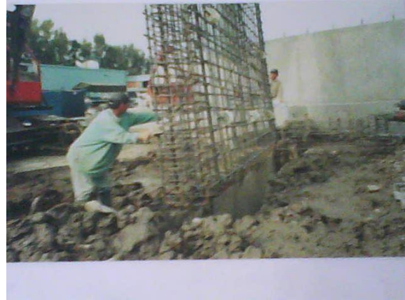
Fig. 53 Colocación de armado de Muro Milán
