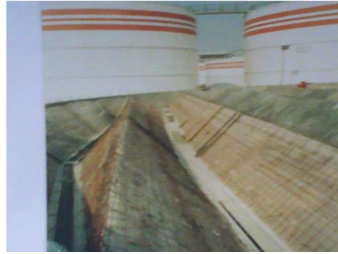
Fig. 46 Relleno fluido en pendientes principales con revenimiento de 8 a 12 cm.
