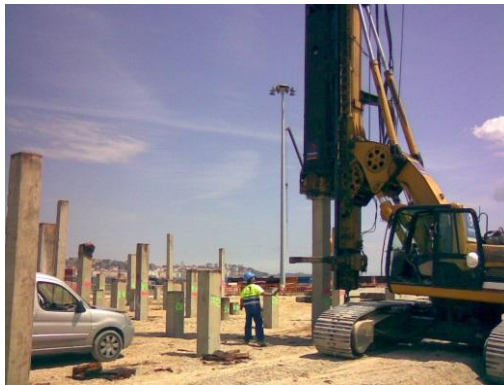
Fig. 36 Martillos para Hincado de pilotes. Google.
