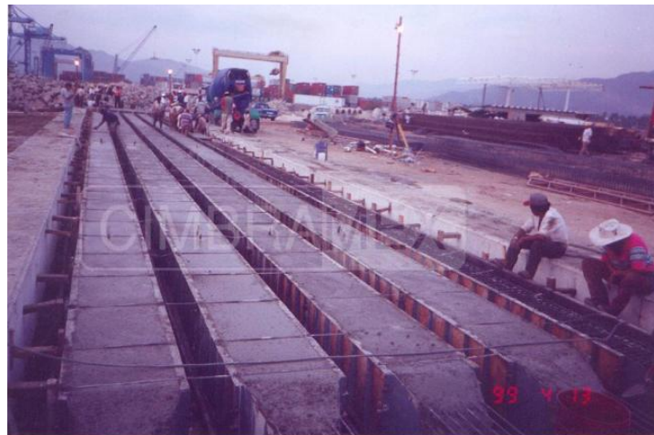
Fig. 15 Moldes para colado de pilotes. Cimbramex
