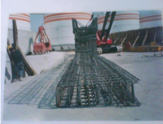
Fig. 52 Armado de esquina del Muro Milán para casa de máquina
