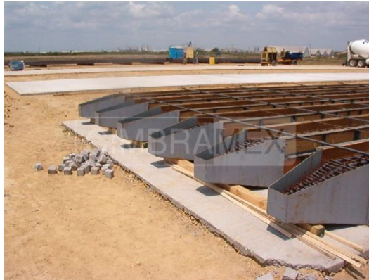
Fig. 13 Cama para colado de Pilotes. Cimbramex
