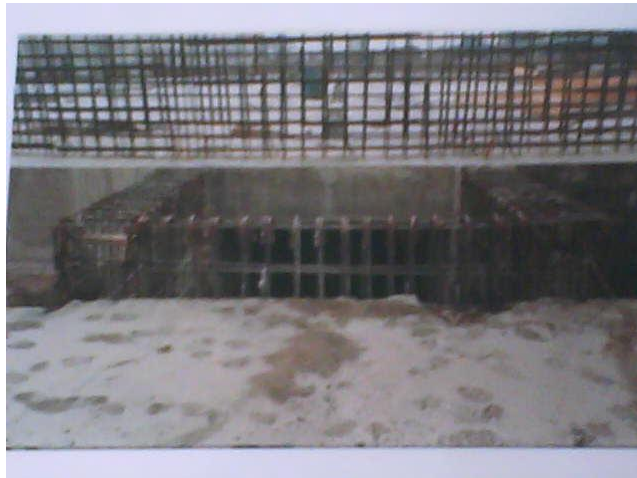
Fig. 42 Armado de Acero de Refuerzo de muros circulares.
