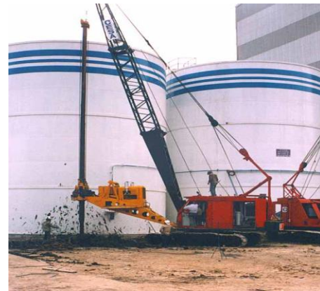
Fig. 29 Perforadora de circulación inversa para hincado de pilotes para los silos de semilla.
