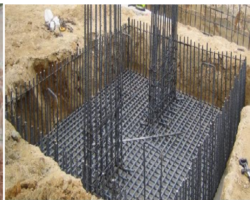
Fig. 3 Cimentación por Flotación. Google.
