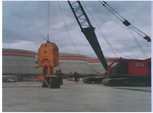
Fig. 48 Almeja para perforación de muro milán.
