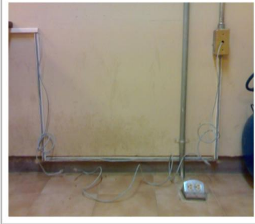
Fig. 51.- Cables expuestos
