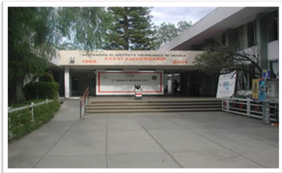
Fig. 33 .- Fachada principal del ITO
