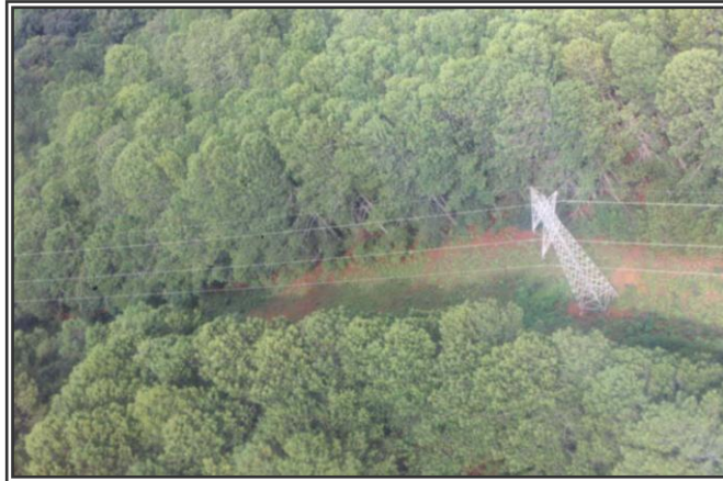
Figura 5. Vista aérea de una línea de subtransmisión de 115 KV, construida con torres de acero autoportadas a través de un bosque de pino.
