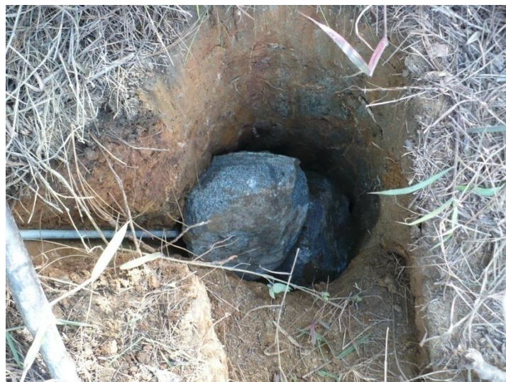
Foto: armado de retenida
