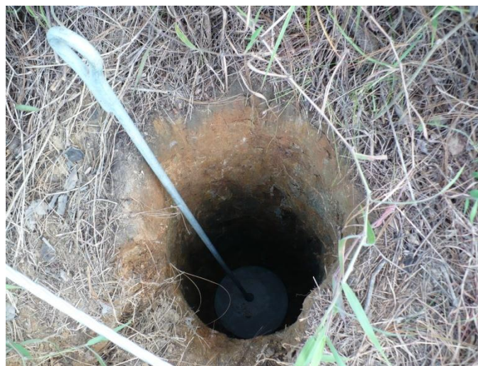
Foto: armado de retenida
