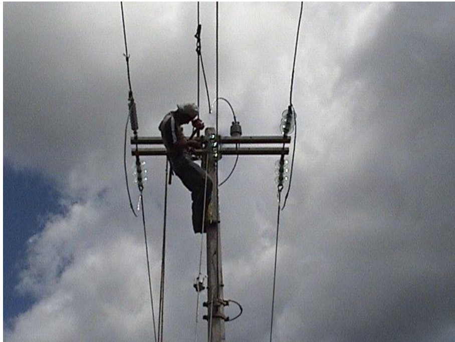
Figura13. Armado de estructura AD3N.
