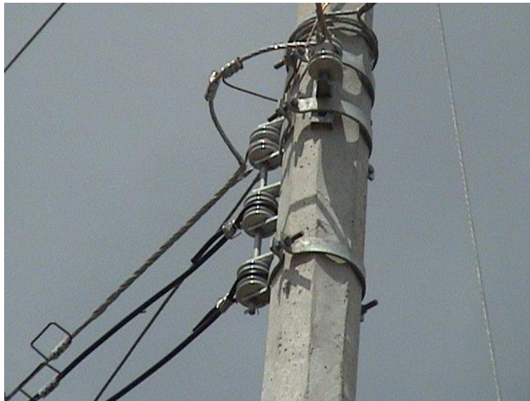
foto estructura 1R3/1R1
