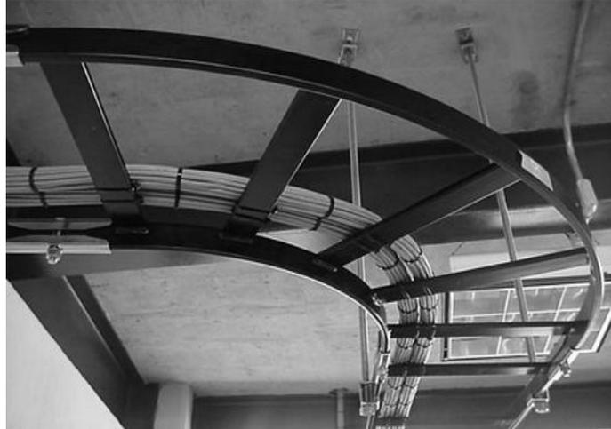
Figura 3.3 Cableado Horizontal por escalerilla
