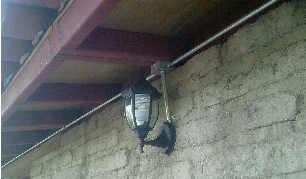
Fig. 4.6 Instalación de lámpara.
