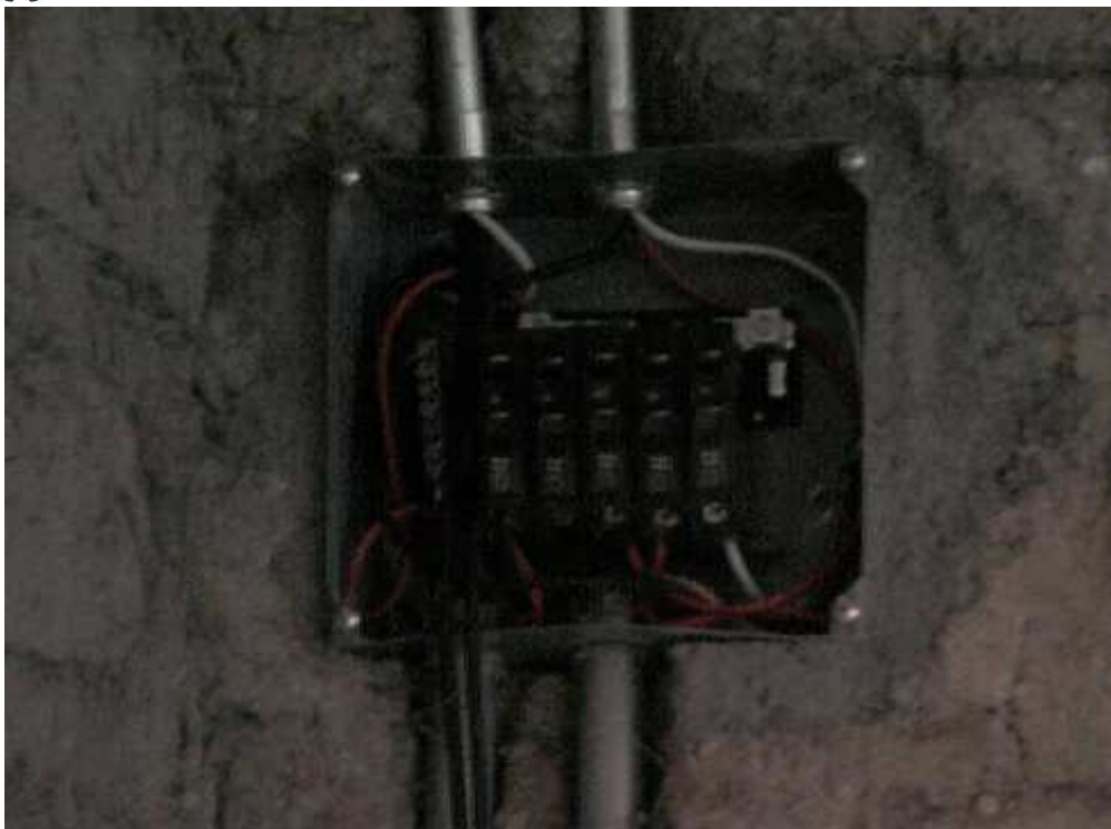
Fig. 4.8 Instalación de Centro de Carga
