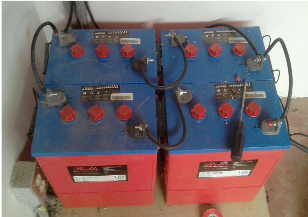
4.14 Instalación y Conexión de Banco de Baterías de 520 Ah.
