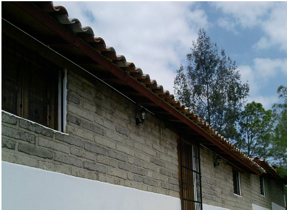
Fig. 4.5 Alumbrado Exterior Conjunto Monumental Atzompa.
