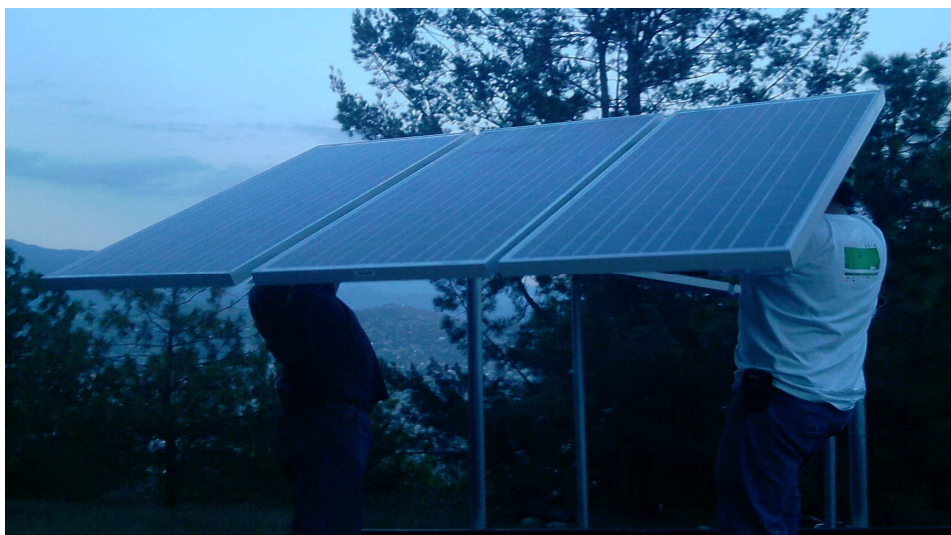
Fig. 4.11 Montaje de Paneles Fotovoltaicos sobre bases tubulares.
