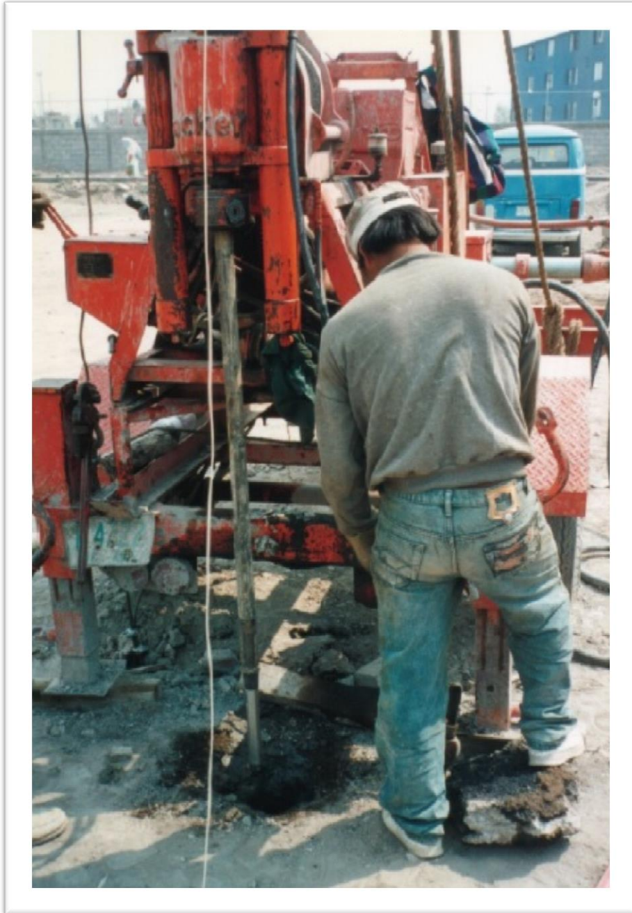
Fotografía 1. Ejecución de Sondeo con Cono Electrico.
