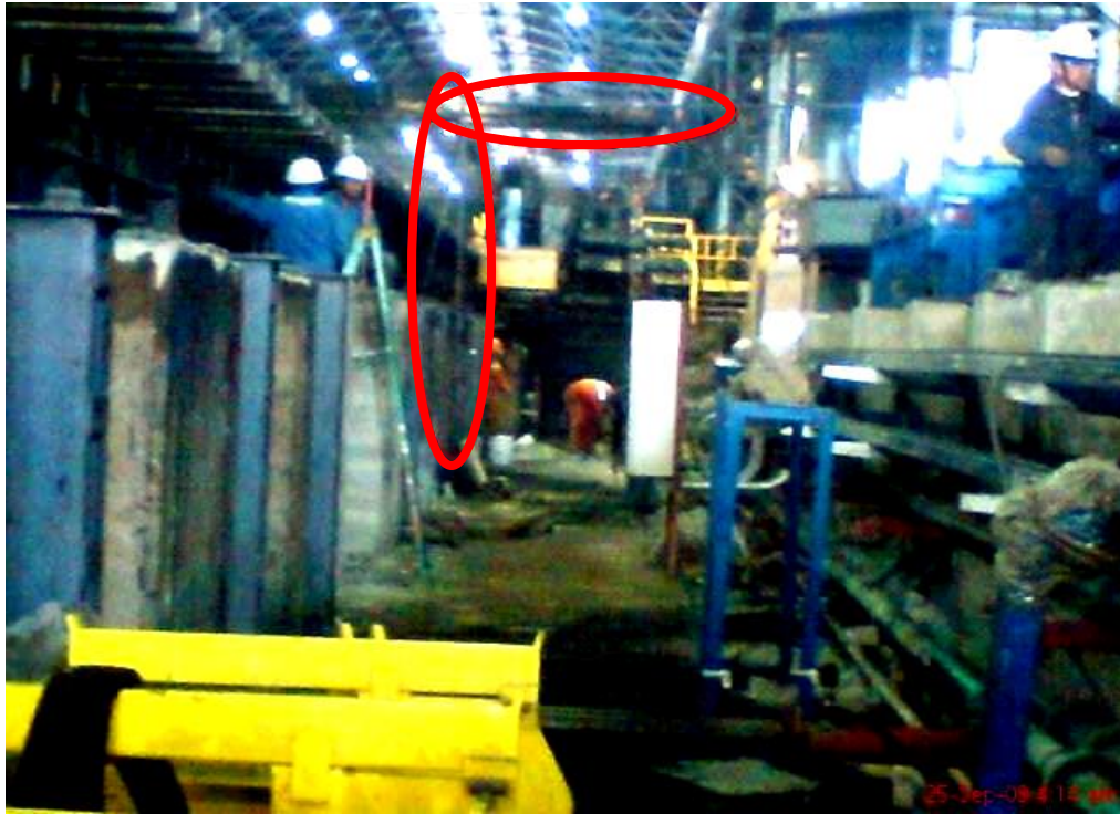
Figura 15. Imagen donde se llega a apreciar el montaje del travesaño para colocar el eje antes del montaje de las máquinas.
