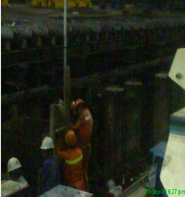
Figura 17. Colocación de marcas de elevaciones nuevas en las columnas.
