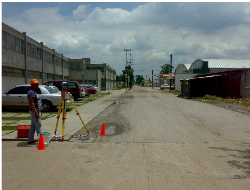
Figura 7. Estación ST3 sobre guarnición de calle 2ª Sur, vista sur-norte
