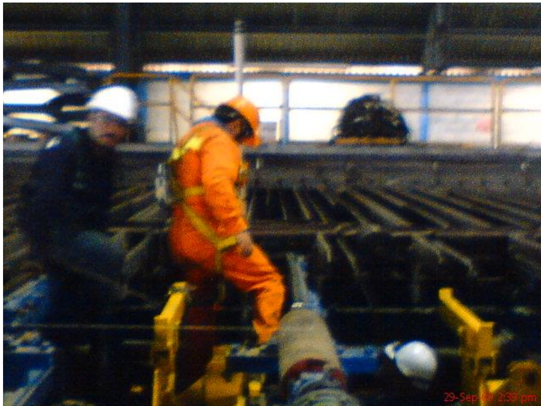
Figura 22. Imagen donde se revisa y se informa su elevación a los encargados de la máquina.
