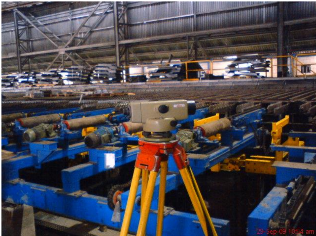
Figura 20. Zona a nivelar tras el montaje de la cama de rodillos
