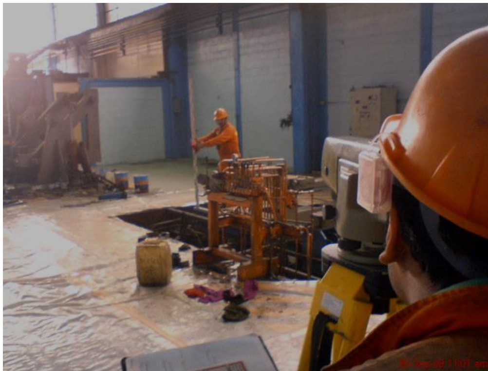
Figura 12. Nivelación vista desde el nivel
