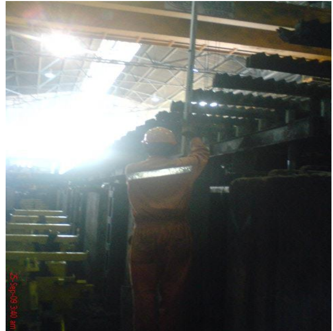
Figura 18. Ajuste de elevaciones para la colocación de las placas de acero.
