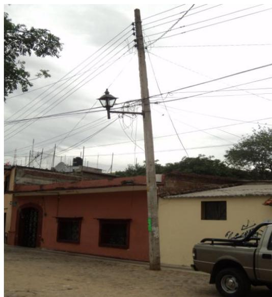
Fig. 6.4 Poste Inclinado de B.T.
