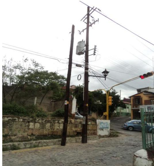
Fig. 6.8 Poste de M.T. con Transformador en cruce vial.
