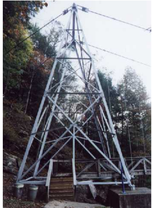
Foto 1.3-91 Detalle de la torre que soporta los cables principales y su sistema de unión
