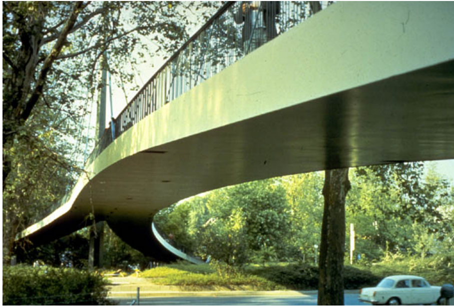
Foto 1.2-1 Puente peatonal Schillerstrasse
