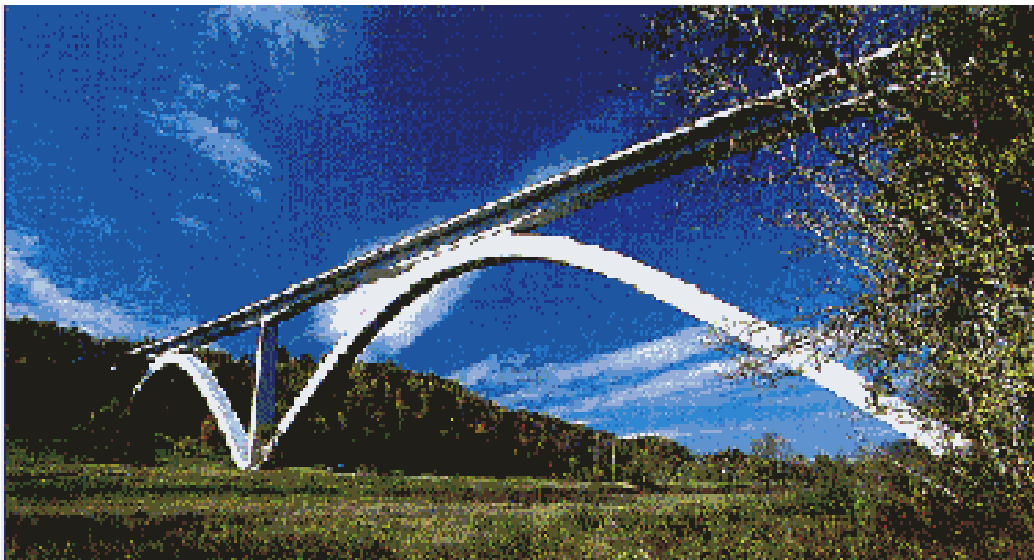
Foto 1.1-8 Puente de concreto presforzado
