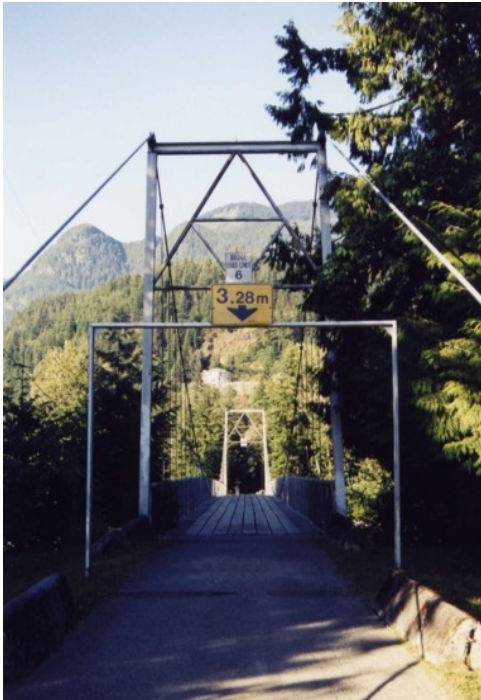
Foto 1.3-79 Vista frontal del puente
