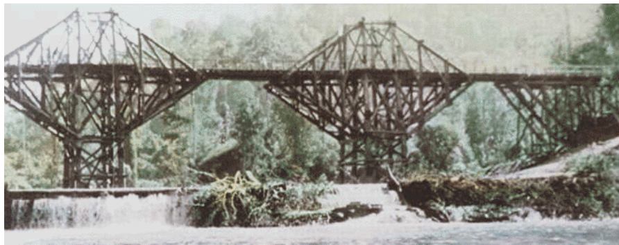
Foto 1.1-1 Puente de madera
