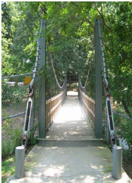
Foto 1.3-31 Posición de los cables principales sobre las columnas y su sistema de anclaje al piso
