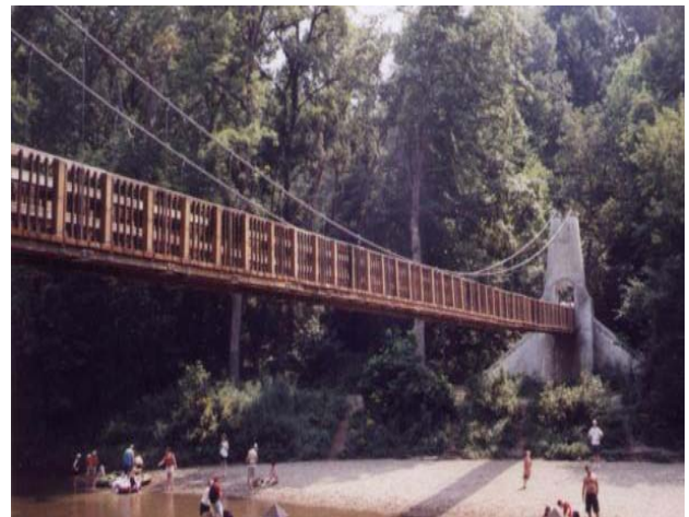
Foto 1.3-65 Detalle de la posición de los cables verticales
