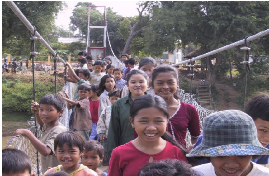
Foto 2-5 Acceso por un grupo de niños a través del puente, donde se puede apreciar la gran resistencia y seguridad que brinda dicha estructura
