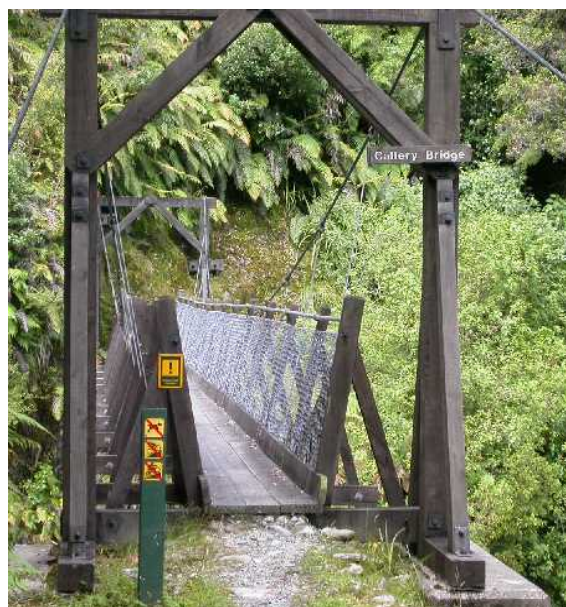
Foto 1.3-92 Vista frontal de puente en la que se observan las partes que lo componen
