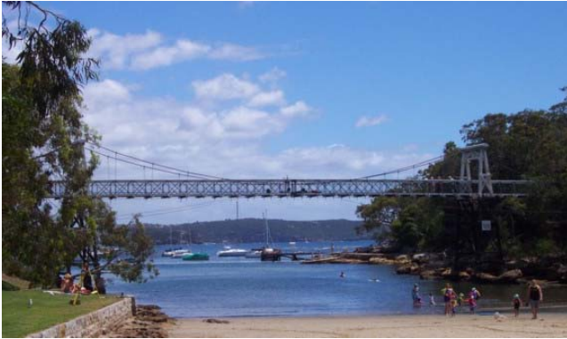
Foto 1.3-59 Vista general del puente a través de la bahía
