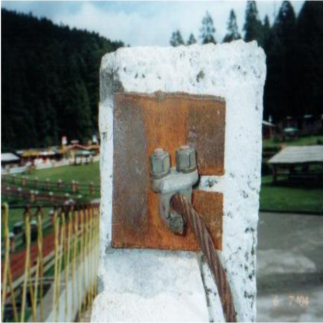
Foto 2-9 Detalle del anclaje de los cables superiores con el apoyo de concreto
