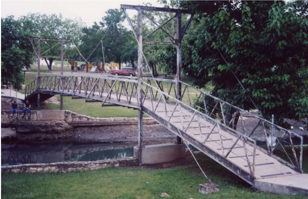
Foto 1.3-102 Estructura general del puente que muestra los elementos que la componen
