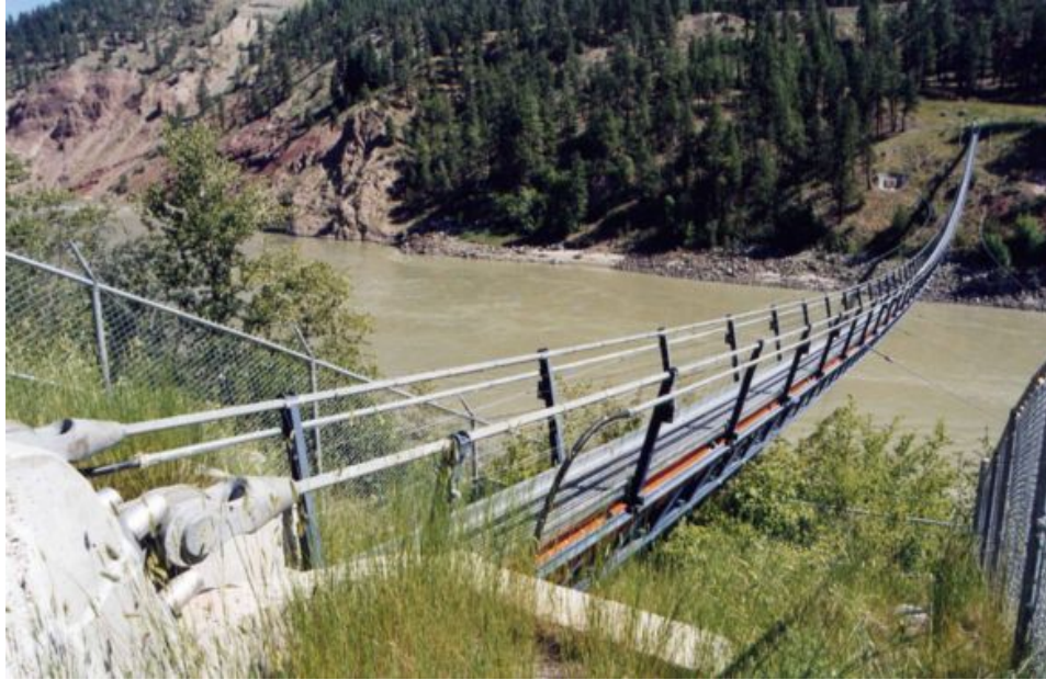
Foto 1.3-85 Sistema de anclaje de los cables principales unidos a la roca firme por medio de argollas
