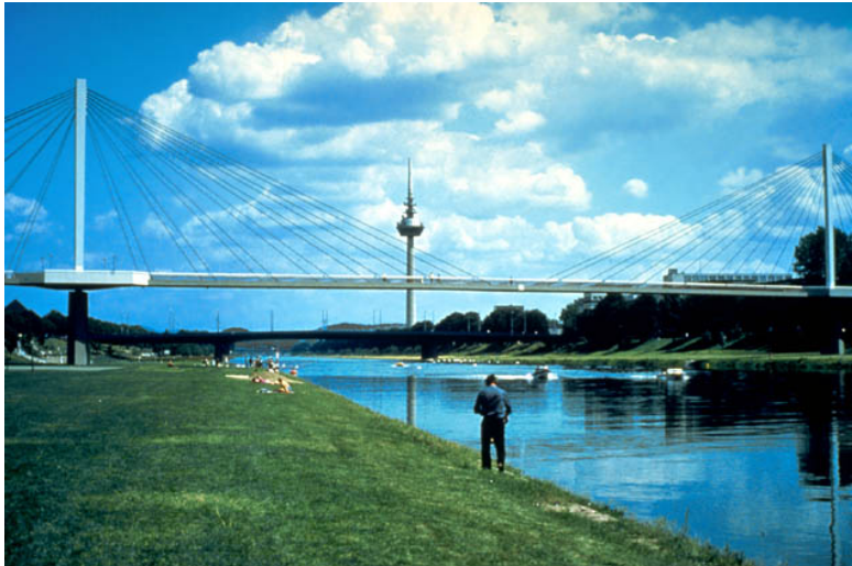
Foto 1.2-5 Puente atirantado para los peatones a través del Neckar en Mannheim (1977)
