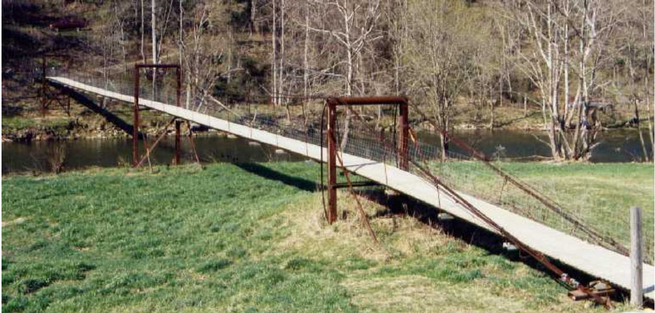
Foto 1.3-88 Vista general de la estructura del puente a través del río North Fork Holston
