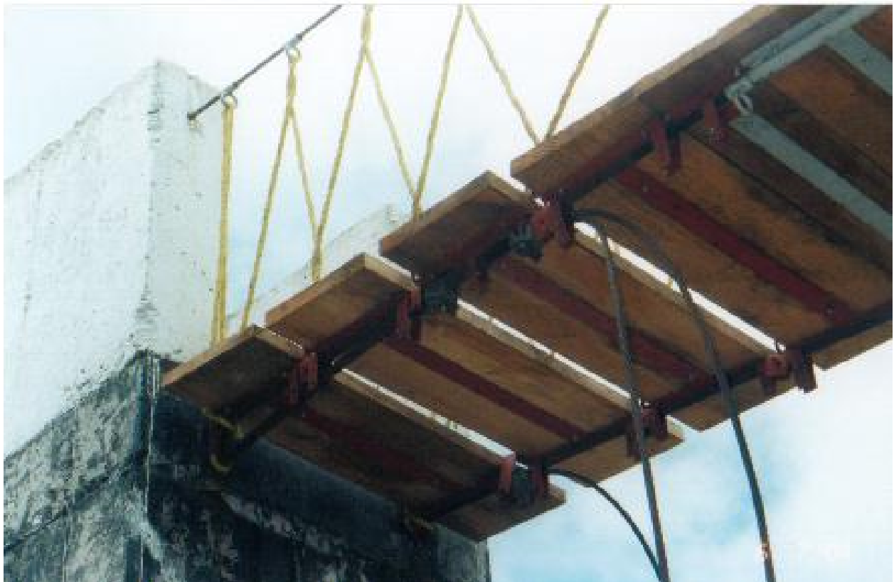
Foto 2-8 Detalle de unión entre los elementos que conforman el puente
