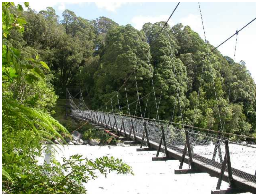
Foto 1.3-95 Panorámica general de la estructura del puente a través de la corriente del río
