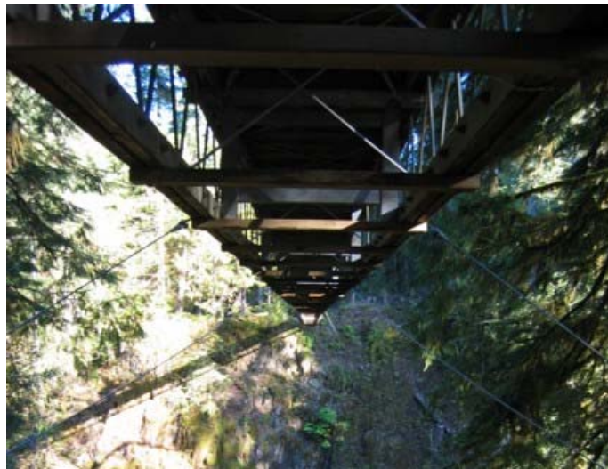
Foto 1.3-23 Detalle de los sistemas de piso y de rigidez por medio de vigas sujetas por cables independientes
