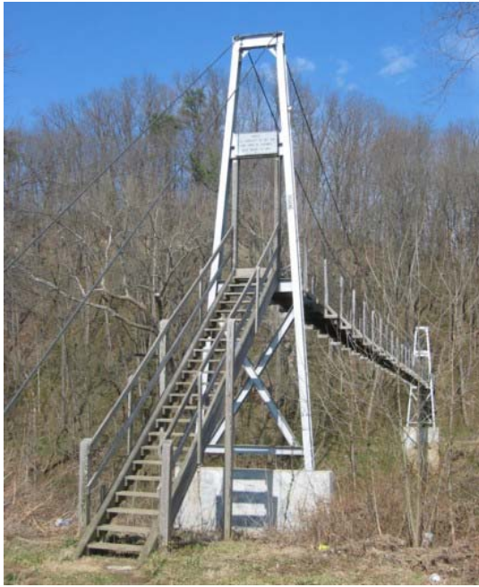
Foto 1.3-55 Detalle de la posición del pórtico con respecto al nivel del terreno
