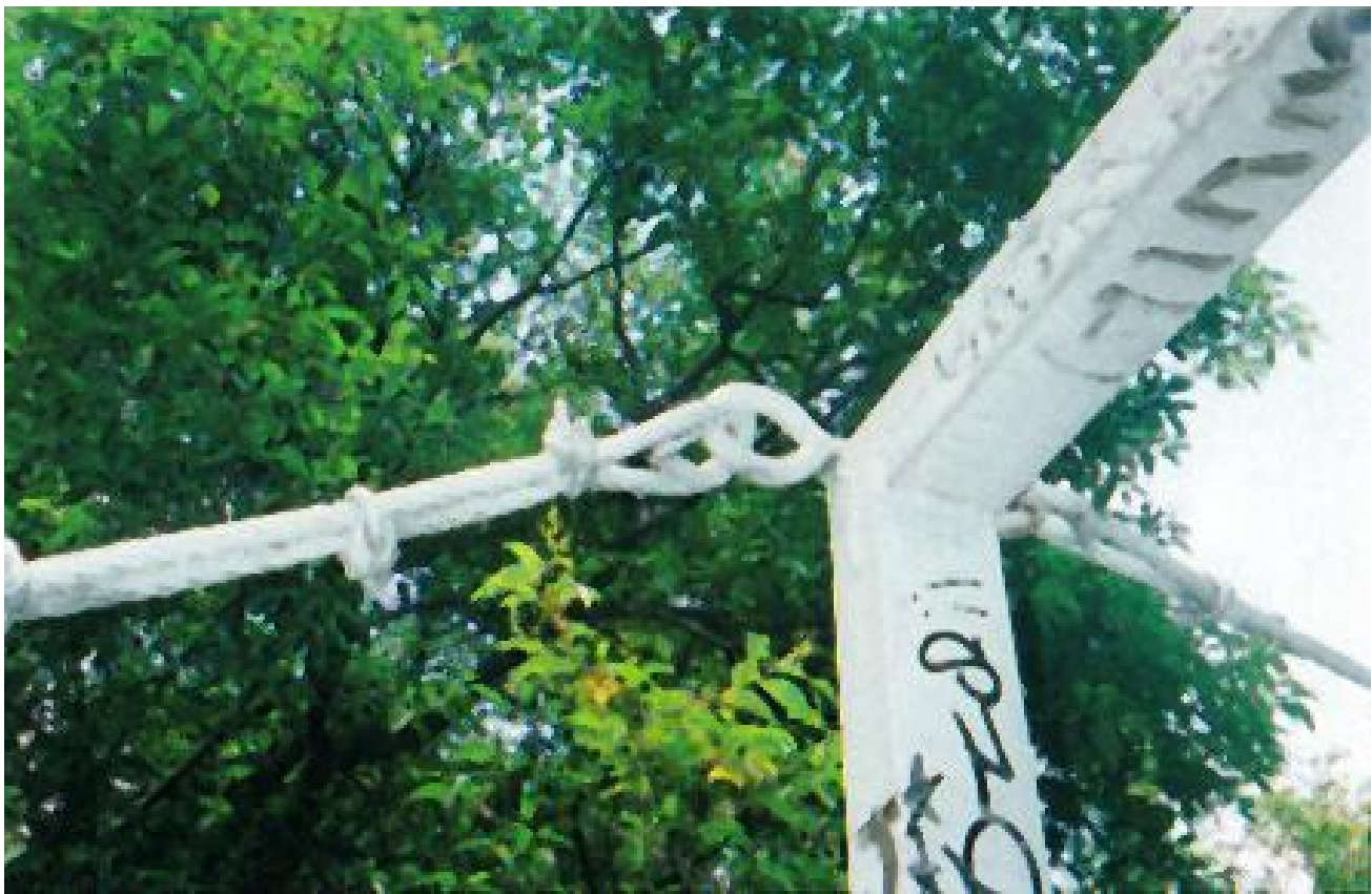
Foto 2-16 Unión de los cables principales y los de estabilización con la parte superior de los pórticos
