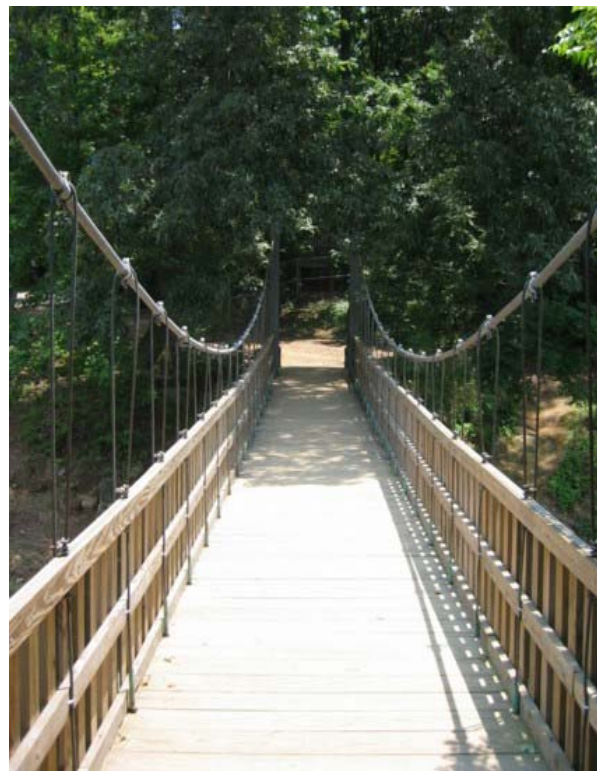
Foto 1.3-33 Posición de los cables secundarios en u invertida a lo largo del barandal
