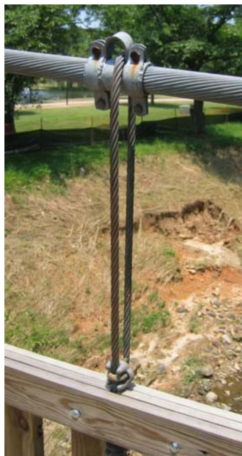
Foto 1.3-34 Detalle de la colocación de los cables secundarios en "u" invertida con respecto al cable principal y el barandal
