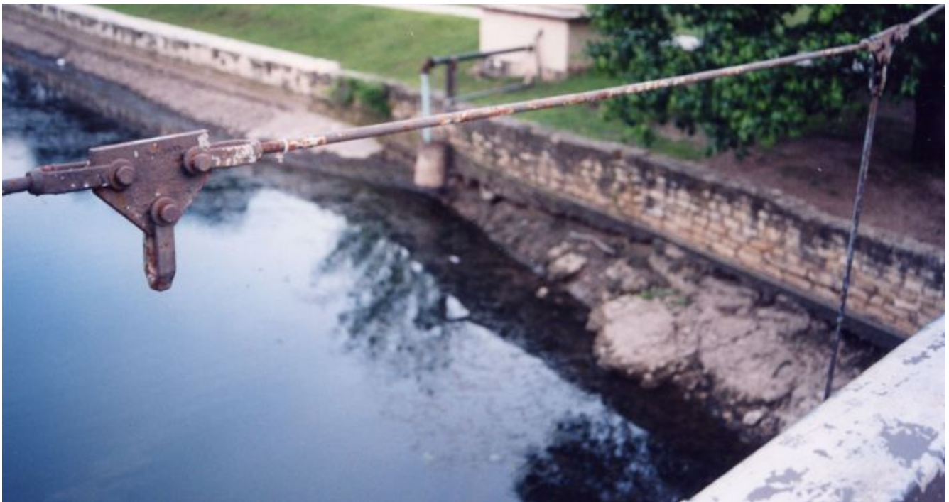
Foto 1.3-106 Unión entre tubulares principal y vertical entre sí por medio de piezas especiales de acero atornilladas
