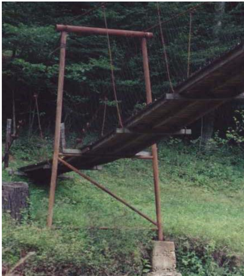
Foto 1.3-28 Empotre del pórtico a la cimentación del puente
