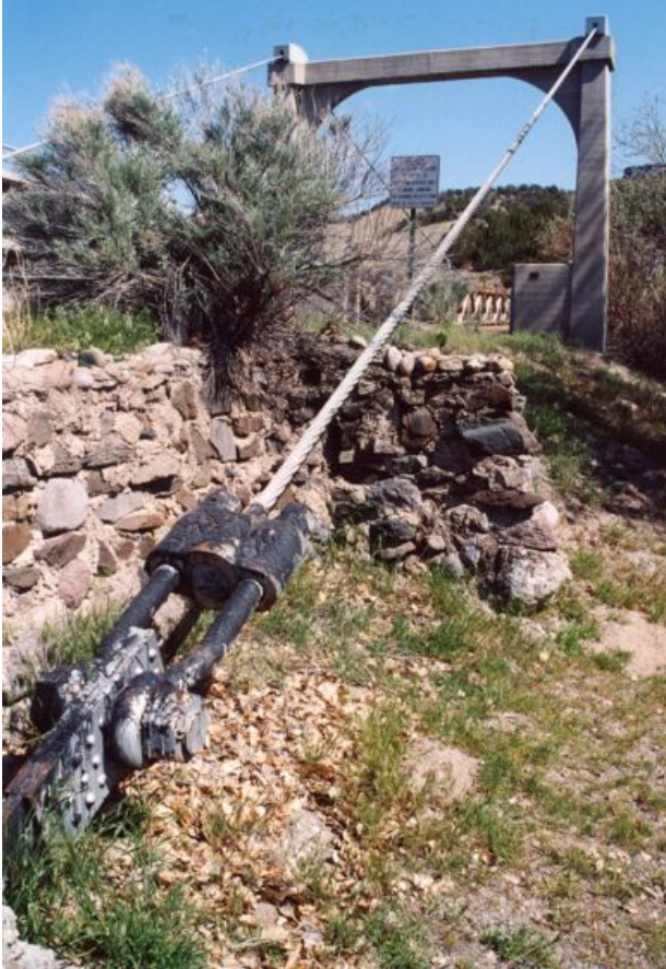
Foto 1.3-109 Detalle del sistema de anclaje de los cables con la placa de acero anclada al terreno natural
