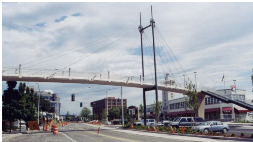
Foto 1.2-6 Vista lateral del puente West Lake Drive
