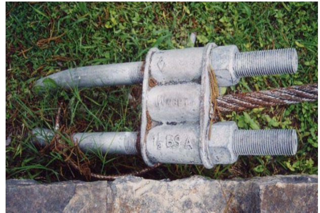
Foto 1.3-101 Detalle del anclaje de los cables al terreno natural
