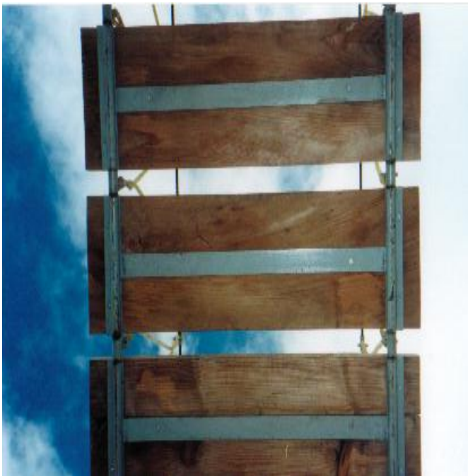
Foto 2-10 Detalle de los elementos que proporcionan el soporte y estabilidad al piso del puente
