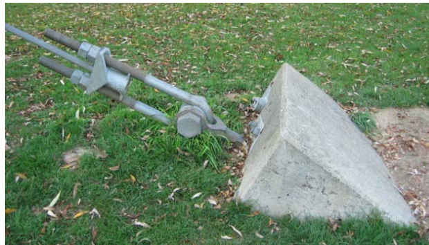
Foto 1.3-14 Detalle del anclaje del cable estabilizador de puente con la cimentación
