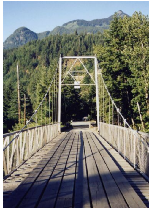
Foto 1.3-81 Detalle del doble piso de madera
