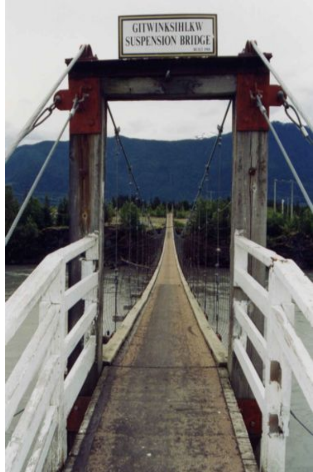
Foto 1.3-75 Vista frontal del puente
