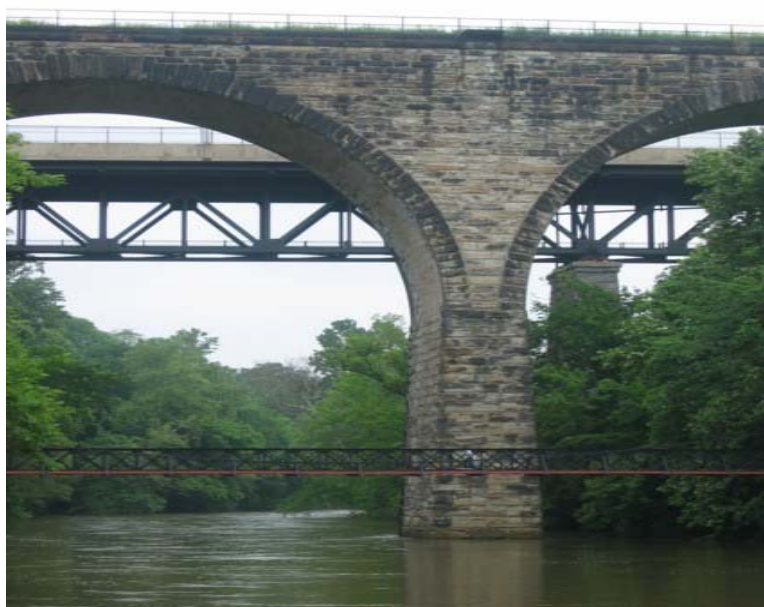
Foto 1.3-7 Vista general del conjunto estructural (puente peatonal, acueducto y puente ferroviario)
