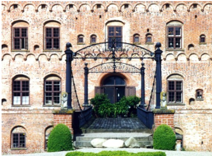
Foto 1.3-71 Vista frontal de la estructura general del puente con respecto a la fachada del castillo de Moat
