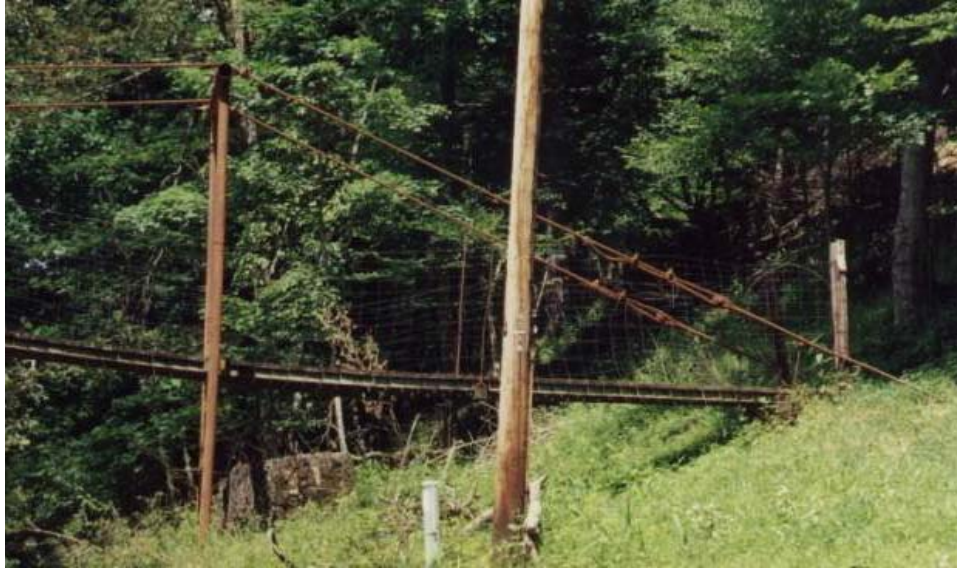
Foto 1.3-29 Posición de los cables principales sobre el pórtico y su anclaje en el piso para la estabilización del puente
