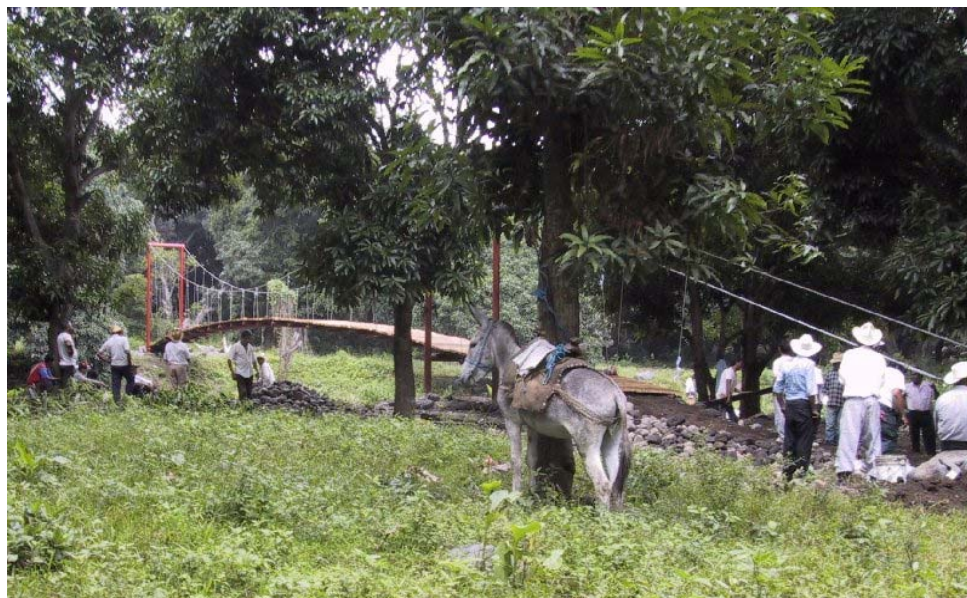
Foto 2-1 Estructura general del puente colgante a lo largo de la zona boscosa
