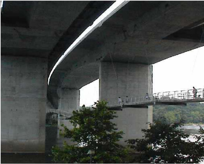
Foto 1.3-1 Vista general del puente peatonal colgante, donde se puede apreciar que se encuentra situado debajo de un puente vehicular
