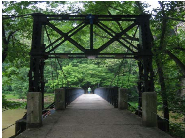
Foto 1.3-6 Posición de los pórticos respecto al nivel del terreno natural
