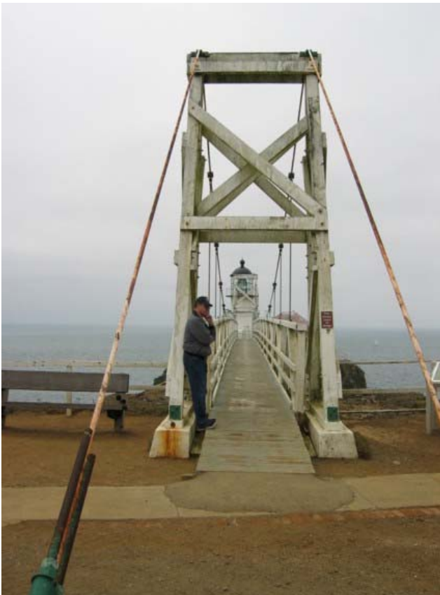
Foto 1.3-45 Detalle del anclaje de los cables principales con el terreno
