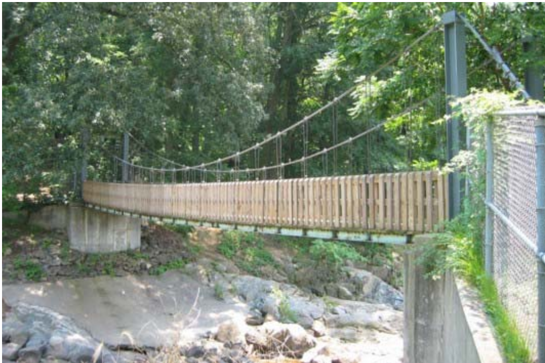
Foto 1.3-30 Vista panorámica de la ubicación del puente sobre el riachuelo, donde se aprecia todos los elementos que lo conforman
