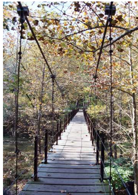
Foto 1.3-41 Detalle de los cables verticales con el barandal
