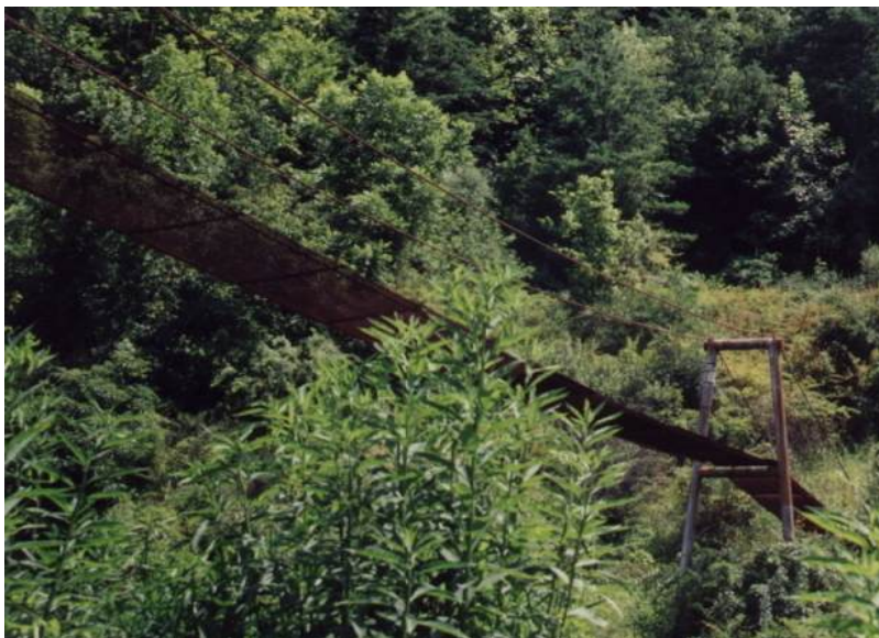
Foto 1.3-26 Detalle de la torre del primer puente y su ubicación en la zona boscosa de la provincia
