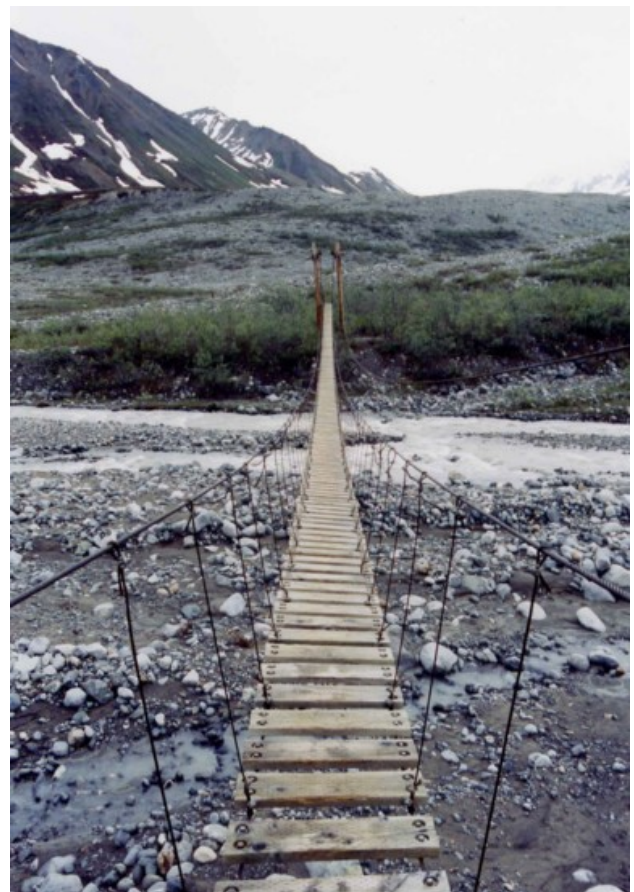
Foto 1.3-78 Detalle de la base y barandal del puente soportadas por medio de cable
