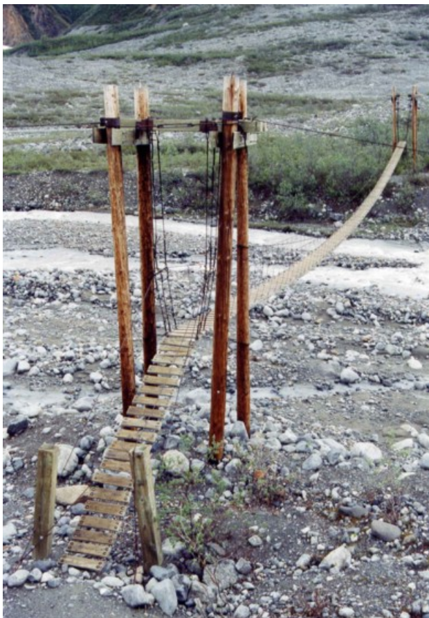
Foto 1.3-77 Detalle del tipo de materiales empleados para la construcción de esta estructura
