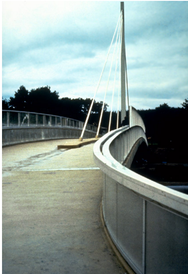
Foto 1.2-4 Visión desde la cubierta del puente y el detalle del pasamano.
