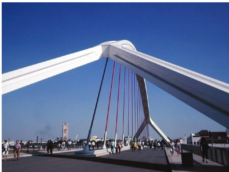
Foto 1.2-8 Puente de la Barqueta (1992)
