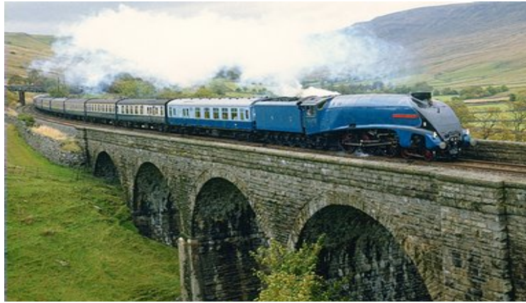
Foto 1.1-4 Puente de arcos de mampostería
