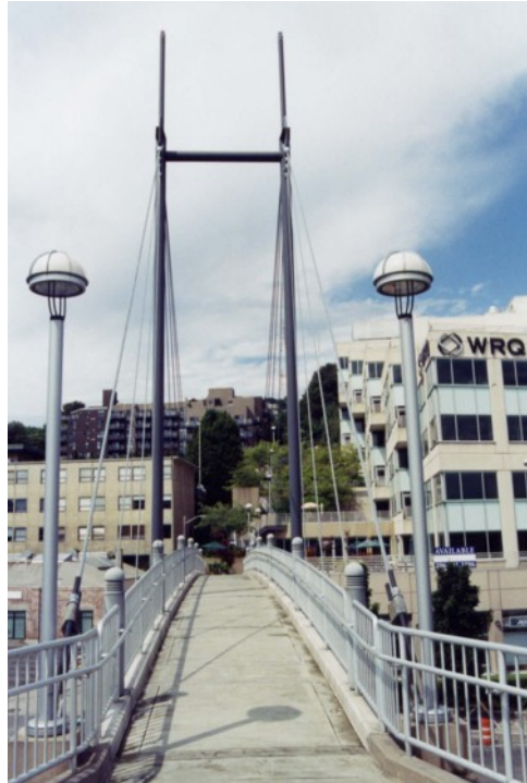
Foto 1.2-7 Vista frontal del puente West Lake Drive desde una de sus rampas
