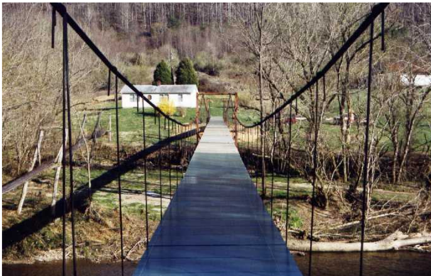
Foto 1.3-17 Posiciones de los cables secundarios con respecto a los principales, que sirven como barandales del puente
