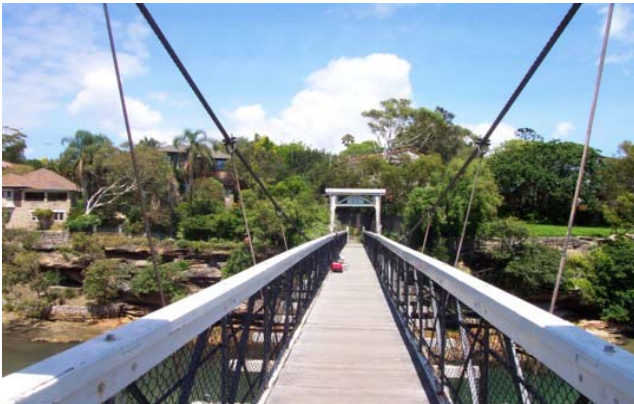
Foto 1.3-60 Posición de los cables verticales a partir del principal y hasta las vigas inferiores
