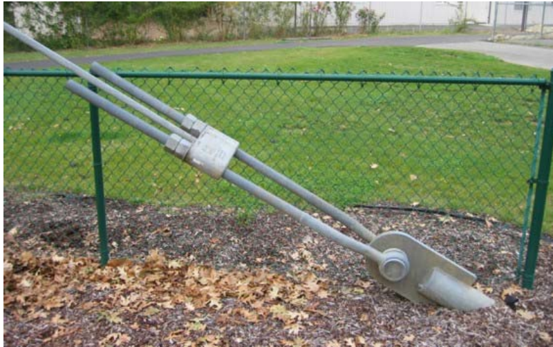
Foto 1.3-52 Detalle del anclaje del cable principal en el piso
