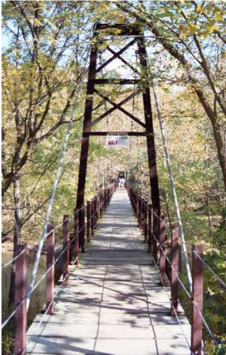
Foto 1.3-38 Vista frontal del puente en donde se aprecian todos sus elementos
