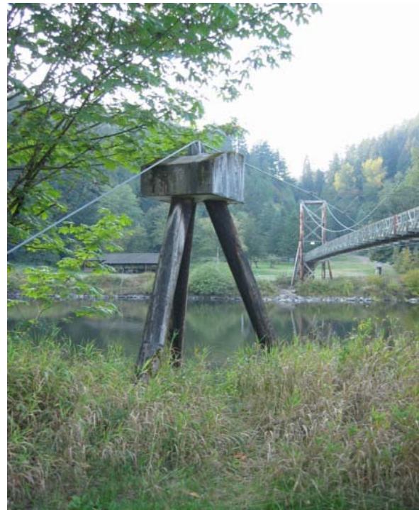
Foto 1.3-10 Detalle del elemento estabilizador del puente
