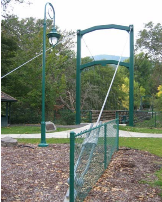
Foto 1.3-48 Detalle del anclaje de los cables principales al piso
