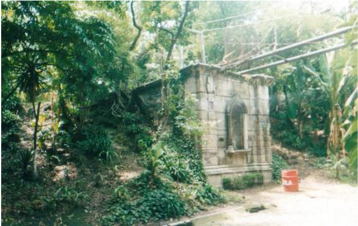
Foto 2-13 Detalle de la estructura general y de los elementos que conforman al puente a lo ancho del parque Lira
