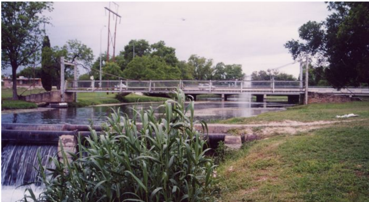
Foto 1.3-97 Panorámica general de la ubicación del puente sobre el río
