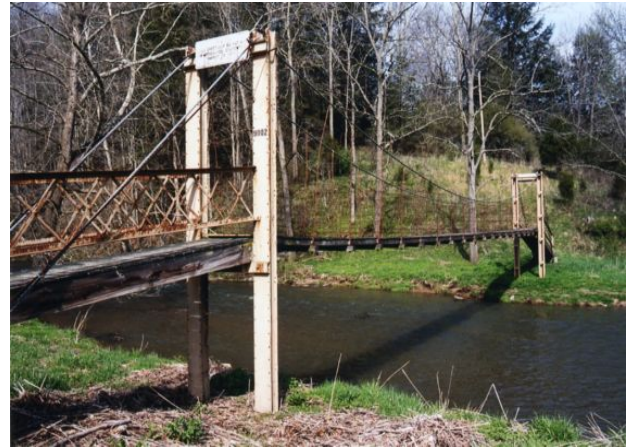
Foto 1.3-68 Detalle del anclaje del cable en el terreno y su posición en los pórticos
