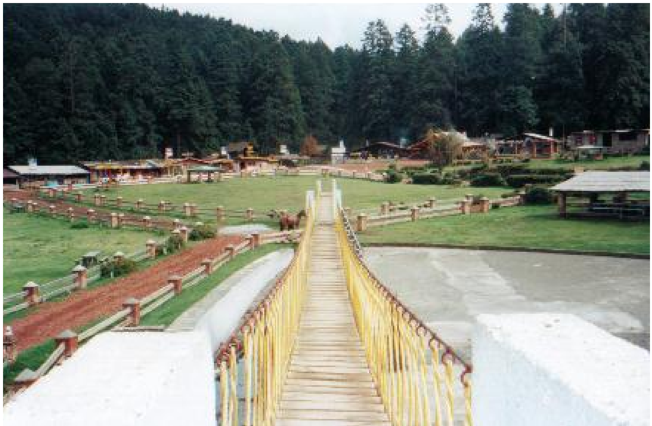
Foto 2-7 Vista frontal de los elementos estructurales que componen al puente, donde puede apreciarse la vegetación que rodea a la estructura
