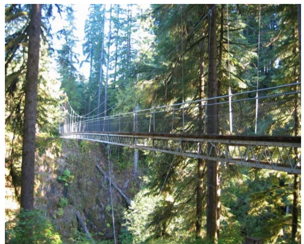
Foto 1.3-21 Barandal del puente y la posición de los cables
