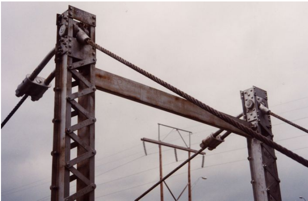
Foto 1.3-99 Detalle de los elementos que conforman la estructura de los pórticos
