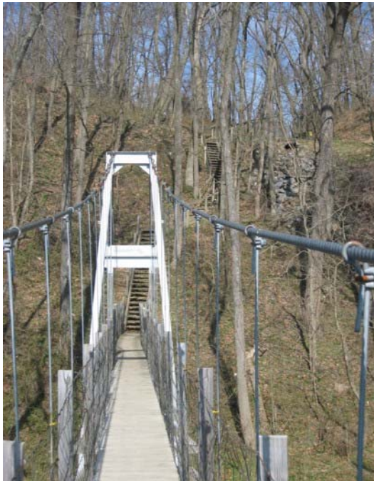
Foto 1.3-56 Posición de los cables verticales con respecto al cable principal
