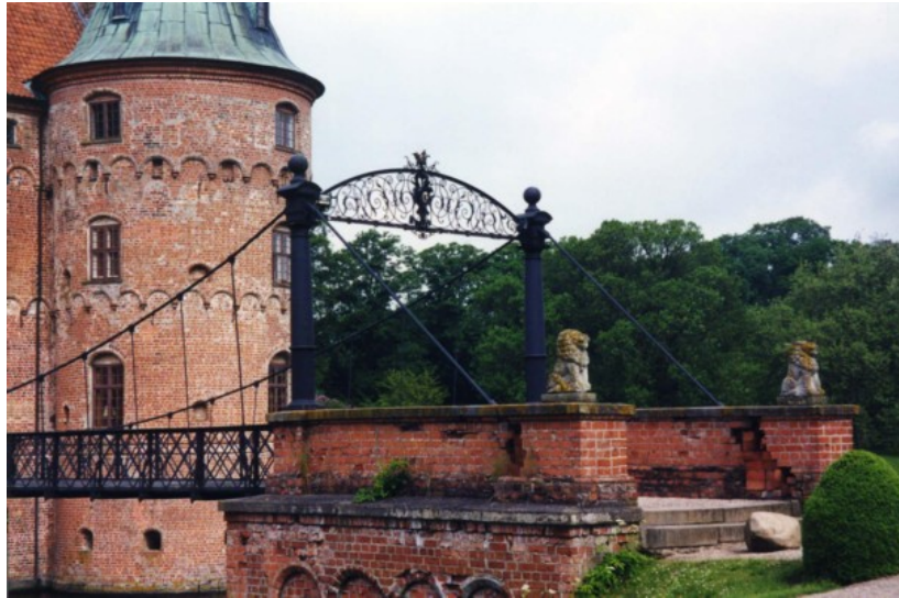
Foto 1.3-70 Detalle de los cables principales a los muretes de la entrada principal
