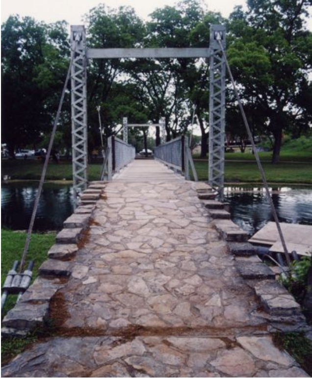
Foto 1.3-98 Detalle de las rampas y pórticos del acceso al puente
