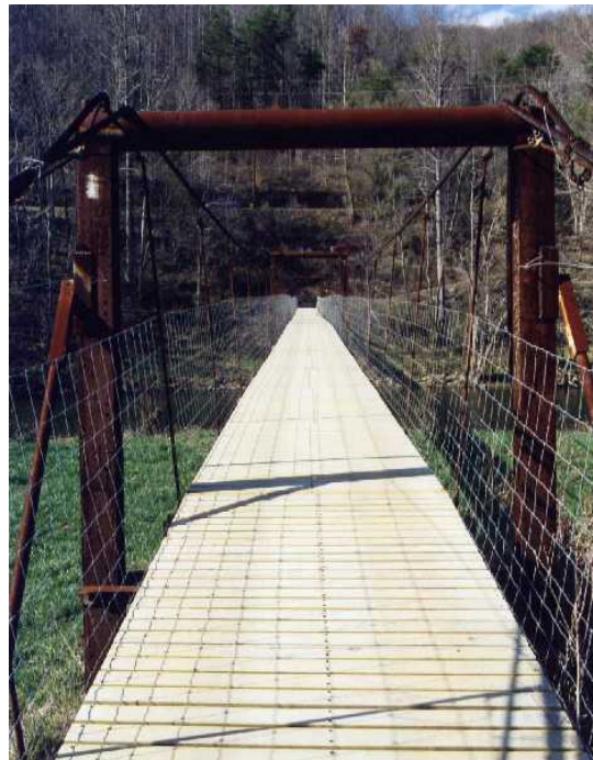
Foto 1.3-87 Detalle de los cables principales y el barandal del puente
