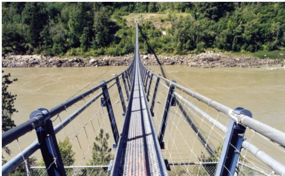
Foto 1.3-84 Detalle del sistema de piso y barandal del puente
