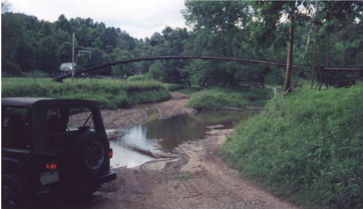
Foto 1.3-27 El segundo puente cruza la gran carretera, (el otro el camino de la provincia de Gilmer) en el punto donde la 1 ra . pasa por la provincia
