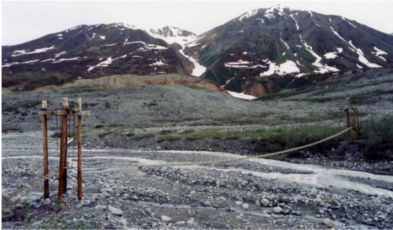
Foto 1.3-76 Vista panorámica de la ubicación general del puente en la zona montañosa de Gulkana
