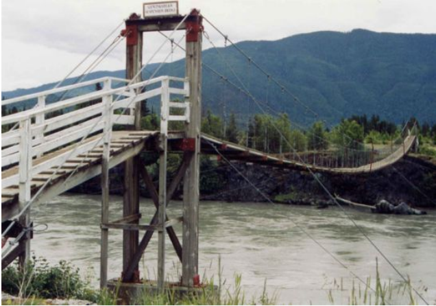
Foto 1.3-73 Detalle del atirantado lateral de los postes del pórtico
