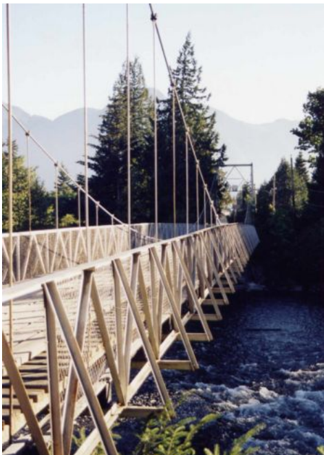
Foto 1.3-80 Detalle de las piezas prefabricadas del barandal y base del puente
