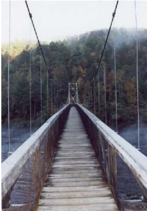
Foto 1.3-90 Vista frontal de la estructura general del puente
