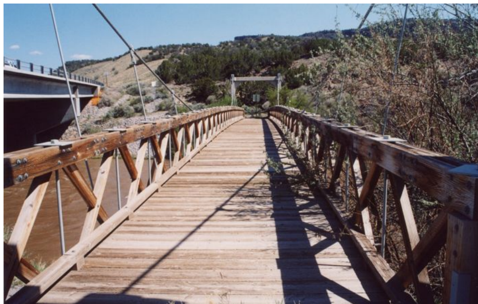
Foto 1.3-108 Vista que permite observar la posición del puente vehicular con respecto del puente colgante
