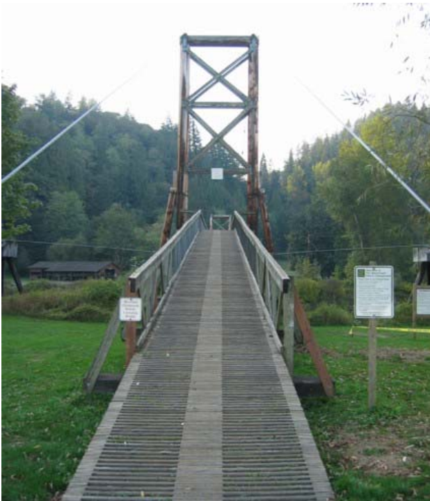
Foto 1.3-8 Vista frontal del puente, donde se puede apreciar los materiales que conforman la estructura
