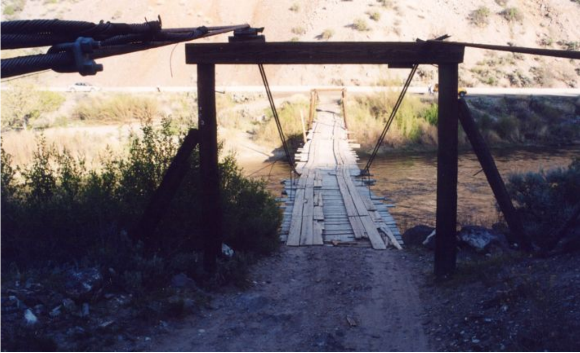
Foto 1.3-114 Detalle de la unión de los cables principales con las pequeñas columnas de madera
