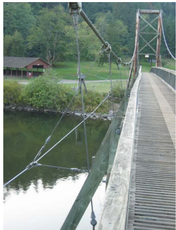
Foto 1.3-11 Ubicación y diseño de la red de cables que sostienen la base y el barandal del puente
