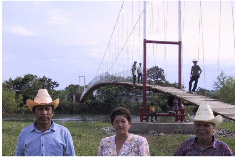
Foto 2-2 Detalle de la rampa de acceso al puente y la estructura de los pórticos
