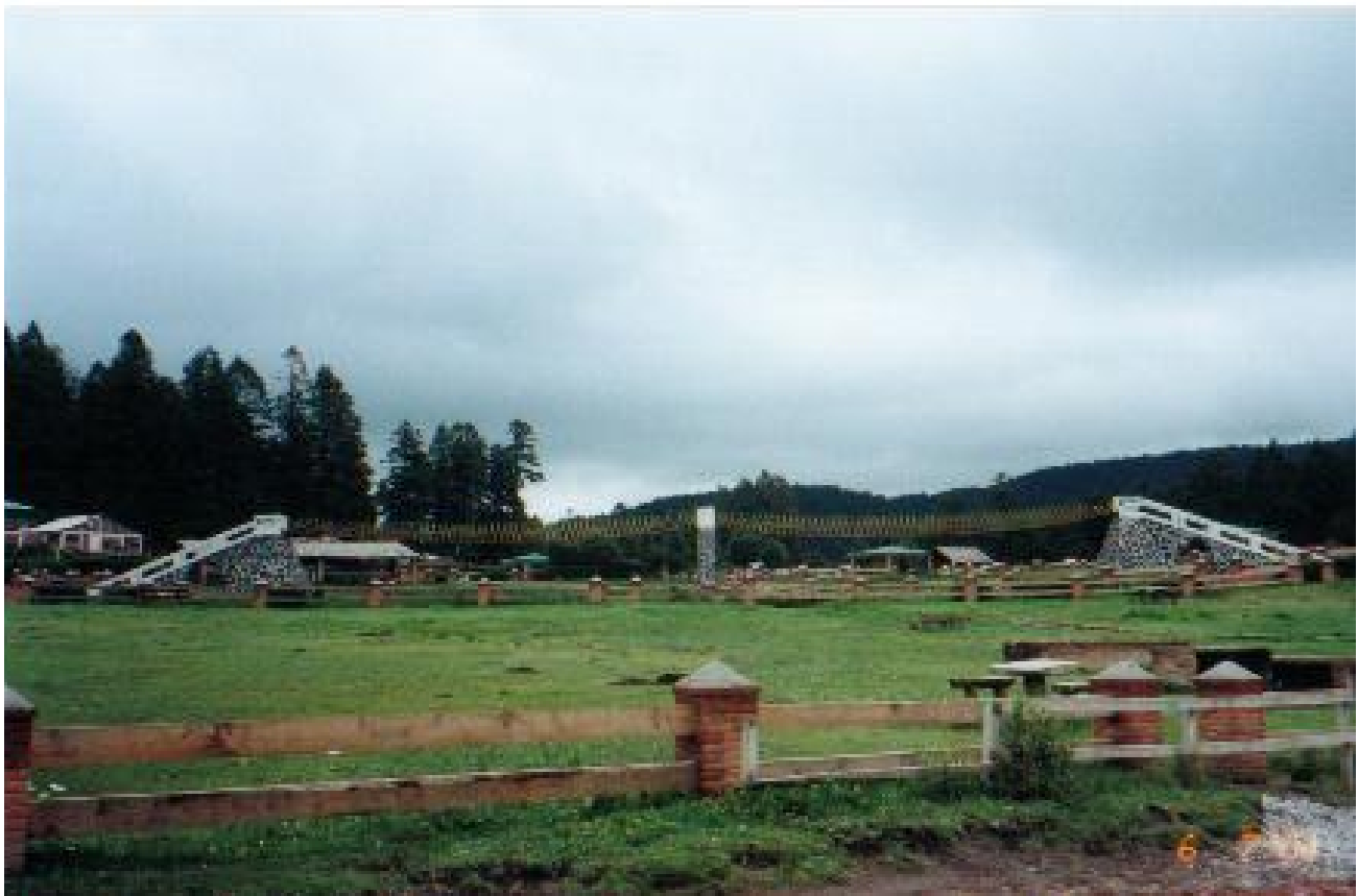
Foto 2-6 Panorámica de la ubicación y estructura general del puente colgante en la zona de la Marquesa
