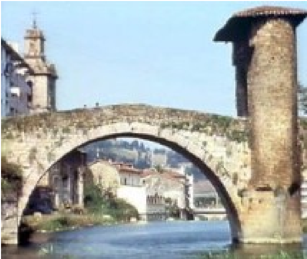
Foto 1.1-2 Puente sobre el río Ambroz Hervás (Cáceres, España.)
