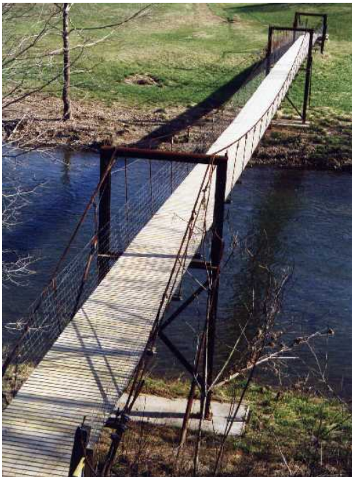
Foto 1.3-86 Detalle de los tres pórticos para salvar el desnivel entre los extremos del río
