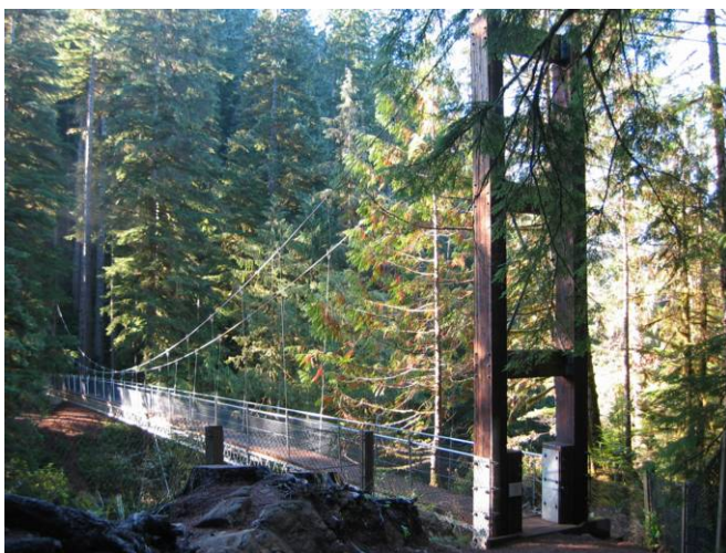
Foto 1.3-20 Vista general del puente a través de la cañada
