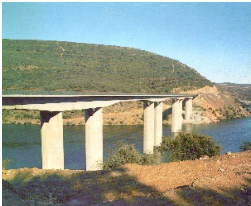
Foto 1.1-7 Puente de concreto armado
