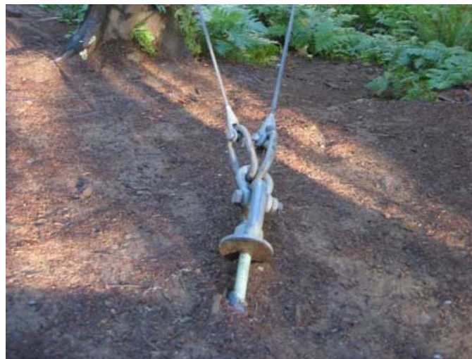
Foto 1.3-24 Anclaje de cables independientes a la barranta
