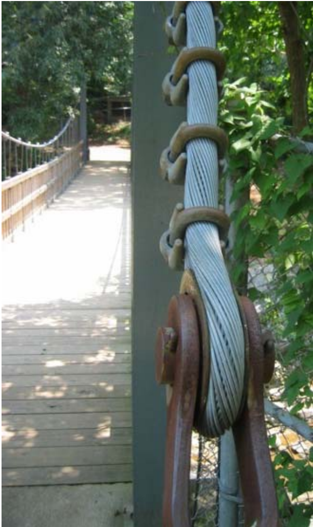
Foto 1.3-35 Amarre del cable al templador sujetado por perros
