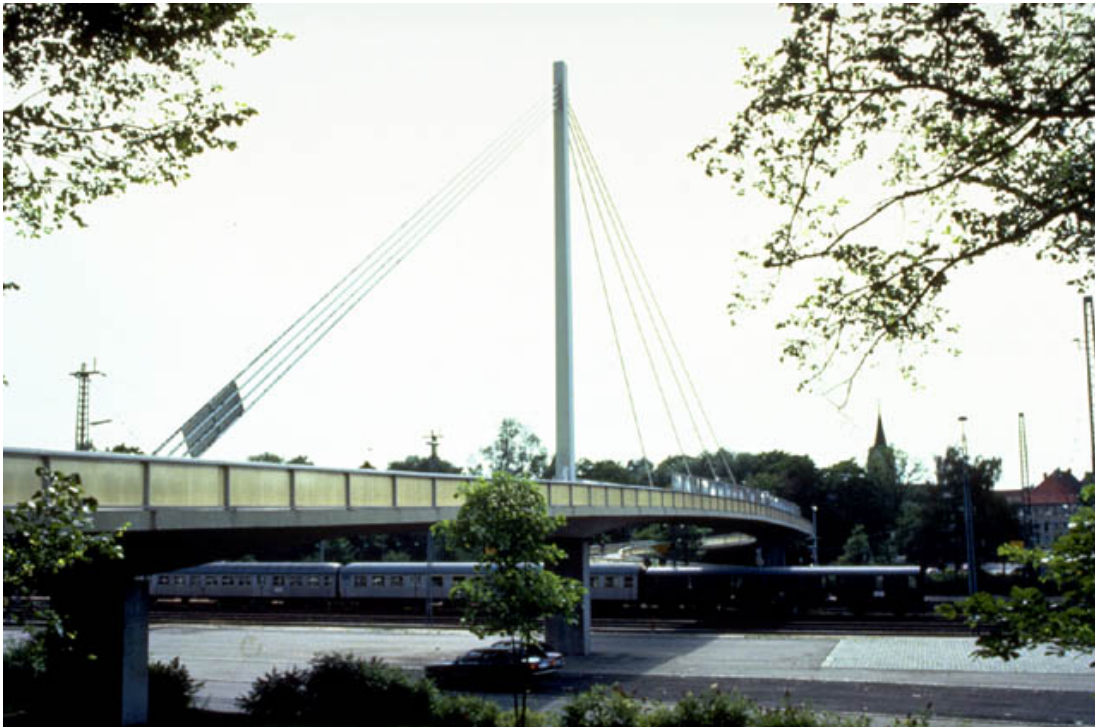
Foto 1.2-3 Puente peatonal en Villingen
