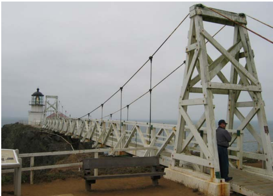
Foto 1.3-43 Detalle de la posición de los cables principales en lo alto del pórtico
