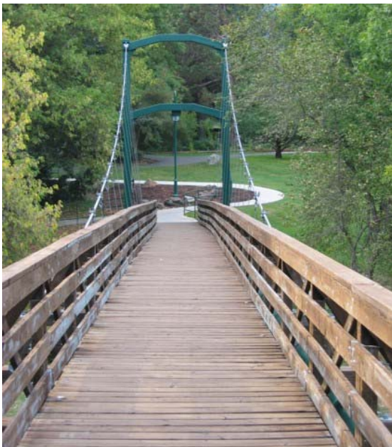
Foto 1.3-49 Vista frontal de puente donde se observa el tipo de materiales
