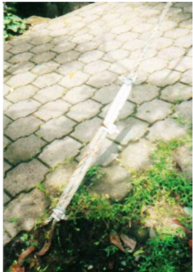
Foto 2-15 Anclaje y tensado de los cables que permiten la estabilidad de la estructura
