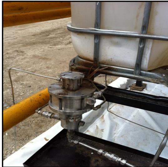
**Fig 3. Mala Instalación de Dosificador de Químico**
