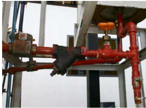
Figura 3.21. Válvula de purga y suministro de vapor al destilador
