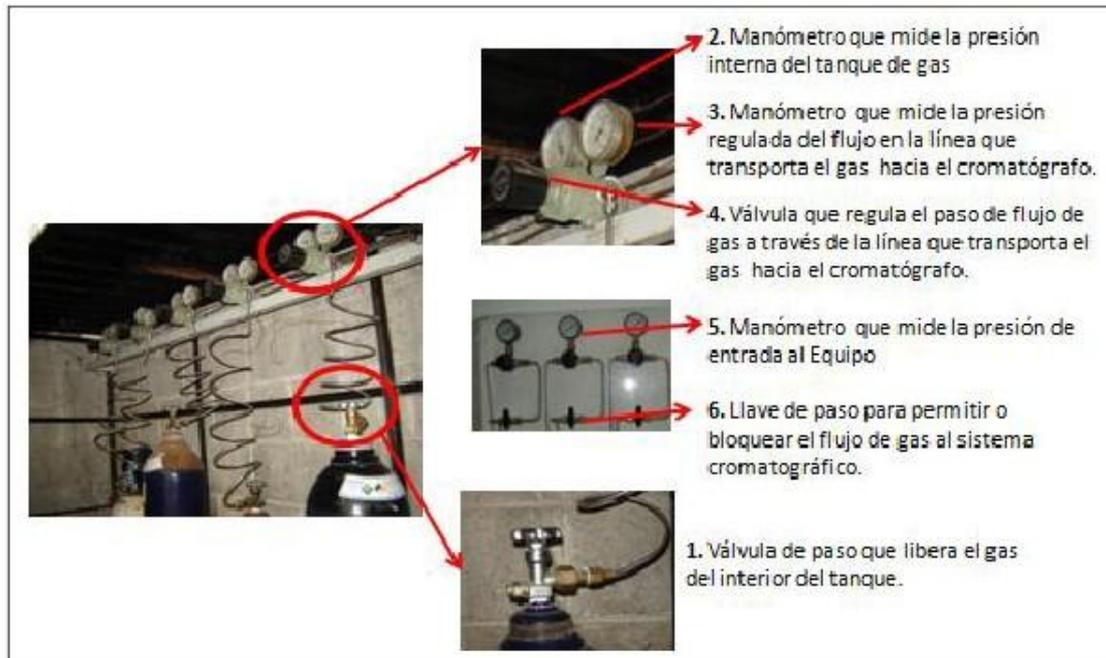
Figura 3.8. Mamómetros de los gases.
