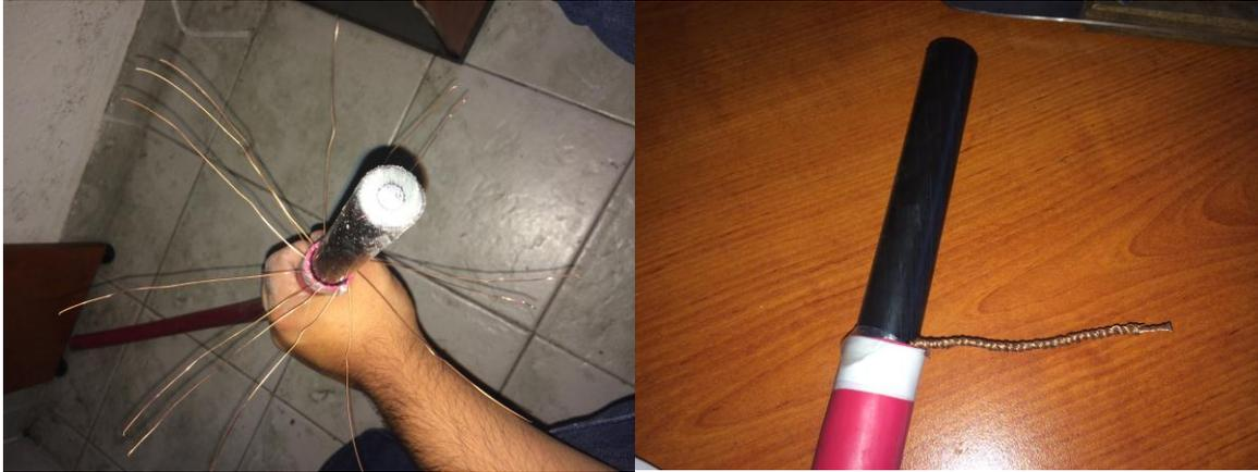
**Figura 30 Retiro de pantalla metálica**
