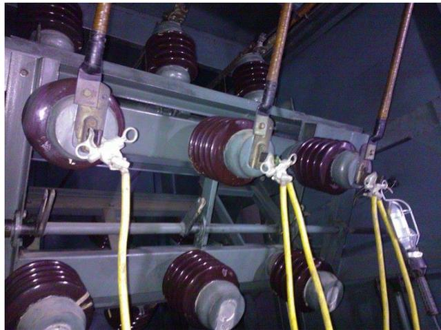
**Figura 38 Puesta a tierra de cables y equipos**
