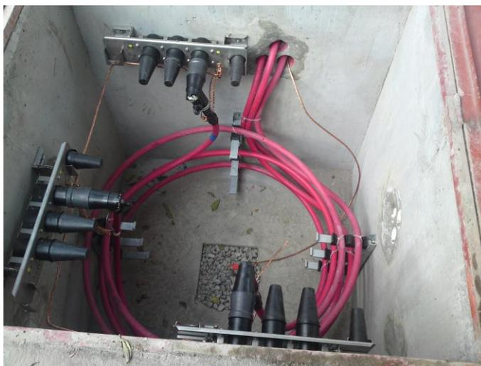
**Figura 2 Línea subterránea de media tensión 23kv**
