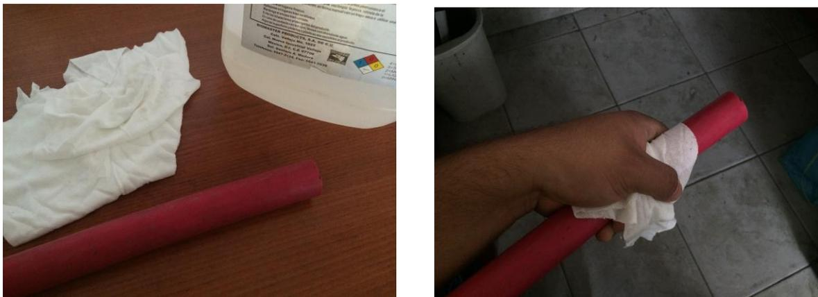
**Figura 23 Limpieza de conductor con solventes dieléctricos**
