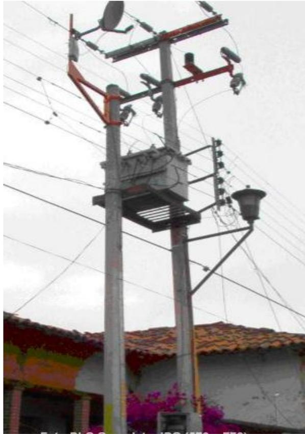
Fig. 1.7 Unidad de Acoplamiento
