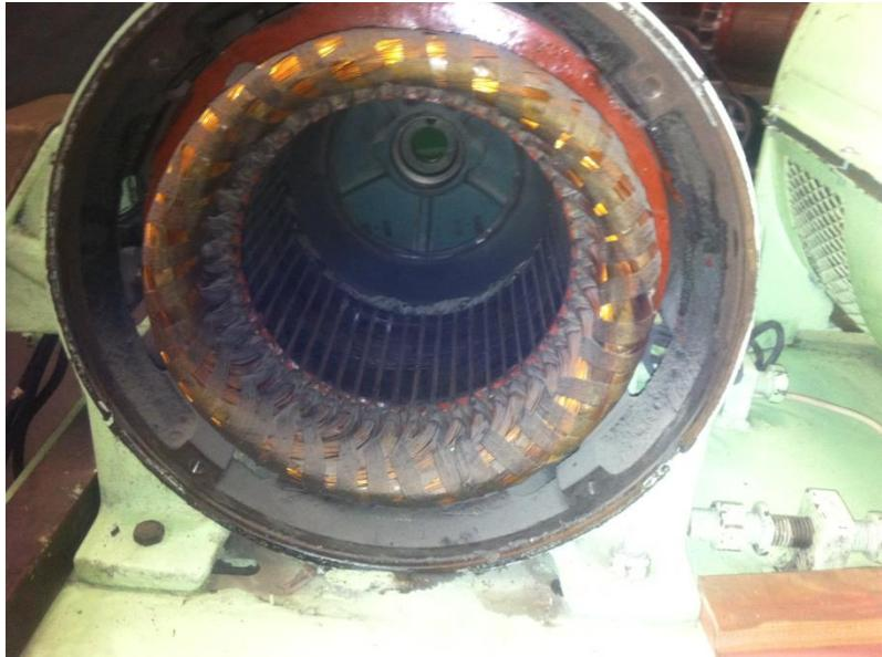
*Ilustración 25. Estator del motor de CA, cubierto por una capa de polvo.*
