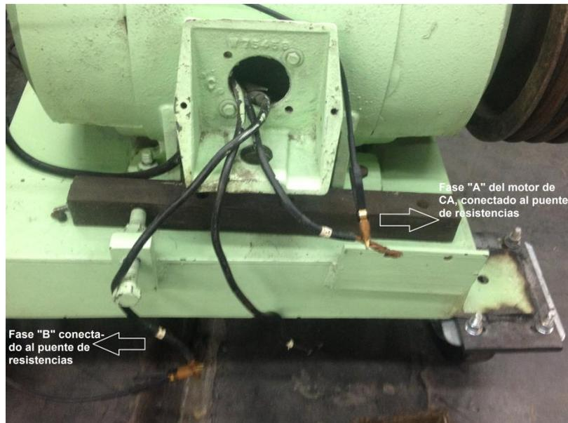
*Ilustración 35. Medición de los devanados del motor entre las fases "A" y "B".*
