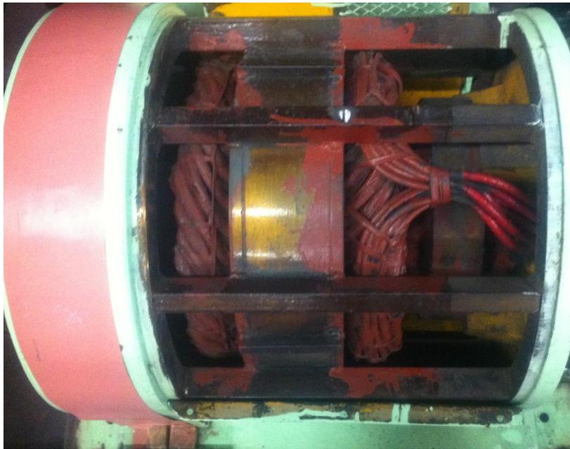
*Ilustración 54. Limpieza al estator del generador síncrono de 15 kW.*
