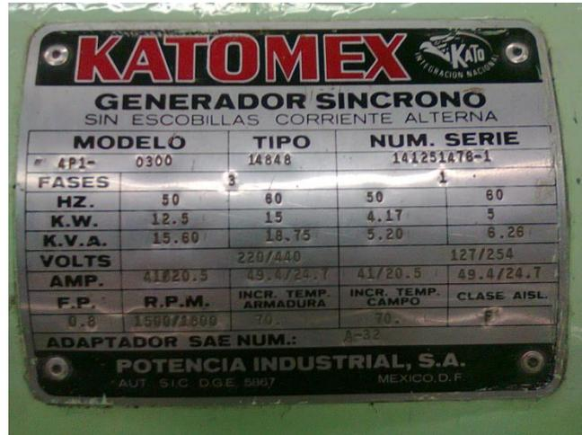
Ilustración 20. Placa de características del generador de 15 kW.
