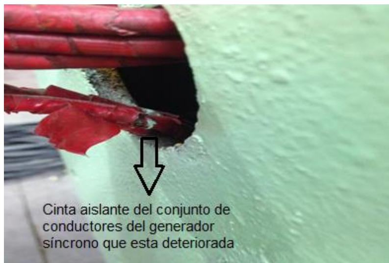
*Ilustración 65. Conductores de las fases afectados por la carcasa del generador.*
