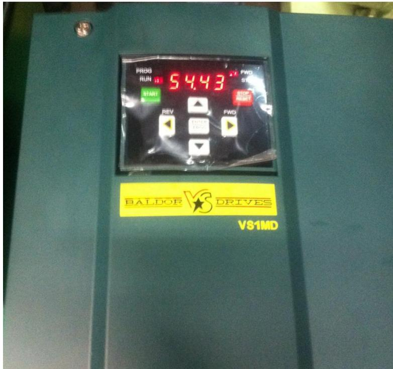
Ilustración 76. Control de la frecuencia por medio del "drive" [Manual. BALDOR DRIVERS VS1MD, 2014].
