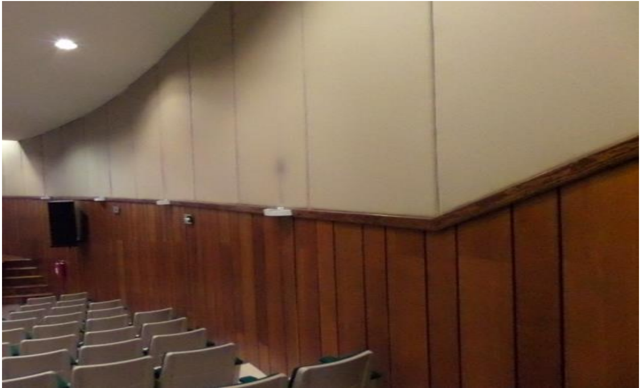
Figura 2.12. Pared con madera y paneles acústicos de yute
