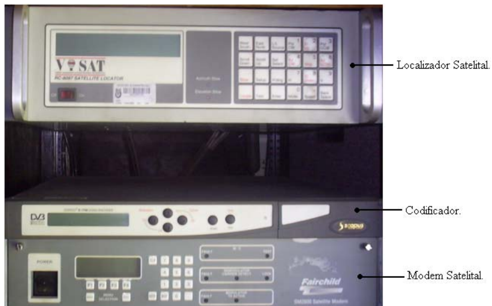
Fig. I.5 Modem satelital, codificador y localizador satelital.
