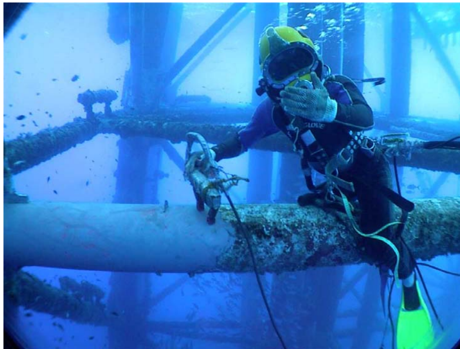
Figura K3. Buzo trabando en los miembros estructurales de una plataforma marina.
