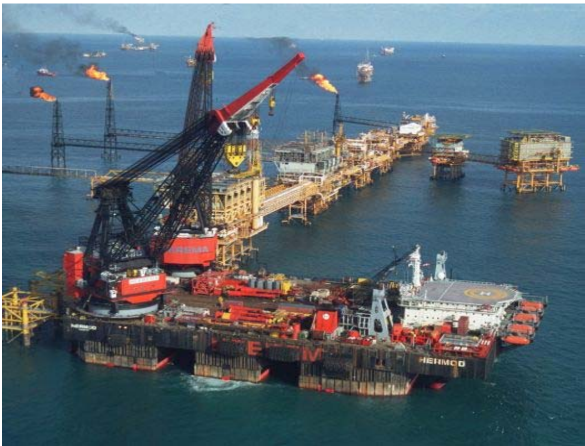
Figura 4.7. Ejemplo de operaciones en un complejo de plataformas marinas. (Fotogalería, 2011).
