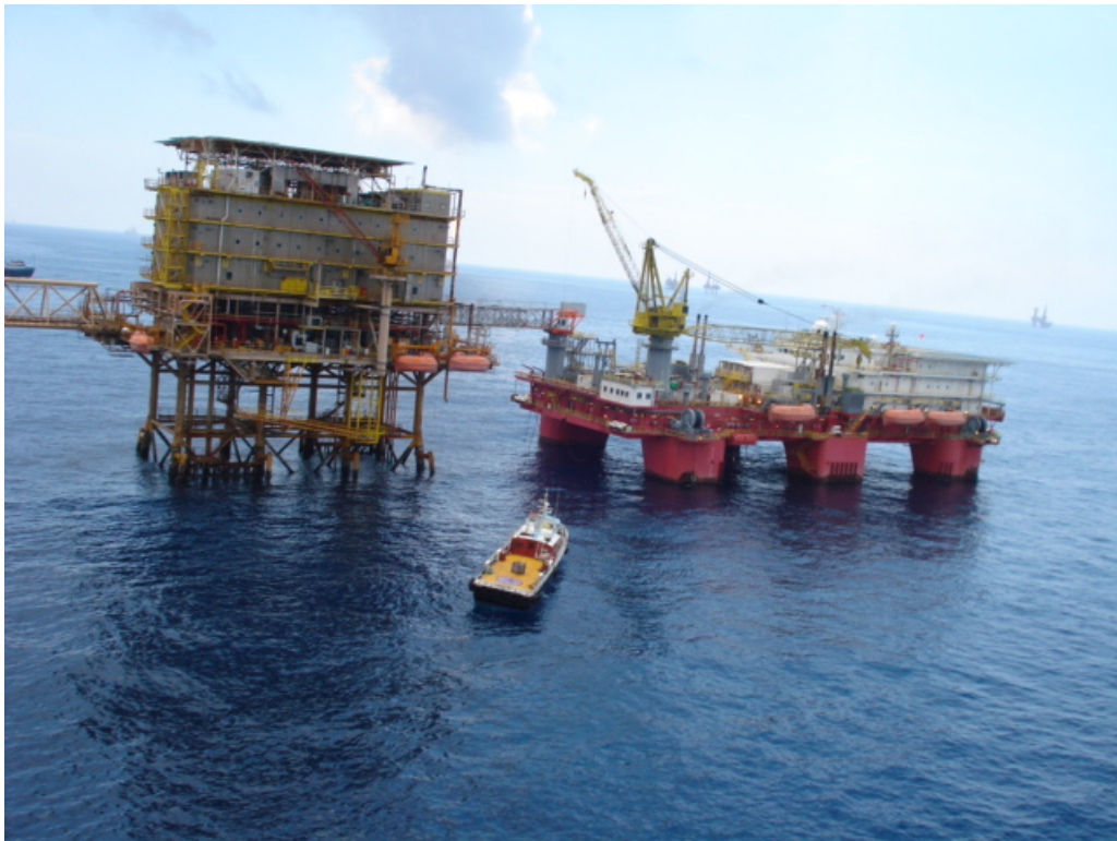
Figura 4.6. Ejemplo de operaciones en una plataforma marina. (Pemex, 2008).
