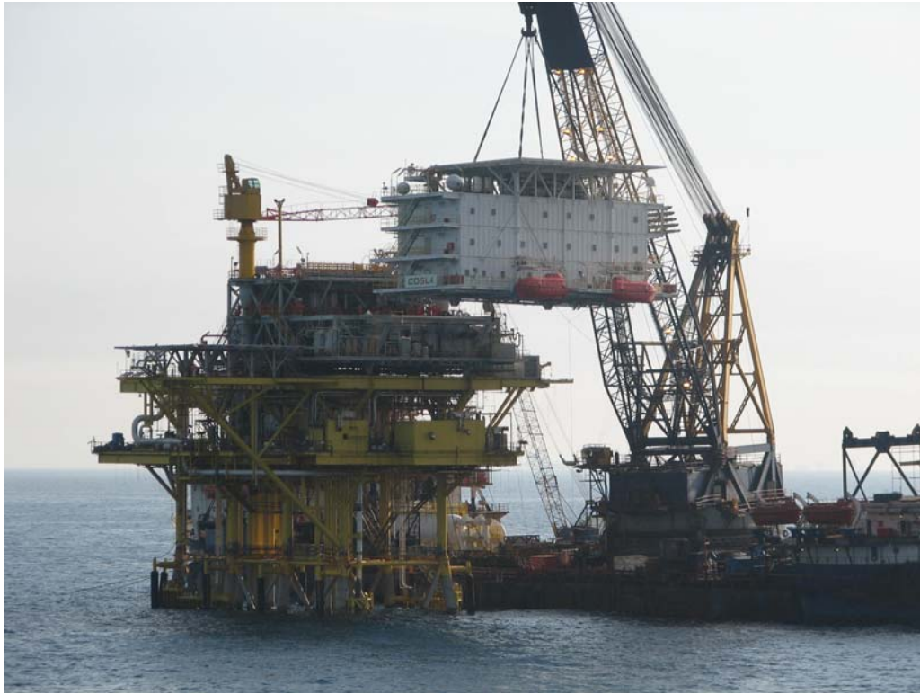
Figura 4.5. Ejemplo de operaciones con grúas en una plataforma marina. (Pemex, 2008).
