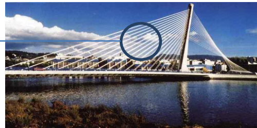
Figura 26b. Cables de acero en puentes atirantados
