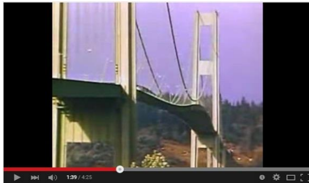
Figura 18c. Puente de Tacoma oscilando por cargas de viento que lo hicieron entrar en resonancia
