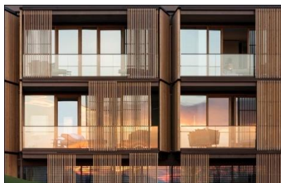
Imagen 5. Detalle en fachadas Lanserhof Tegernsee. Todas las habitaciones gozan de iluminación natural controlada con elementos tipo
