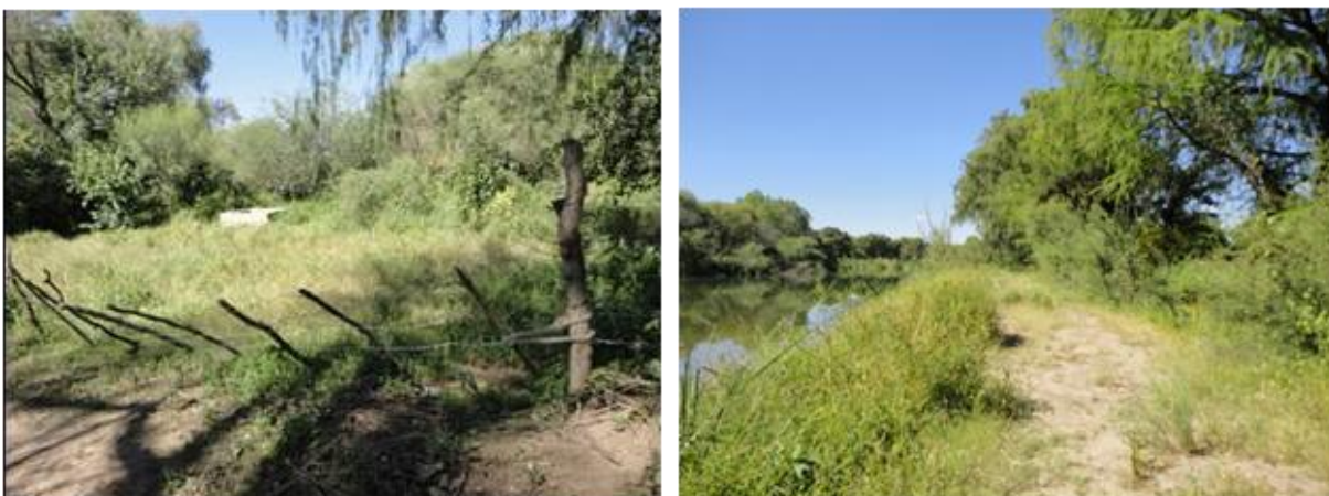
Figura 31. Acceso a laguna de oxidación del municipio de Nombre de Dios.
