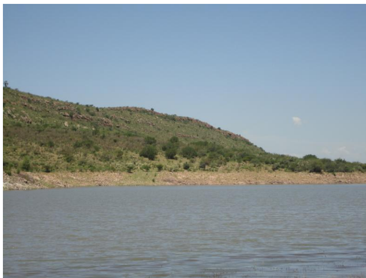
Figura 15. Vista panorámica de la Presa Contalpa.
