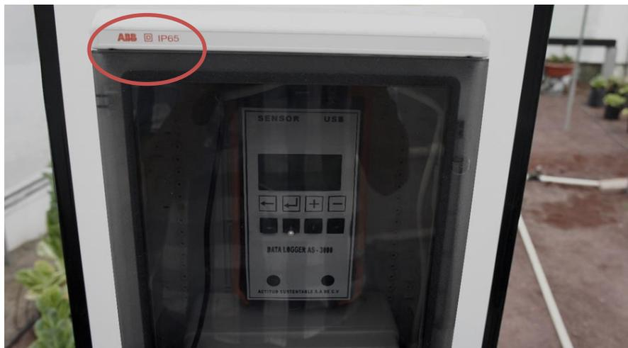
Fig. 5.9. Caja de Protección con un grado IP65 marca ABB.
