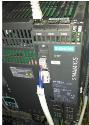
*Fig. 34.- Variador de velocidad para motores de bombas, en tablero eléctrico general.*
