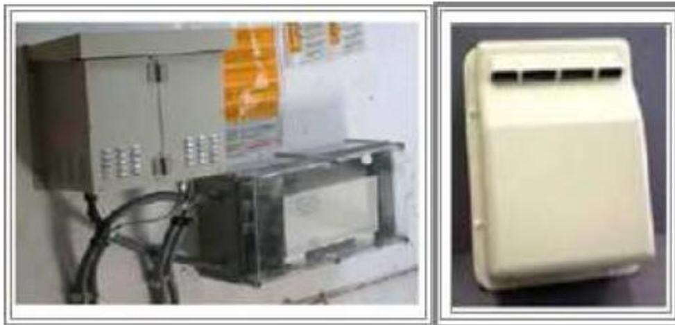
Figura 2.18 Unidad de Acondicionamiento instalada en una Cámara de Transformación
