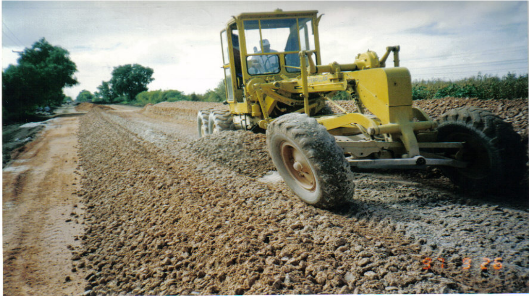
Ilustración No.IV.7. Motoconformadora mezclando los materiales que constituyen las diferentes capas del pavimento.
