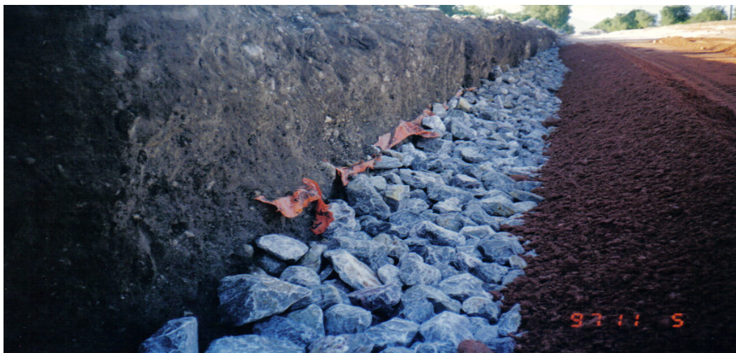
Ilustración No. VI.43. Formación de las capas superiores del piedraplen para alcanzar el nivel óptimo de terracerías.
