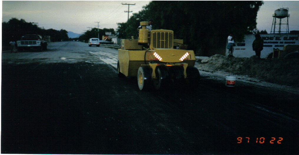
Ilustración No. IV.10. Compactador neumático compactando carpeta asfáltica.
