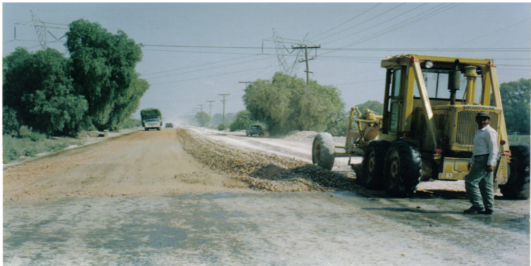
Ilustración No.IV.6. Motoconformadora para el tendido de los materiales que forman las diferentes capas que constituyen el pavimento.
