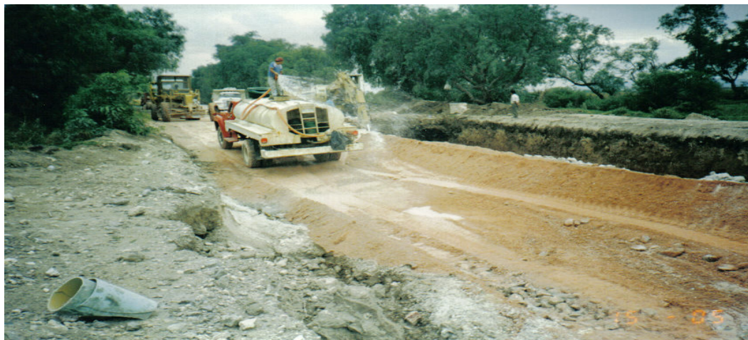
Ilustración No. VI.44. Aplicando humedad a las capas superiores del piedraplen.
