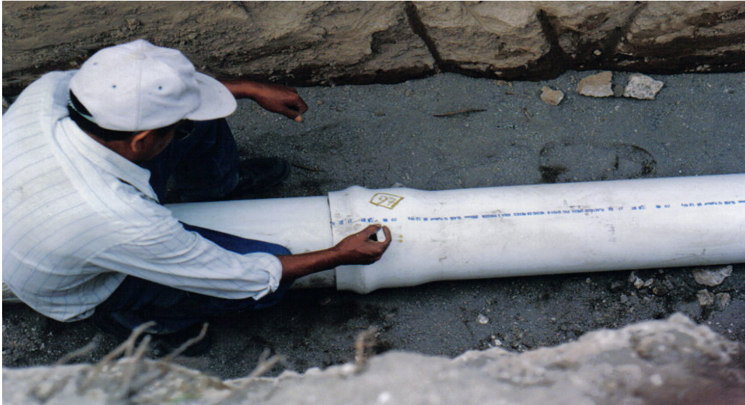
Ilustración No.VI.46. Tendido de tubo para S.A.P. sobre la cama de arena.
