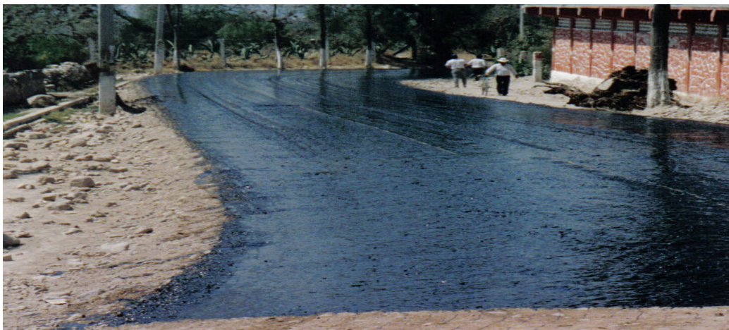
Ilustración No. VII.11. Riego de impregnación.
