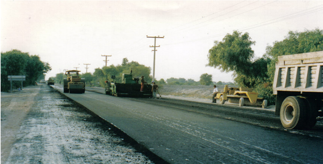
Ilustración No.VI.17. Tendido y compactación de la mezcla asfáltica.
