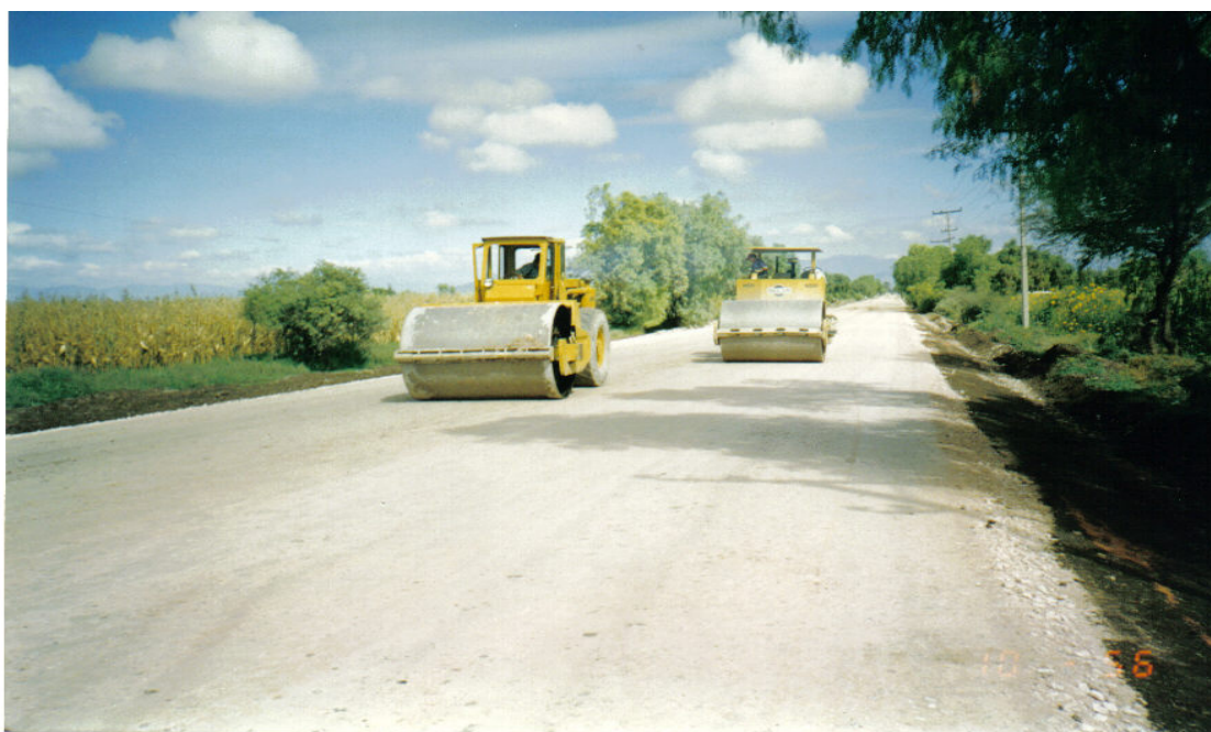
Ilustración No. VI. 11. Compactación de la base hidráulica, con rodillos lisos vibratorios. Se puede observar el cuneteo sobre el terreno, en el hombro del camino, como obra complementaria de drenaje.
