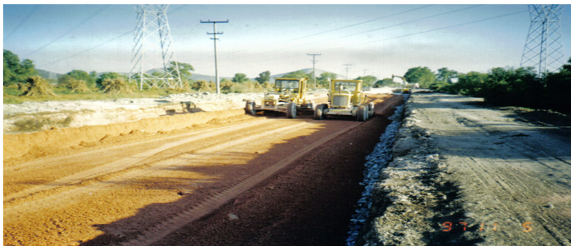
Ilustración No. VI.45. Formación de las capas superiores del piedraplen con materiales seleccionados.
