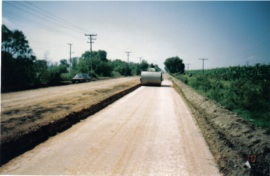
Ilustración No. VI.4. Compactación de la capa de subrasante en los hombros de la ampliación.
