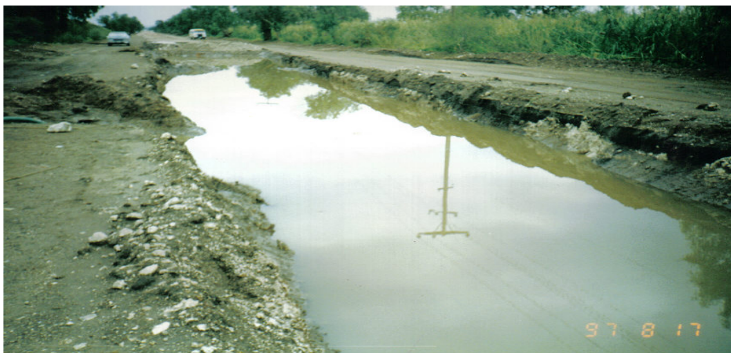
Ilustración.No.VI.40. Abatimiento del nivel del agua en la falla geológica.
