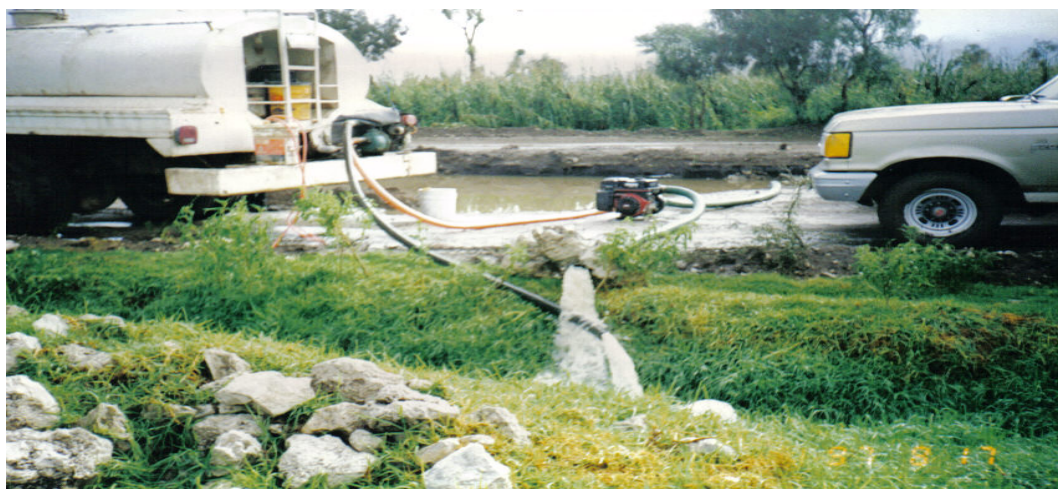
Ilustración No.VI.41. Abatimiento o achique del agua con motobomba de la falla geológica.
