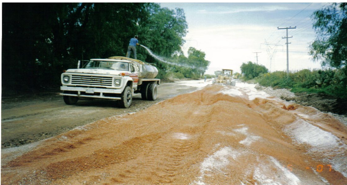
Ilustración No. VI. 10. Acamellonamiento, donde se puede ver el mezclado con cal para estabilizar la base, con motoconformadora, incorporando agua en pipa.
