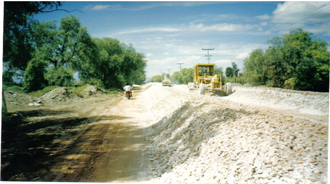
Ilustración. No. VI. 9. Estabilización de la base, mezclado y acamellonado.
