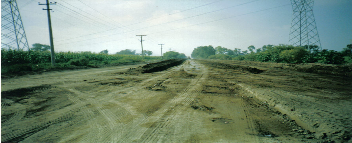
Ilustración No.VI. 6. Escarificado, disgregando el pavimento existente, mezclando y acamellonando.
