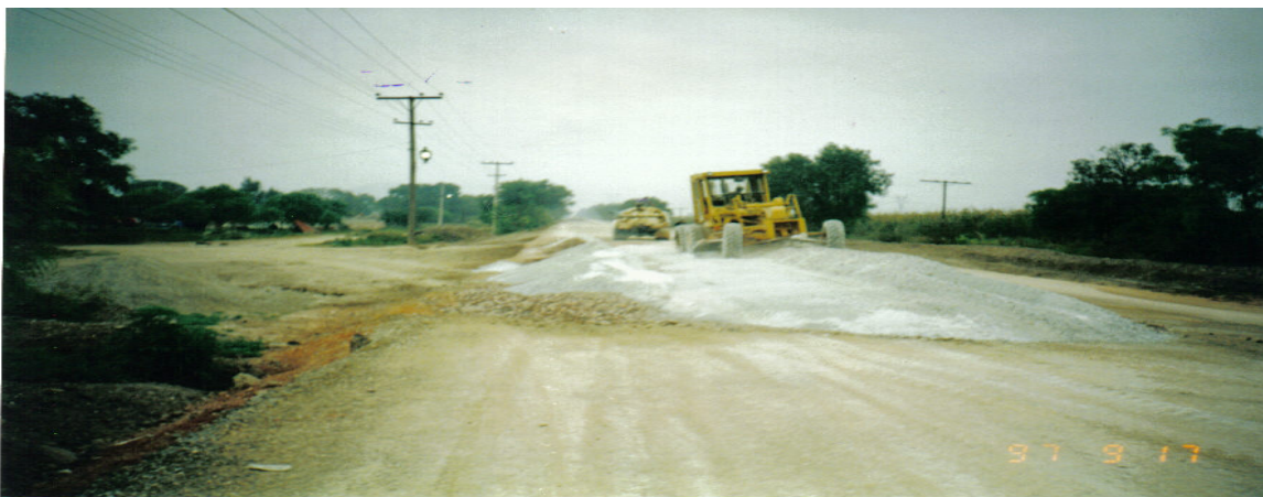
Ilustración No. VI.7. Estabilización del material con una capa de cal.
