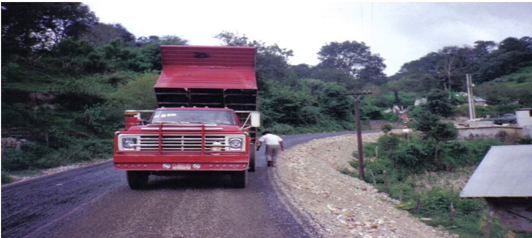
Ilustración No. VII.13. Segundo riego de sello 3-A.
