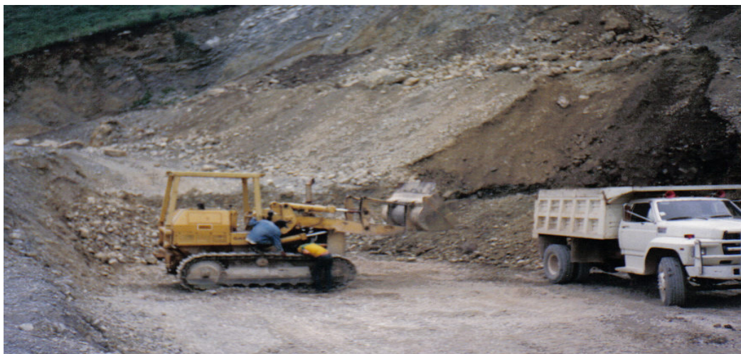
Ilustración No. VII.5. Banco de material para la base.
