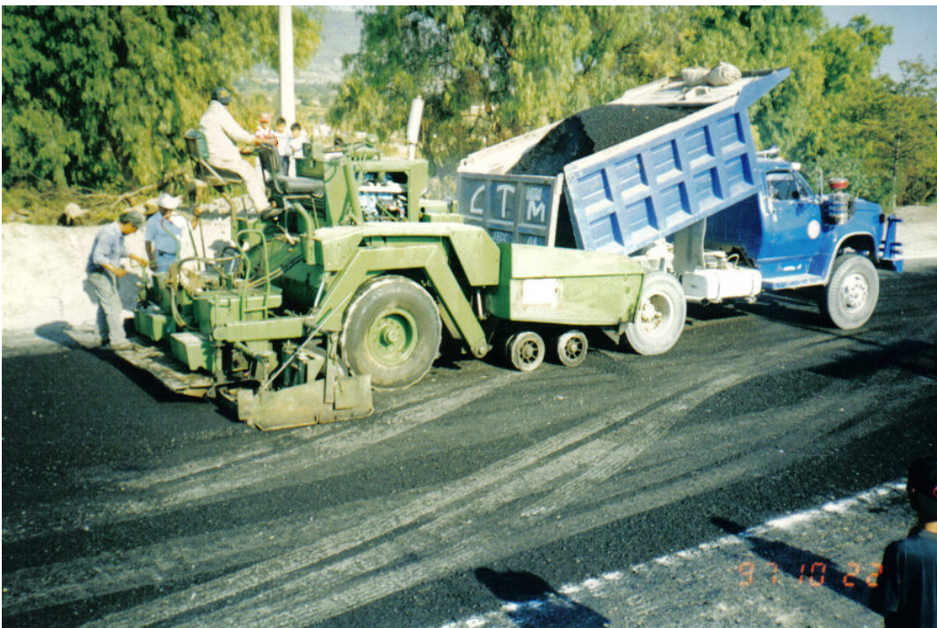
Ilustración No.VI.17. Tendido y compactación de la mezcla asfáltica.
