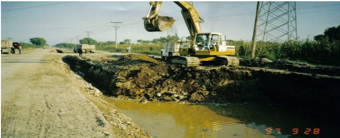
Ilustración No. VI.33. Excavando material fatigado de la falla geológica.
