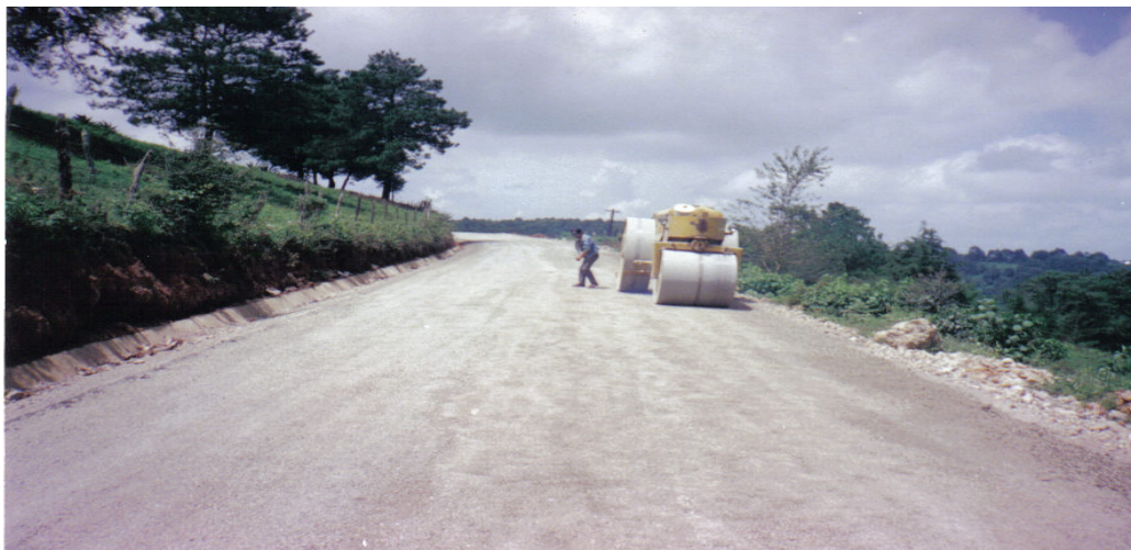
Ilustración No. VII. 8. Base hidráulica y obra de drenaje, formación de cuneta de concreto hidráulico.
