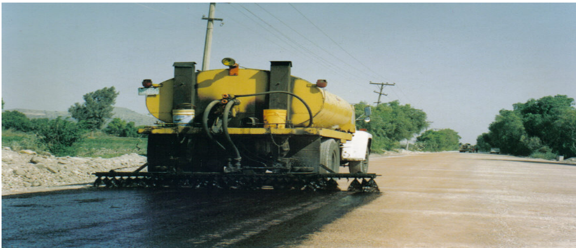
Ilustración No. VI. 13. Base barrida y preparada para la aplicación del riego de impregnación con petrolizadora.
