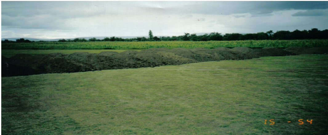
Ilustración No. VI. 27. Protegiendo el medio ambiente, colocando los materiales producto de las excavaciones, en lugares apropiados para su aprovechamiento.
