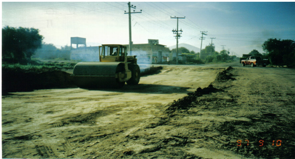
Ilustración No. IV.11. Rodillo vibratorio para compactación de terracerías.
