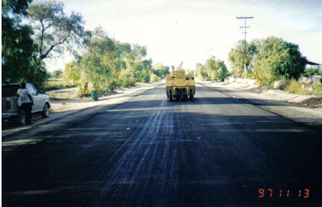
Ilustración No. VI.19. Compactación sobre carpeta con neumático, para cerrar poros.
