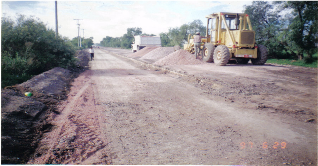
Ilustración No. IV. 5. Motoconformadora, utilizada para los procesos de construcción de las capas de subrasantes, sub-bases y bases.
