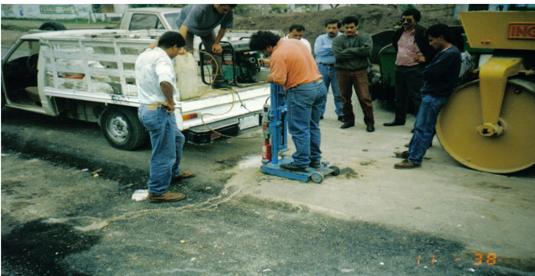
No.VI.30. Laboratorio extrayendo corazones en la carpeta asfáltica para cálculo de espesor.
