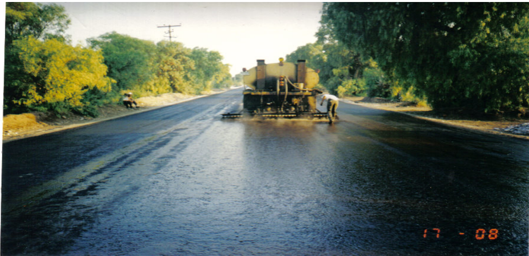
Ilustración No. IV. 14. Petrolizadora, cuya función es aplicar los riegos asfálticos: de impregnación y de liga.
