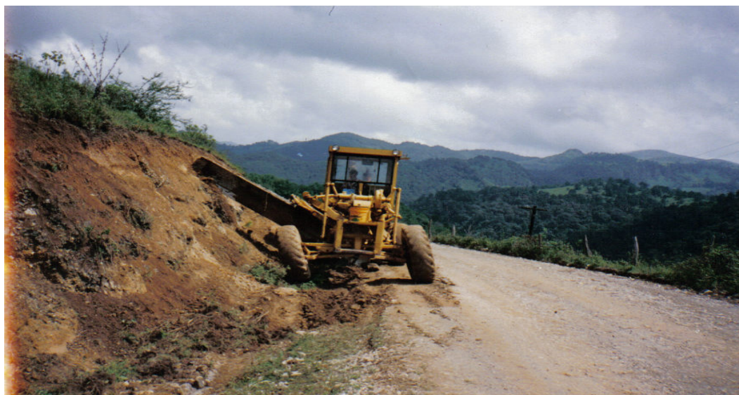
Ilustración No.VII.2. Excavación en corte lateral de ampliación de sección.
