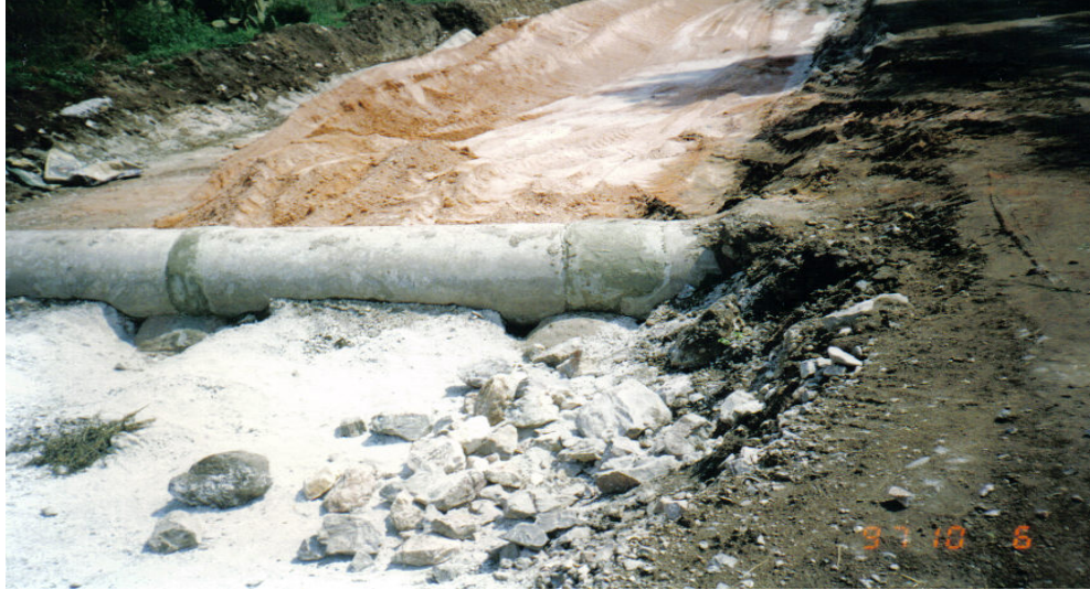
Ilustración. No.VI.25. Proceso constructivo de obras de drenaje en el camino, a través de tubería de concreto reforzado.
