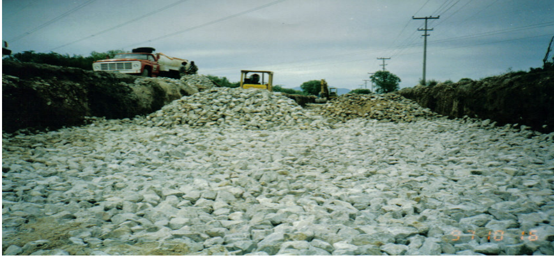
Ilustración No.VI.35. Tendido de material tamaño 10" para piedraplen.
