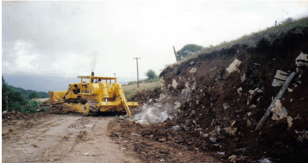
Ilustración No. VII.1. Excavación lateral y debajo de la subrasante.
