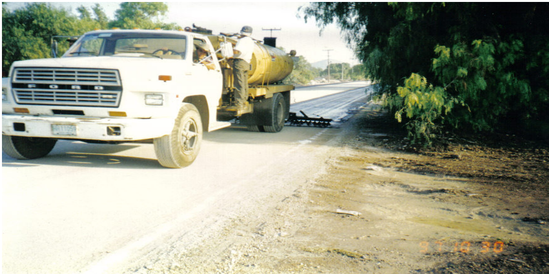
Ilustración No. VI.14. Petrolizadora realizando riego de impregnación.
