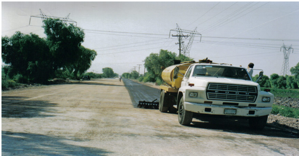
Ilustración No. IV. 13. Petrolizadora aplicando el riego de impregnación.
