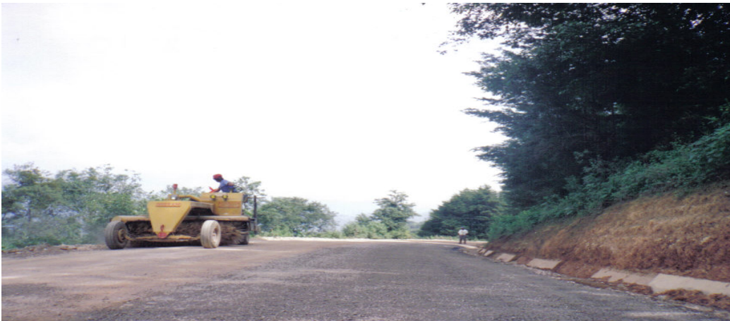
Ilustración No. VII.10. Barrido mecánico de la base.
