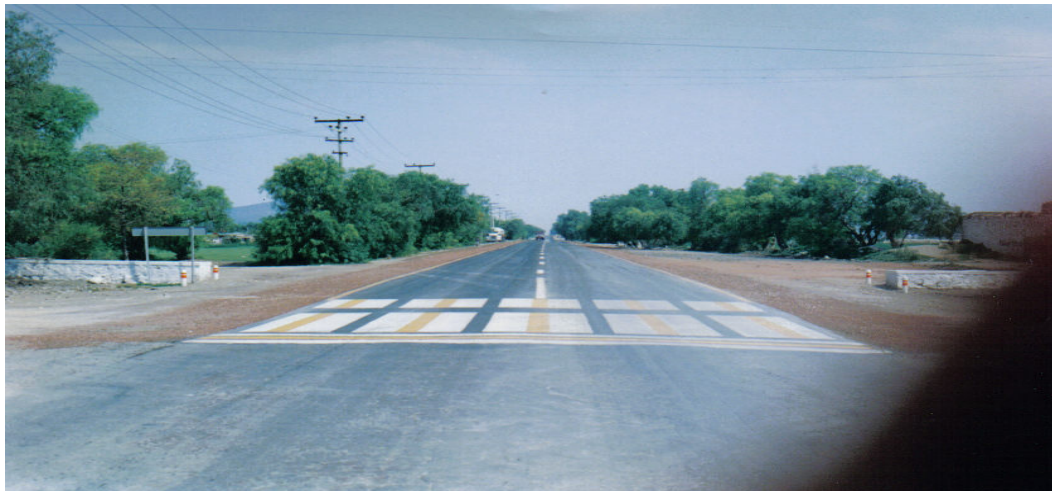
Ilustración No. VI. 28. Perspectiva del camino terminado, con la señalización horizontal.
