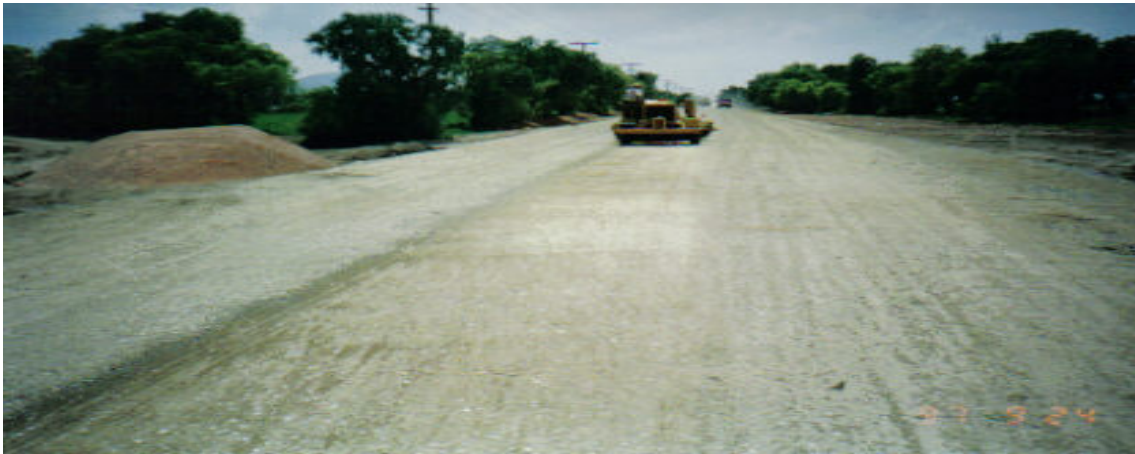
Ilustración No. VI. 12. Barredora mecánica, efectuando el barrido sobre la base hidráulica terminada, para recibir el riego de impregnación.
