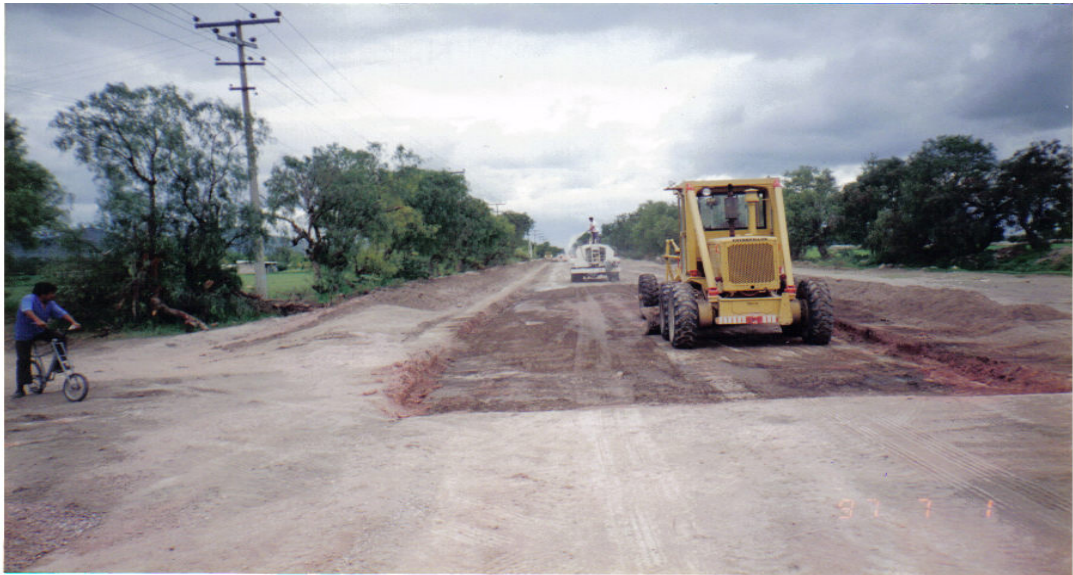
Ilustración No. VI.1-A. Ruptura y disgregado de la carpeta existente para su futura utilización en el proceso constructivo del pavimento nuevo.
