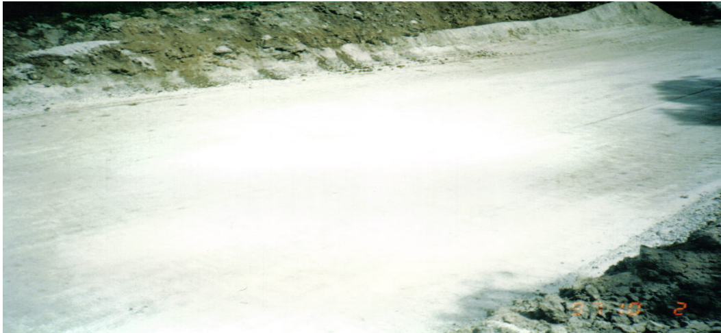
Ilustración No.VI.42. Capa de capilaridad formada con cal sobre piedraplen para evitar corriente de fluidos y el arrastre de finos.
