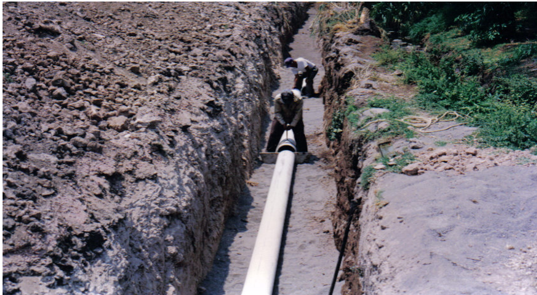
Ilustración No.VI.47. Perfil de la excavación del S.A.P. y tendido de tubería.
