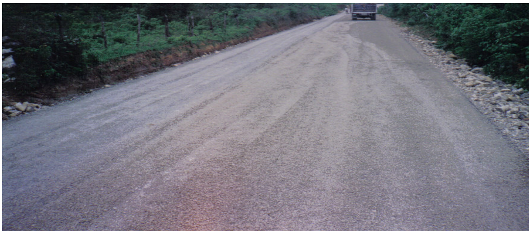
Ilustración No. VII.14. Superficie terminada del pavimento con dos riegos de sello.
