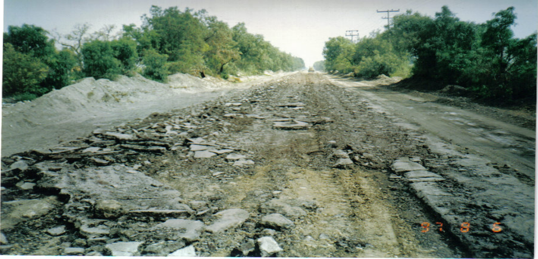
Ilustración No. VI.1-A. Ruptura y disgregado de la carpeta existente para su futura utilización en el proceso constructivo del pavimento nuevo.
