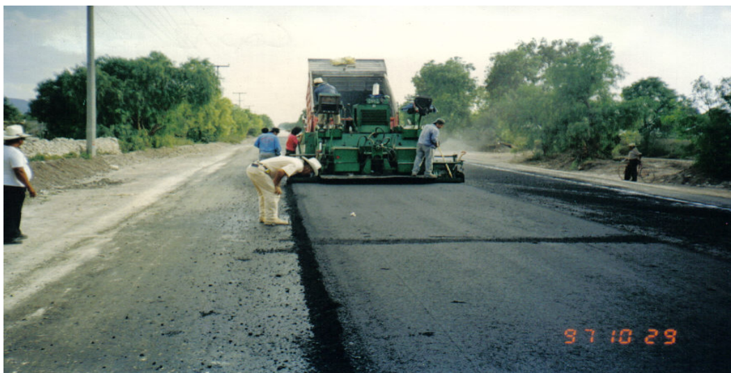
Ilustración No. IV. 15. Extendedora de asfalto o Finisher, utilizada para tendido de carpeta asfáltica en caliente.
