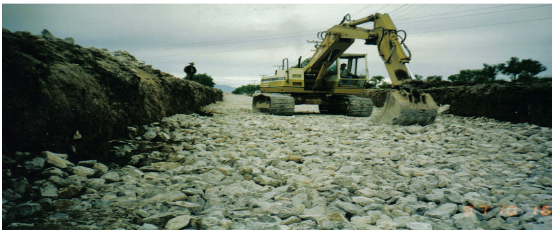
Ilustración No.VI.37. Compactación de piedraplen en falla geológica.
