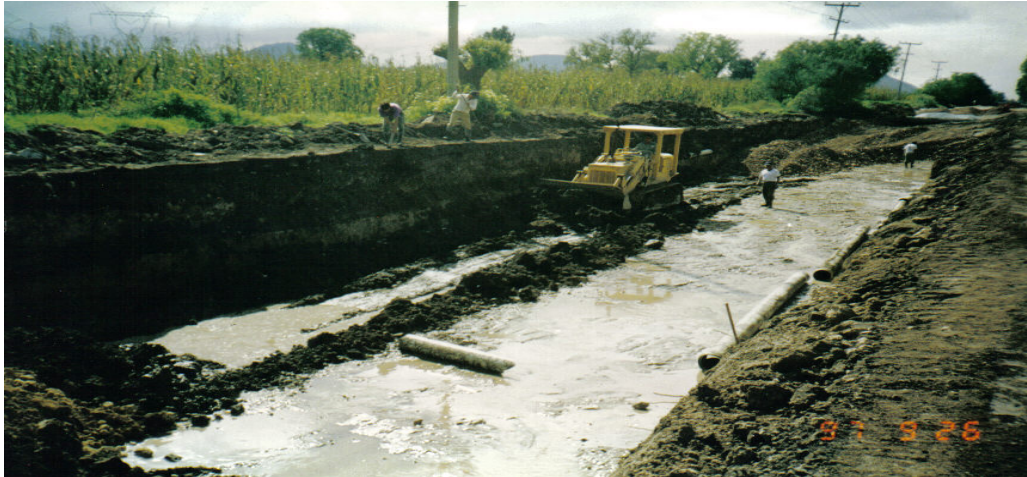
Ilustración No.VI.38. Nivel de piso firme en falla geológica.
