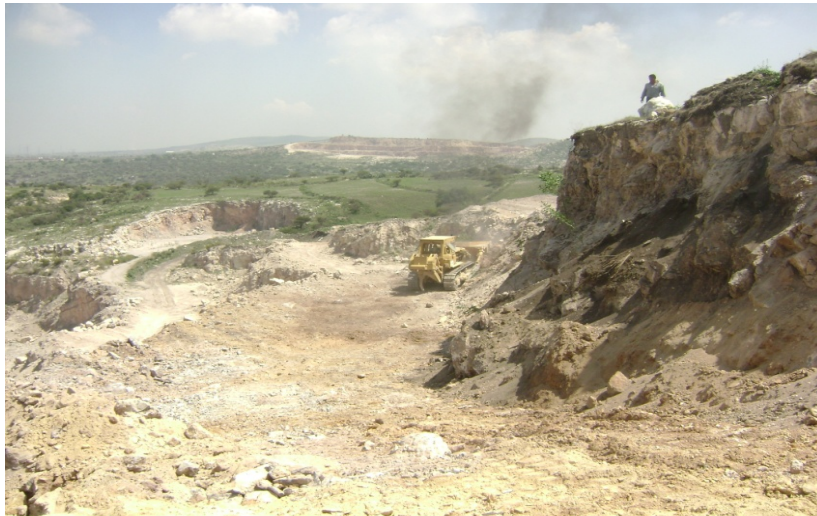
Ilustración No. III.4. Tractor sobre orugas aflojando material pétreo aprovechable para sub-bases, bases y carpetas.
