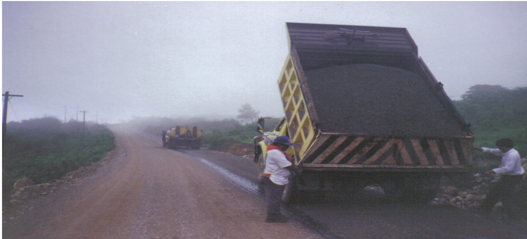
Ilustración No. VII.12. Tendido del primer riego de sello 3-A.
