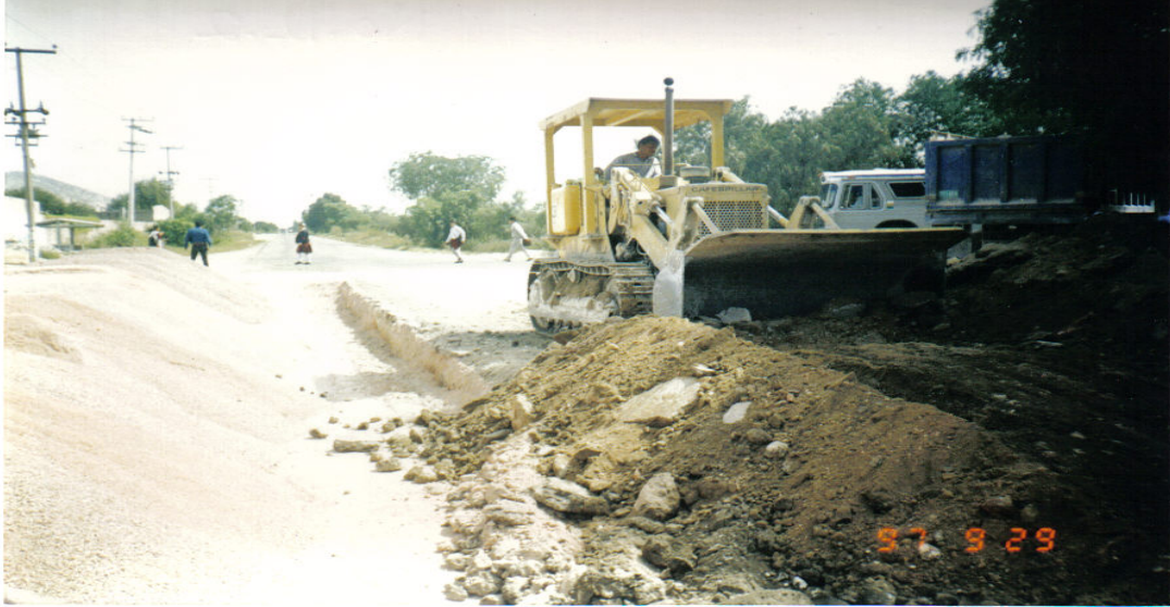
Ilustración No. IV.2. Traxcavo o cargador montado sobre orugas realizando cortes y acumulación de materiales para su posterior descarga en volteos.
