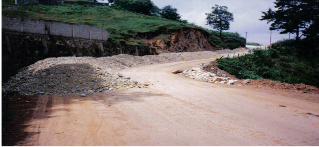
Ilustración No. VII. 6. Suministro de material para base hidráulica.
