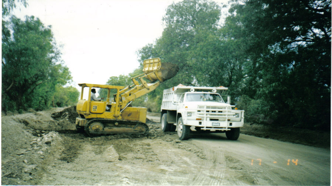
Ilustración No. IV. 4. Traxcavo haciendo operaciones de carga.
