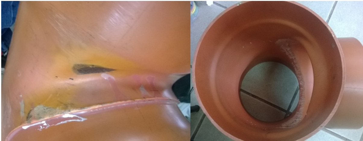
Figura 5.4: Acercamiento a la reducción de diámetro.
