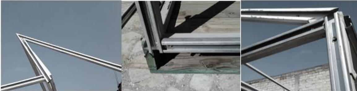
Figura 3.10. Colocación del perfil C.
