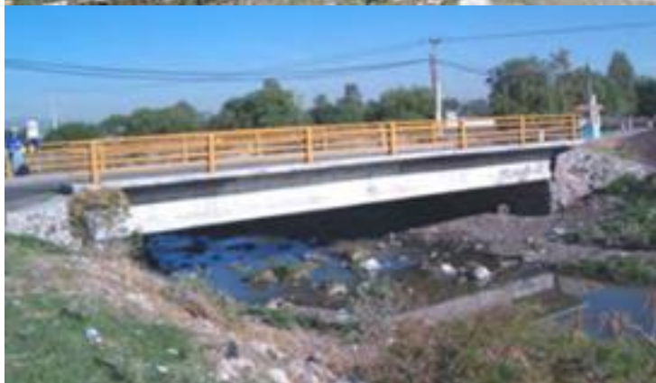
Figura 1.4. Cauce de alivio del Río Querétaro en su cruce con el puente de acceso al poblado de Santa María Magdalena. (Foto tomada en sitio)
