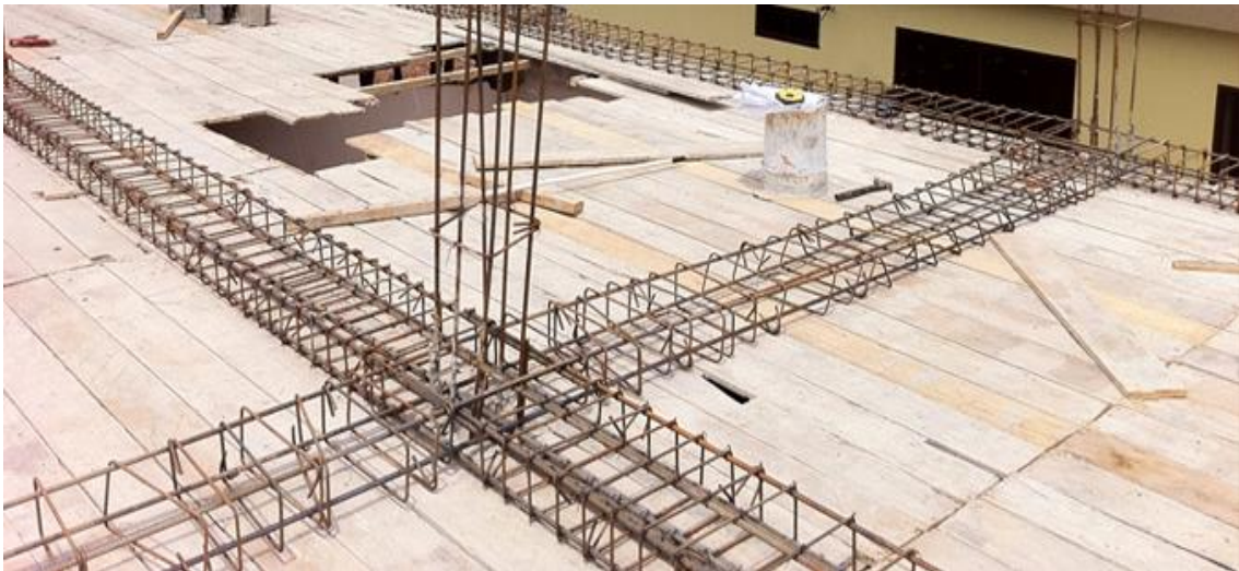
*Fotografía tomada en el sitio, Apango, Estado de Guerrero.
