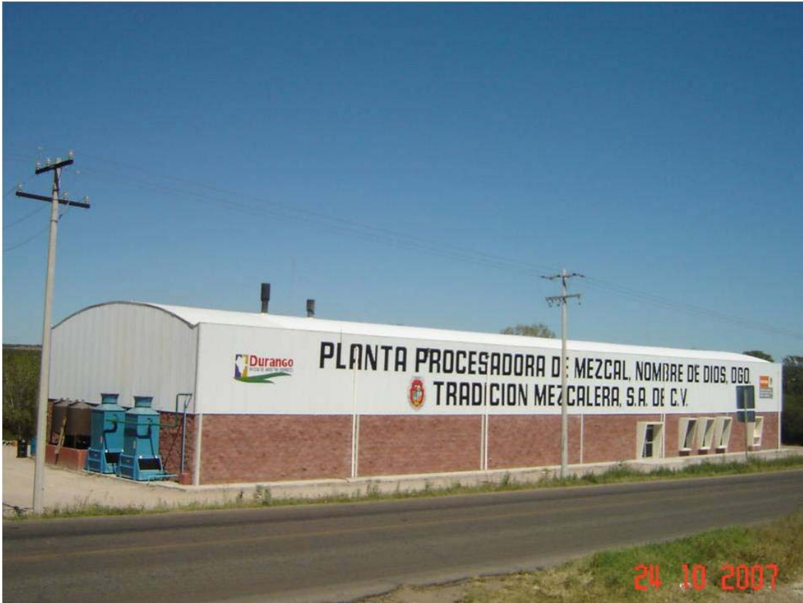
Figura 2. Planta procesadora de mezcal de Nombre de Dios, Durango, México. (Fotografía: Vicente Hernández Vargas)
