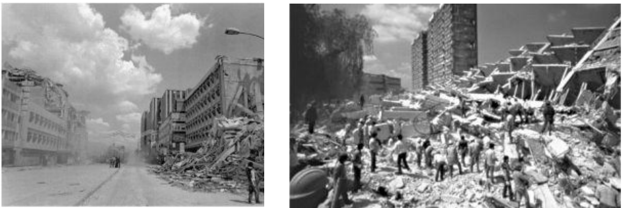
Imagen 22. Consecuencias del terremoto en 1986
