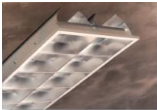
Fig. 2.7 Difusor parabólico de aluminio
