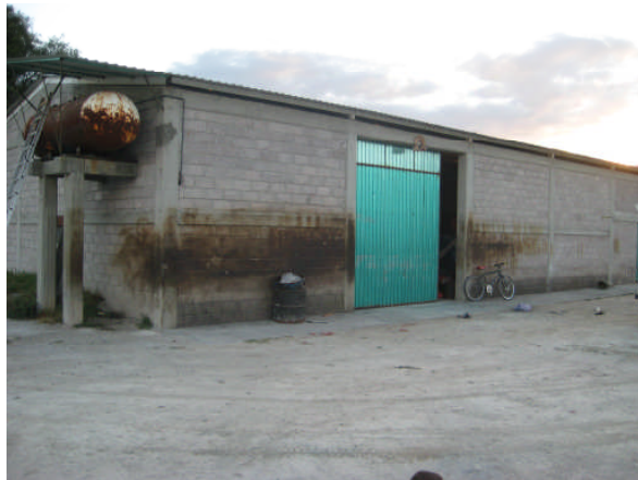
A) Instalaciones Empresa COLMAR
