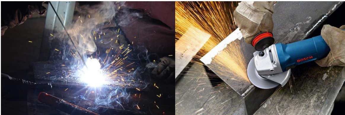
Figura A1. 5. Soldando y esmerilado de las láminas de acero.
