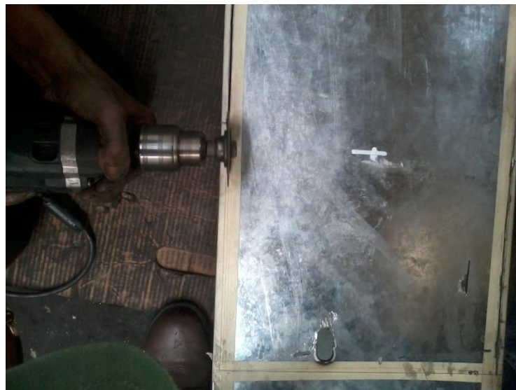
Figura A1. 23. Corte de ducto utilizando disco de corte.
